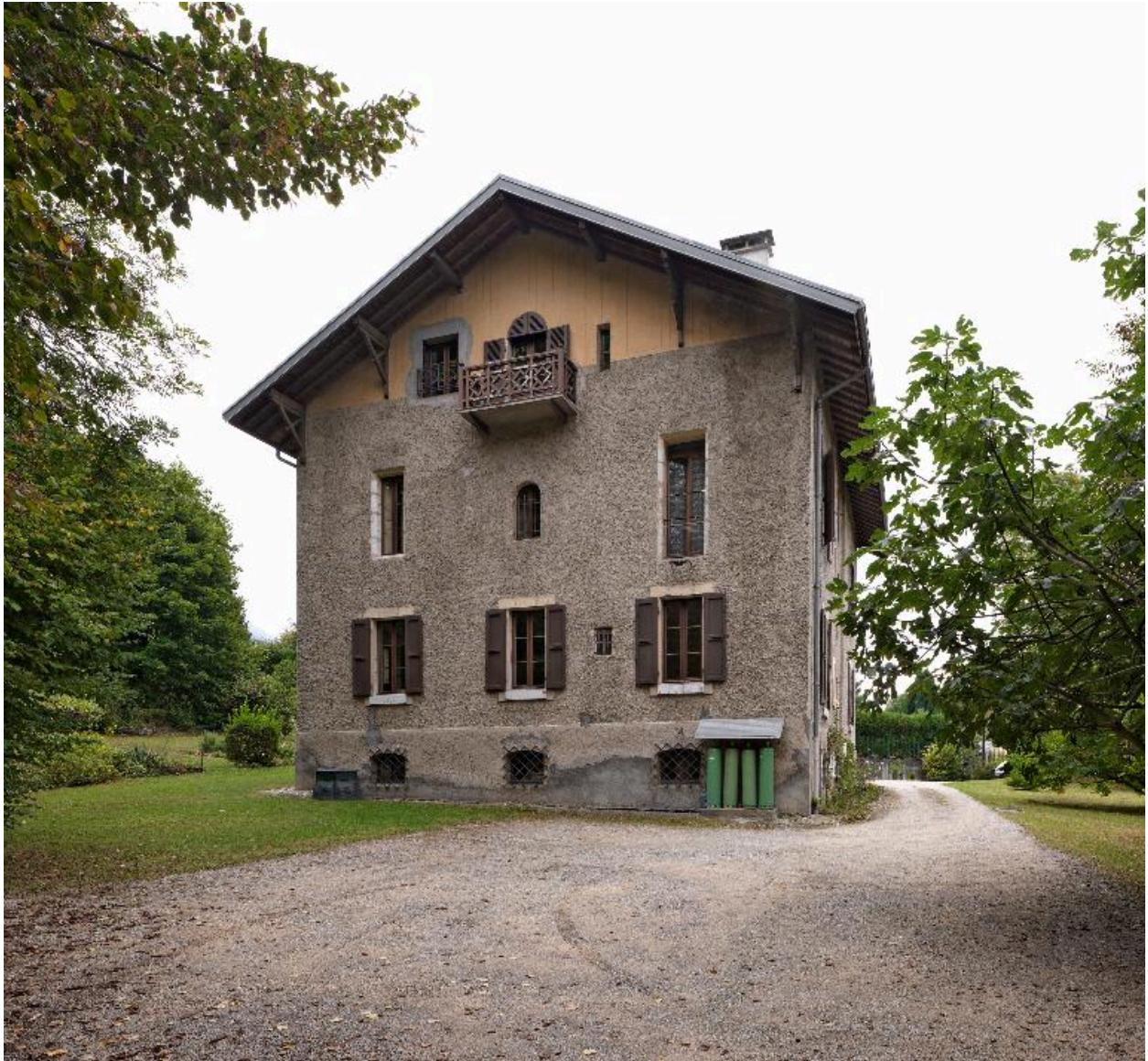
Vue d'ensemble du mur pignon nord de la maison.
