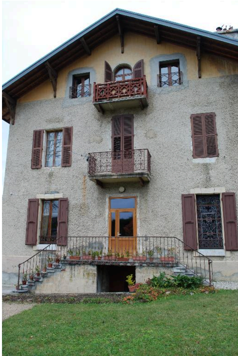
Vue d'ensemble du mur pignon sud.
