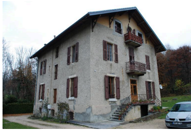
Vue d'ensemble de trois-quarts avant gauche de la maison. Phot. Thierry Monnet IVR84_20177301940NUCA
