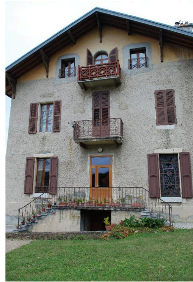
Vue d'ensemble du mur pignon sud. Phot. Thierry Monnet IVR84_20177301941NUCA
