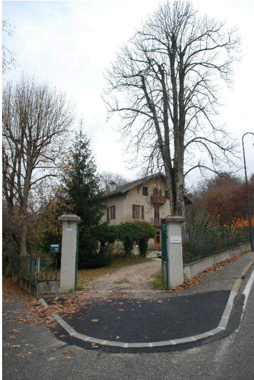
Vue d'ensemble du portail de la maison.
