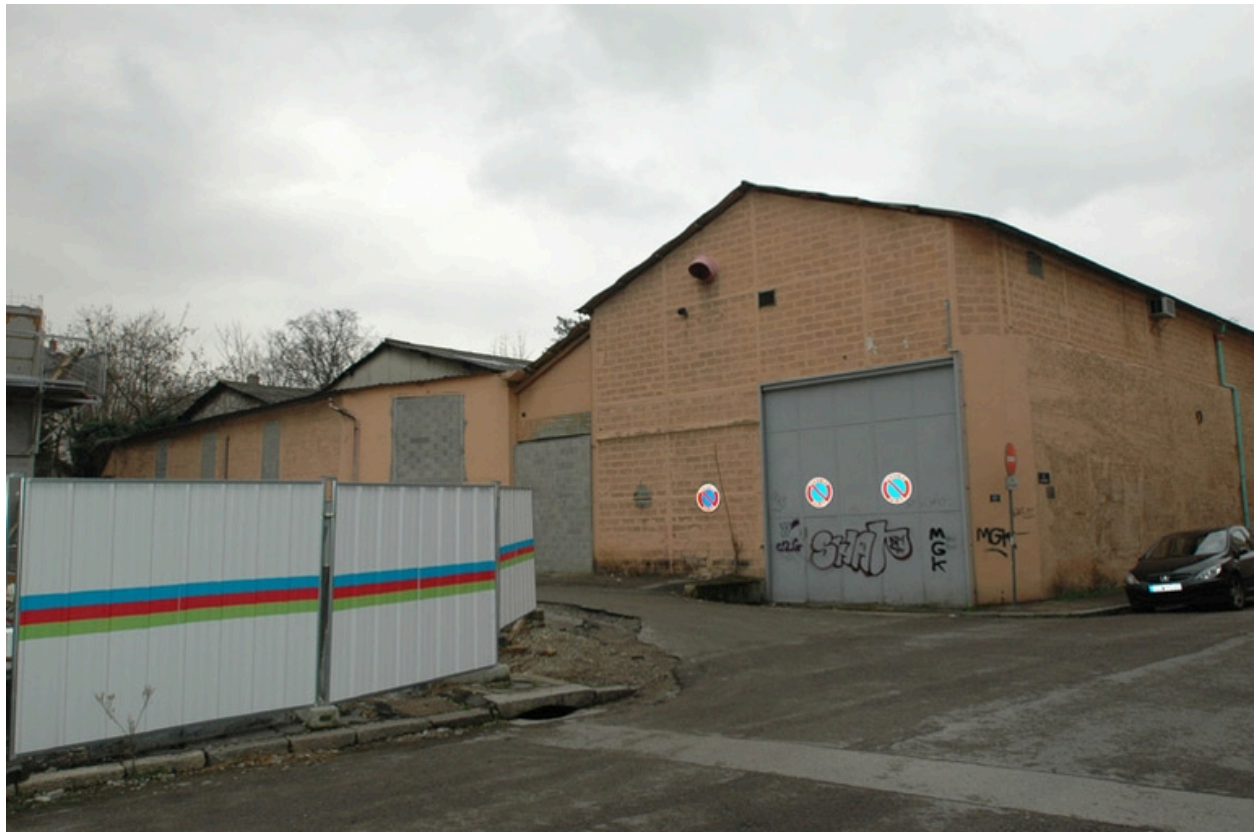
Vue extérieure, angle nord est
