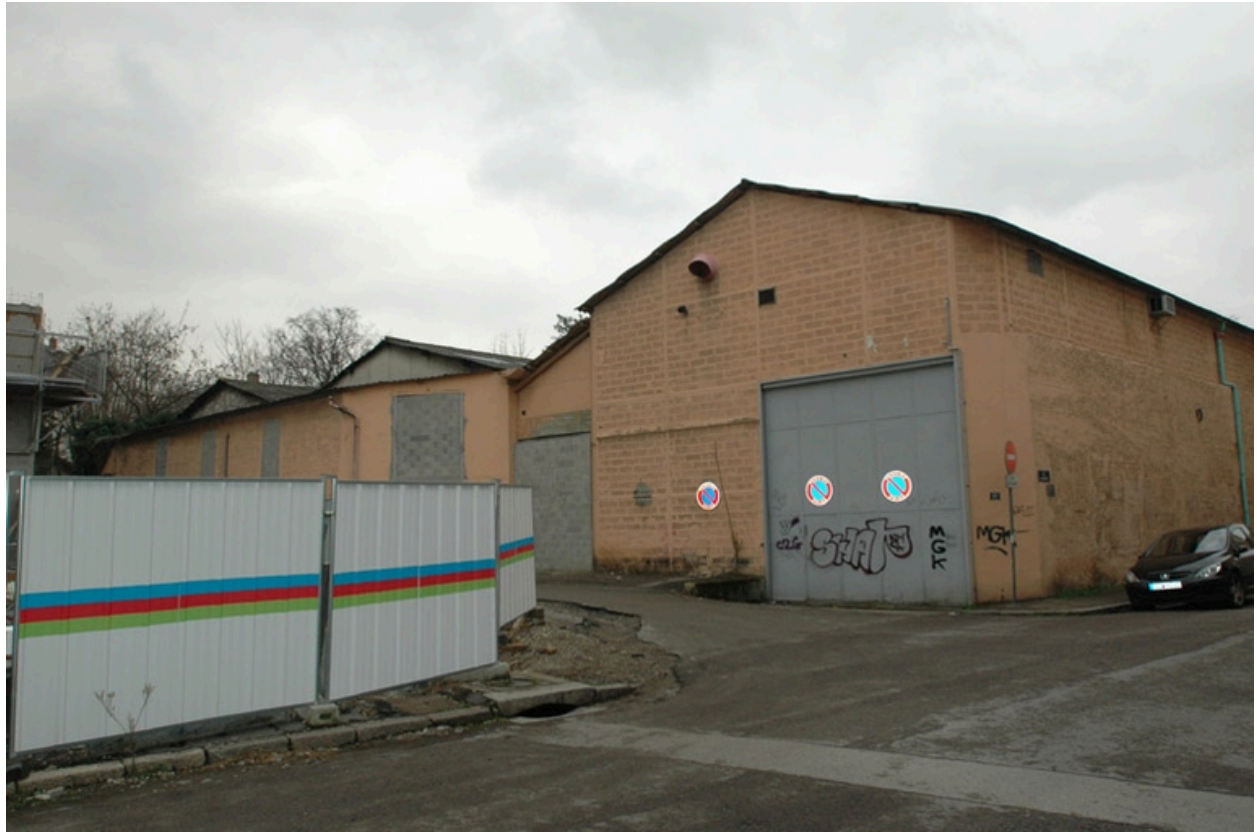
Vue extérieure, angle nord est
