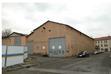
Façade extérieure ouest. Vue nord Phot. Nadine Halitim-Dubois IVR82_20096901728NUCA
