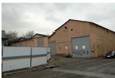
Vue extérieure, angle nord est Phot. Nadine Halitim-Dubois IVR82_20096901729NUCA
