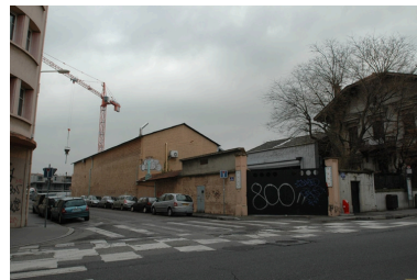
Vue générale du site. Vue ouest Phot. Nadine Halitim-Dubois IVR82_20096901727NUCA
