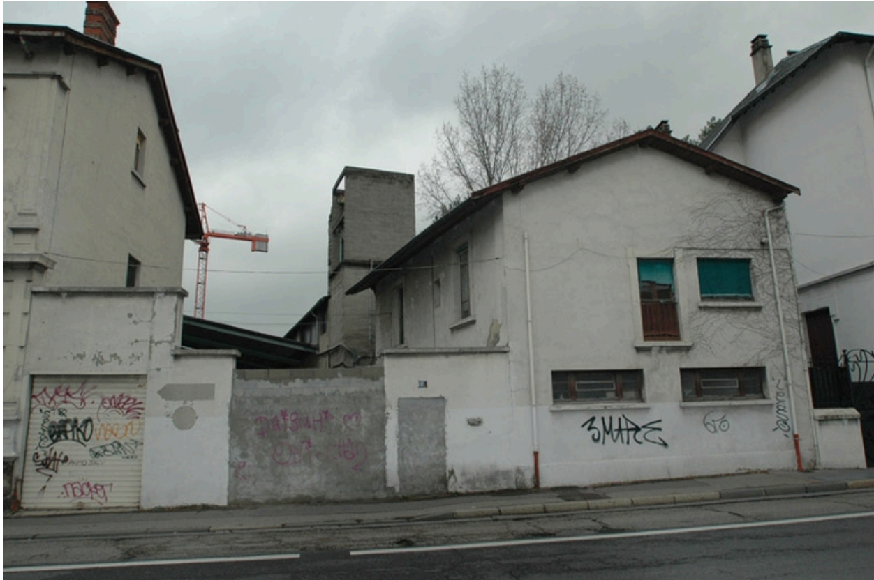
Façade sud : détail d'une ancienne l'entrée. Vue sud
