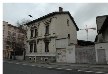
Façade sud : vue de la villa sur l'avenue Lacassagne Phot. Nadine Halitim-Dubois IVR82_20096901725NUCA
