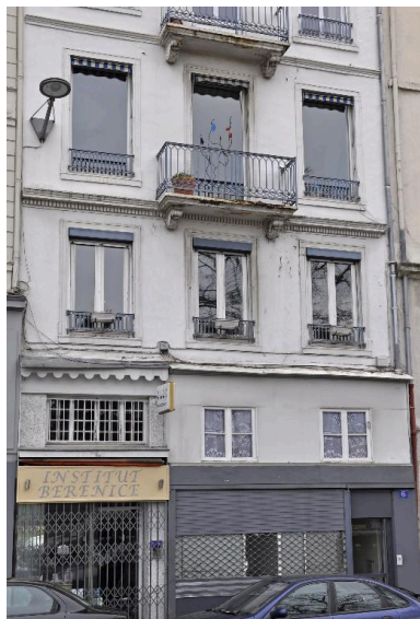
Vue partielle de l'élévation sur rue, partie inférieure Phot. Magali Delavenne IVR84_20166900630NUCA
