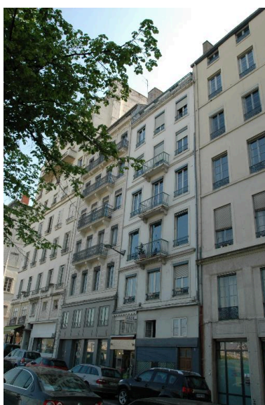
Immeuble sur rue, élévation antérieure Phot. Catherine Guillot IVR82_20136900093NUCA
