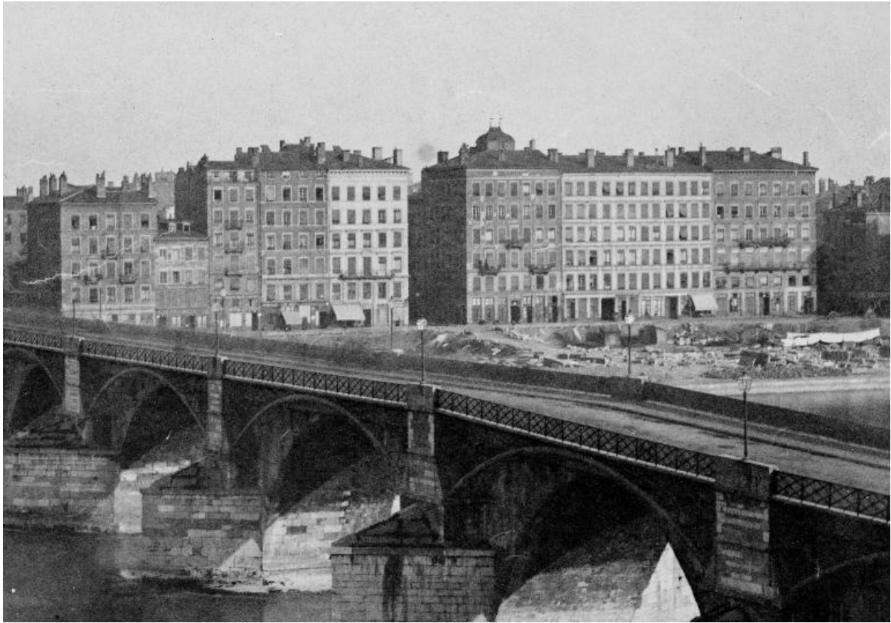
Vue de l'immeuble en 1857, détail du panorama photographique de René-Félix Baumers (AC Lyon 84 PH)
