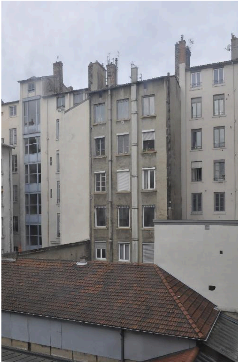
Immeuble sur cour, élévation postérieure
