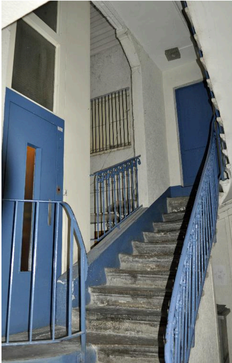
Départ de l'escalier à cage ouverte : première révolution à deux volées
