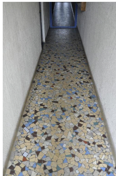
Vue intérieure : pavement de l'allée Phot. Magali Delavenne IVR84_20166900632NUCA
