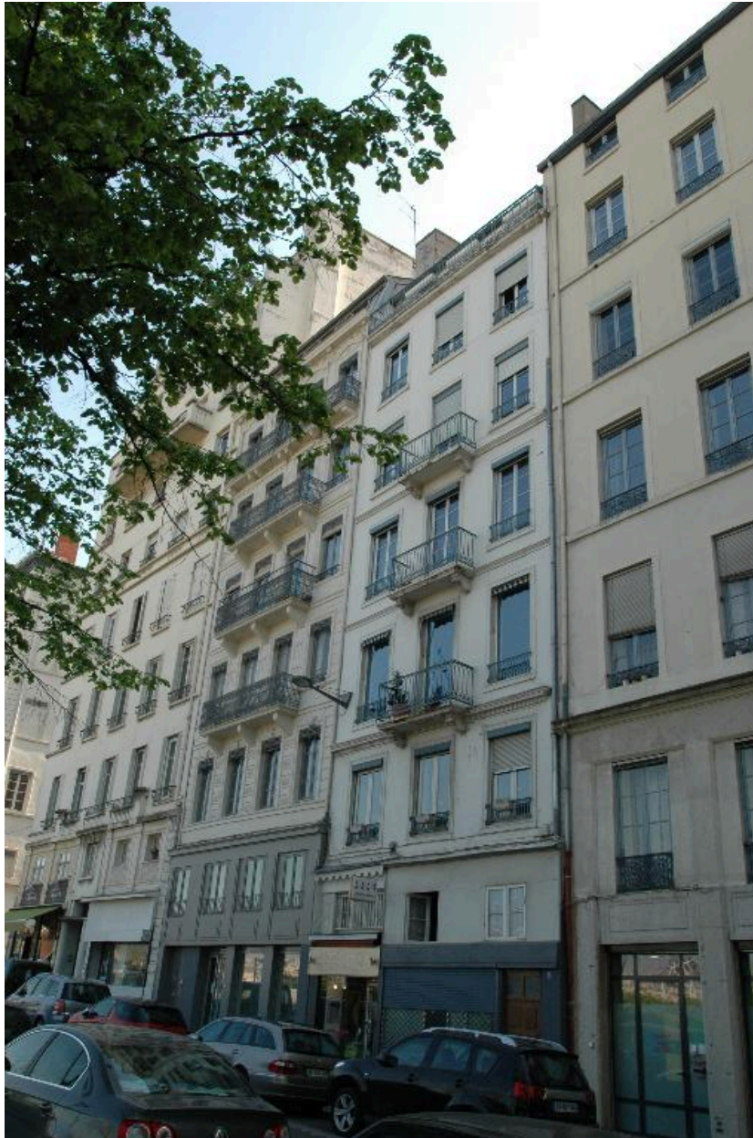
Immeuble sur rue, élévation antérieure
