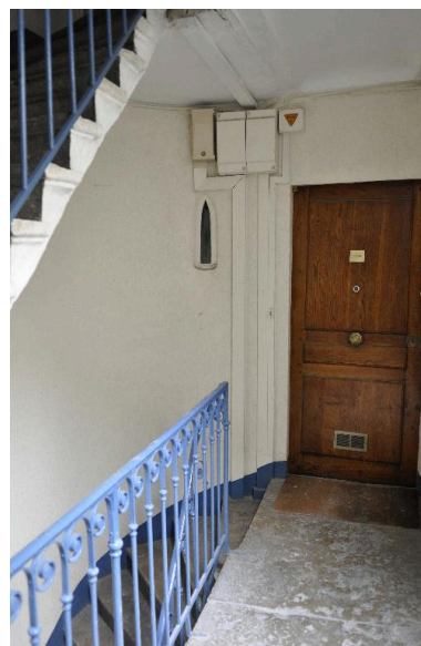
Palier de l'escalier Phot. Magali Delavenne IVR84_20166900634NUCA
