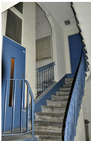
Départ de l'escalier à cage ouverte : première révolution à deux volées Phot. Magali Delavenne IVR84_20166900633NUCA
