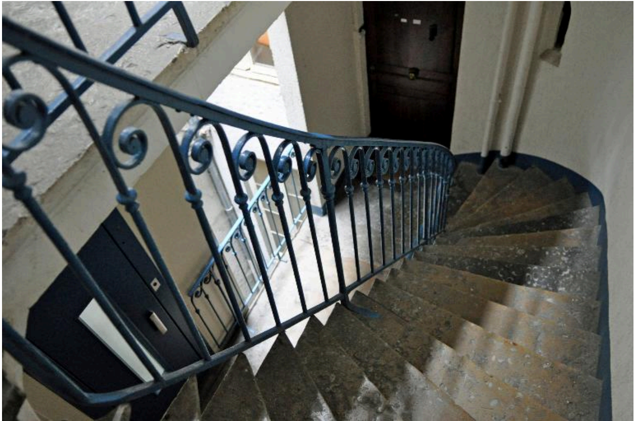
Escalier à une volée droite au-delà du premier étage
