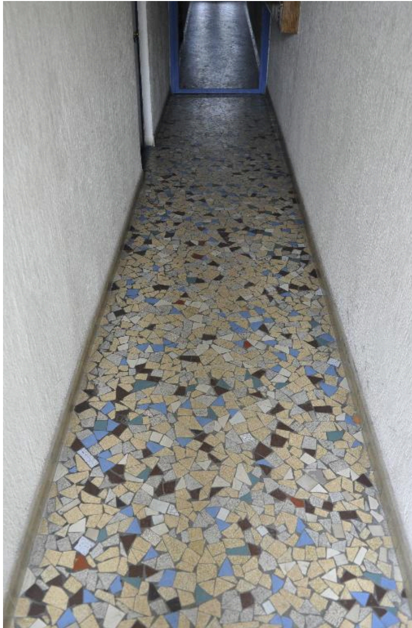
Vue intérieure : pavement de l'allée
