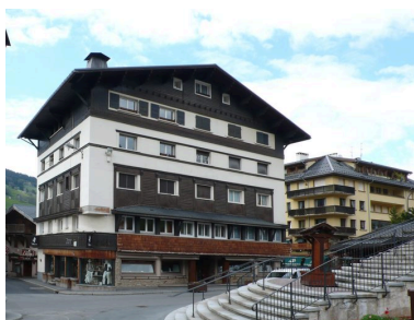
Vue d'ensemble depuis le sud-est. Etat actuel Phot. Jean-François Lyon-Caen IVR82_20127401601NUCA
