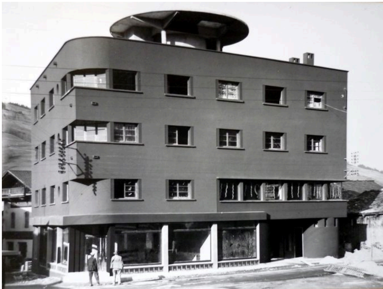
Megève. L'hôtel Albert 1er en travaux. Photogr. Tops Socquet Megève, [vers 1930] (AD Haute-Savoie. 142 J 608)
