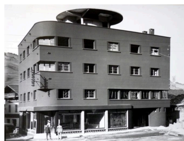
Megève. L'hôtel Albert 1er en travaux. Photogr. Tops Socquet Megève, [vers 1930] (AD Haute-Savoie. 142 J 608) Phot. M. Chalabi__, Autr. Tops Socquet Megève (photographe) IVR82_20127401594NUCB
