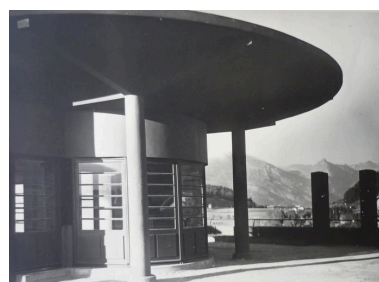
Megève. Hôtel Albert 1er . Le rouf sur la terrasse. Photogr. [milieu XXe s.] (AD Haute-Savoie. 142 J 608) Phot. M. Chalabi__ IVR82_20127401596NUCB
