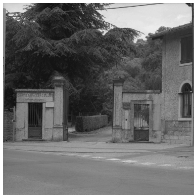
Portail d'entrée. Phot. Eric Dessert, Phot. Jean-Marie Refflé IVR82_19910100735X
