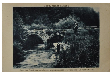
Ancien pont menant au site (© Collection particulière M.-A. Podevin). IVR84_20177300824NUCA
