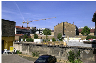
Vue de l'immeuble Le Bellini en construction depuis l'est Phot. Lore Derail IVR82_20036900443NUCA
