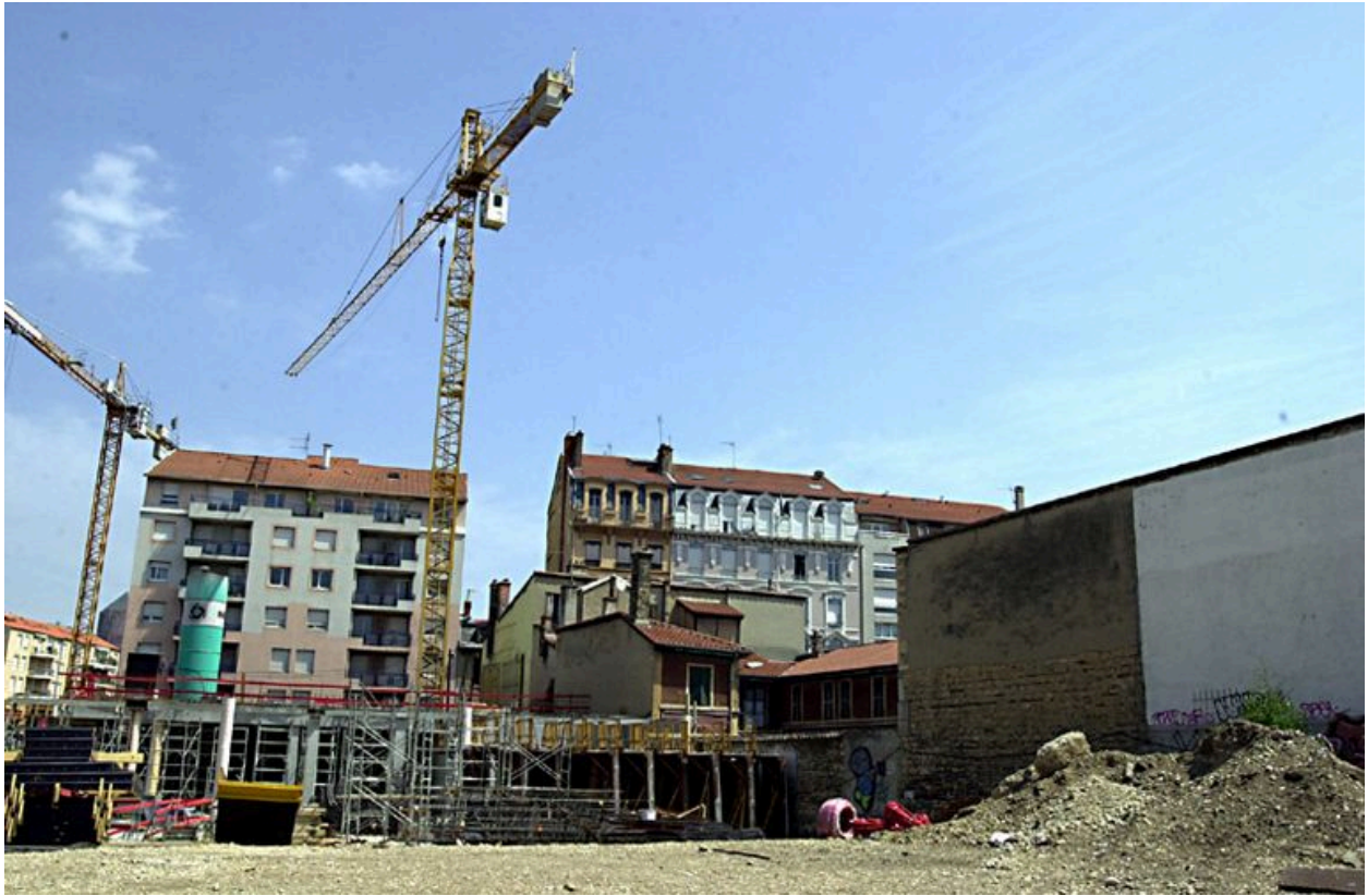
Vue du chantier du Bellini depuis le sud
