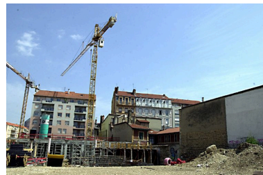
Vue du chantier du Bellini depuis le sud Phot. Lore Derail IVR82_20036900445NUCA
