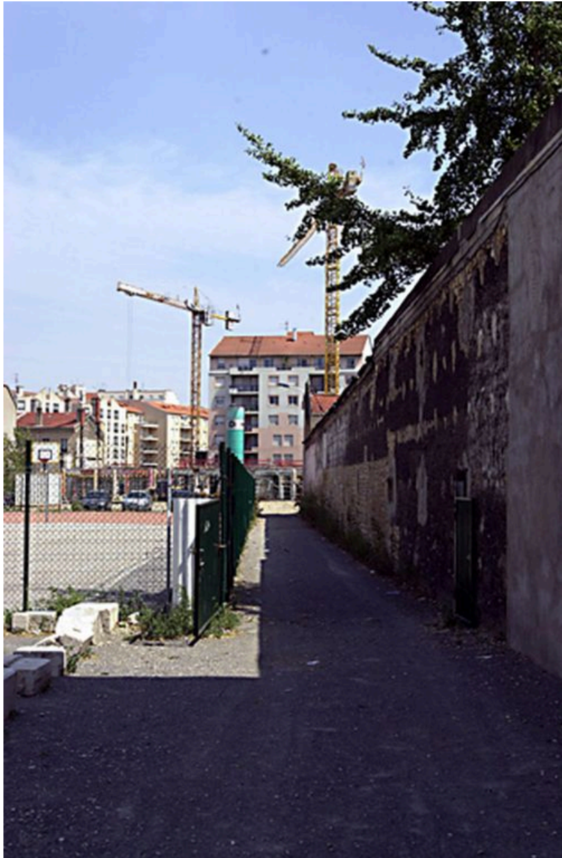
Vue du passage vers le chantier du Bellini depuis le 19 rue du Béguin
