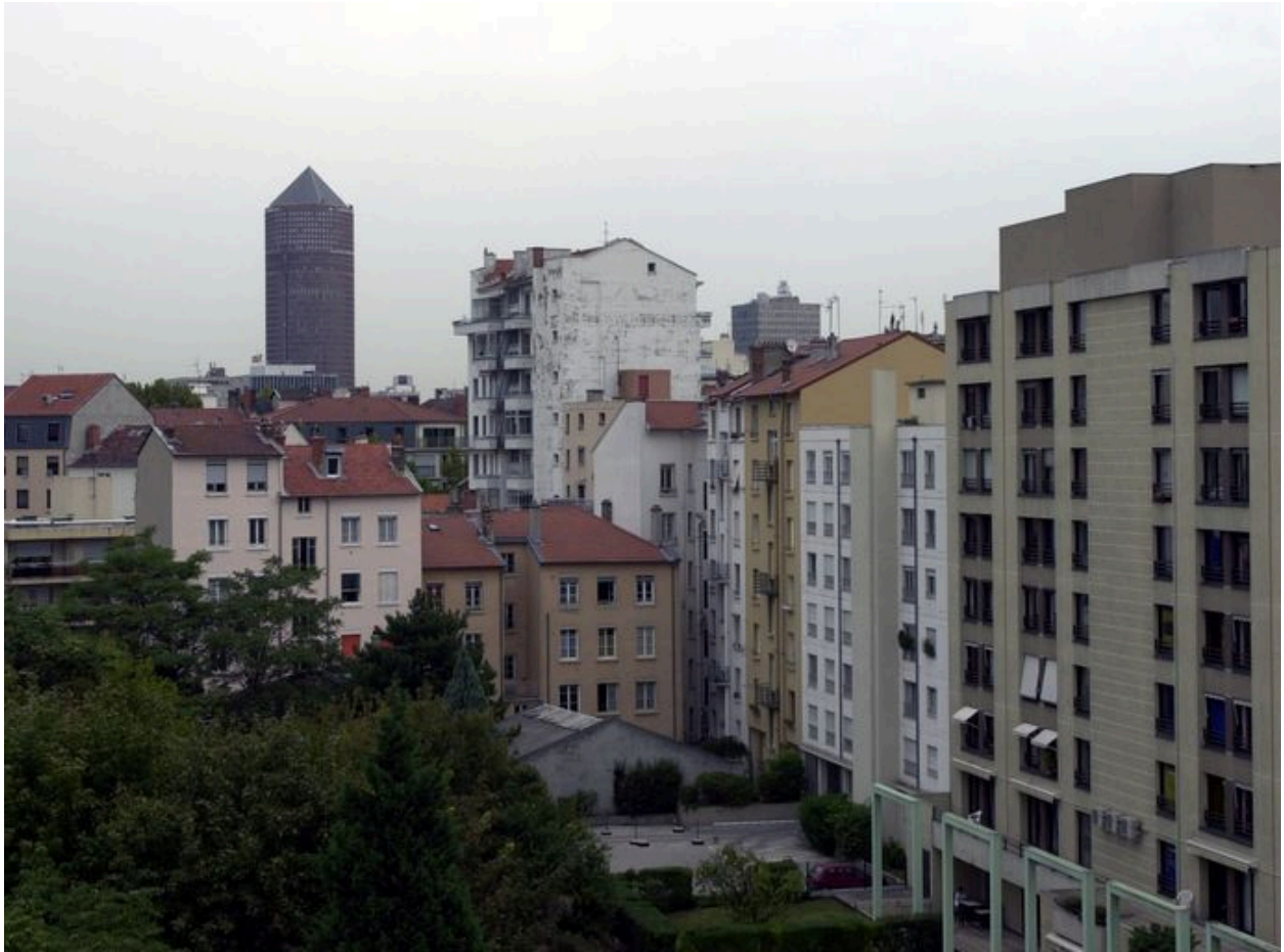
Vue générale des élévations postérieures des immeubles 338,340 et 342 rue André-Philip
