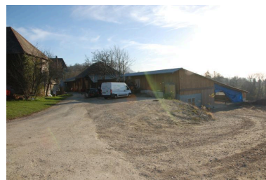
Vue de la grange-étable. Phot. Caroline Guibaud IVR84_20197400626NUCA
