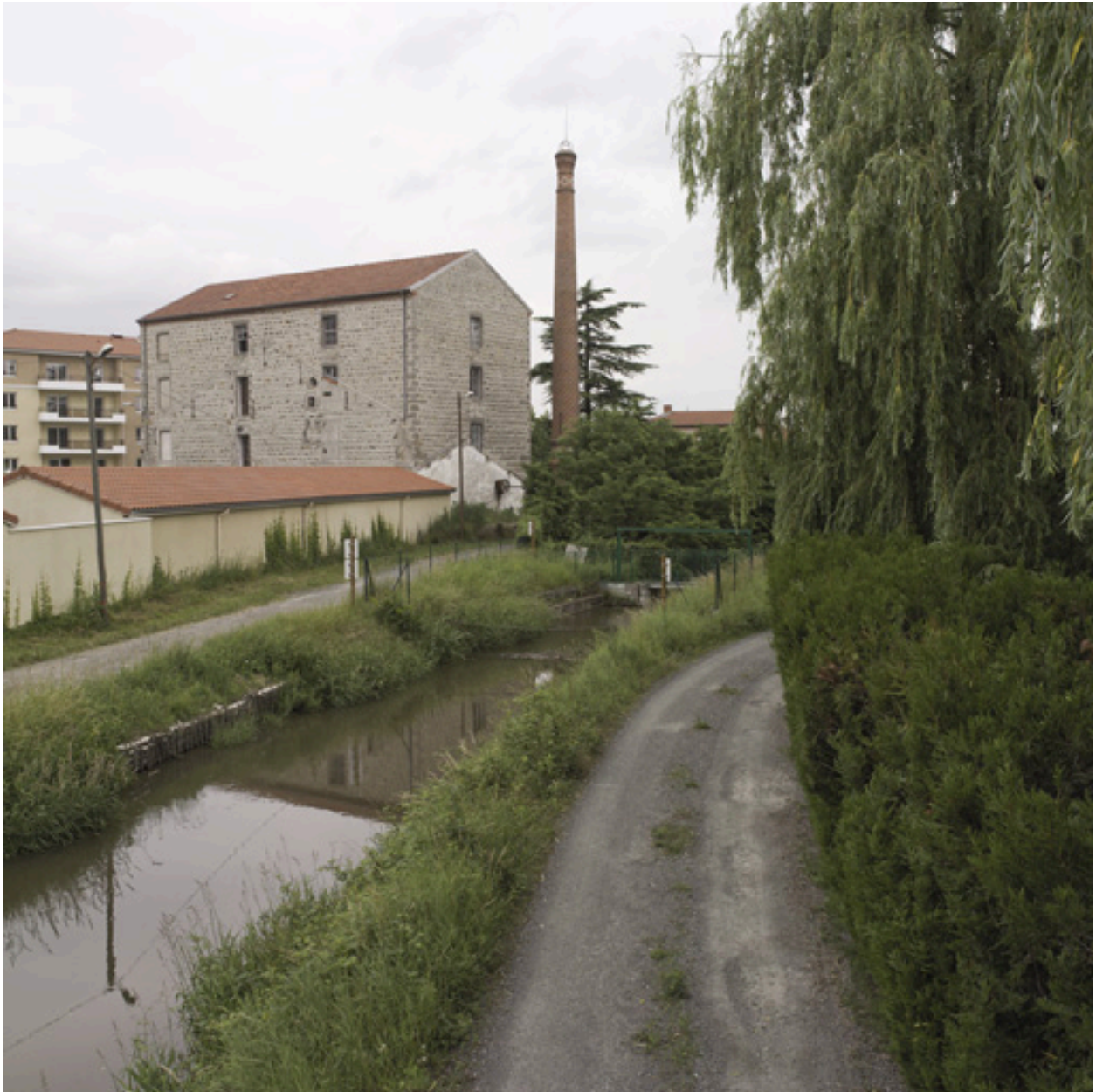
Vue générale arrière du bâtiment de production et de la cheminée (en 2008).
