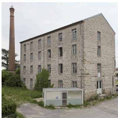
Vue d'ensemble du bâtiment de production et de la cheminée (en 2008). Phot. Eric Dessert IVR82_20084200888NUCA
