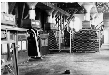
Vues intérieures de la minoterie Peyer. Salle des appareils de mouture. Repro. Eric Dessert IVR82_20084200910NUCB
