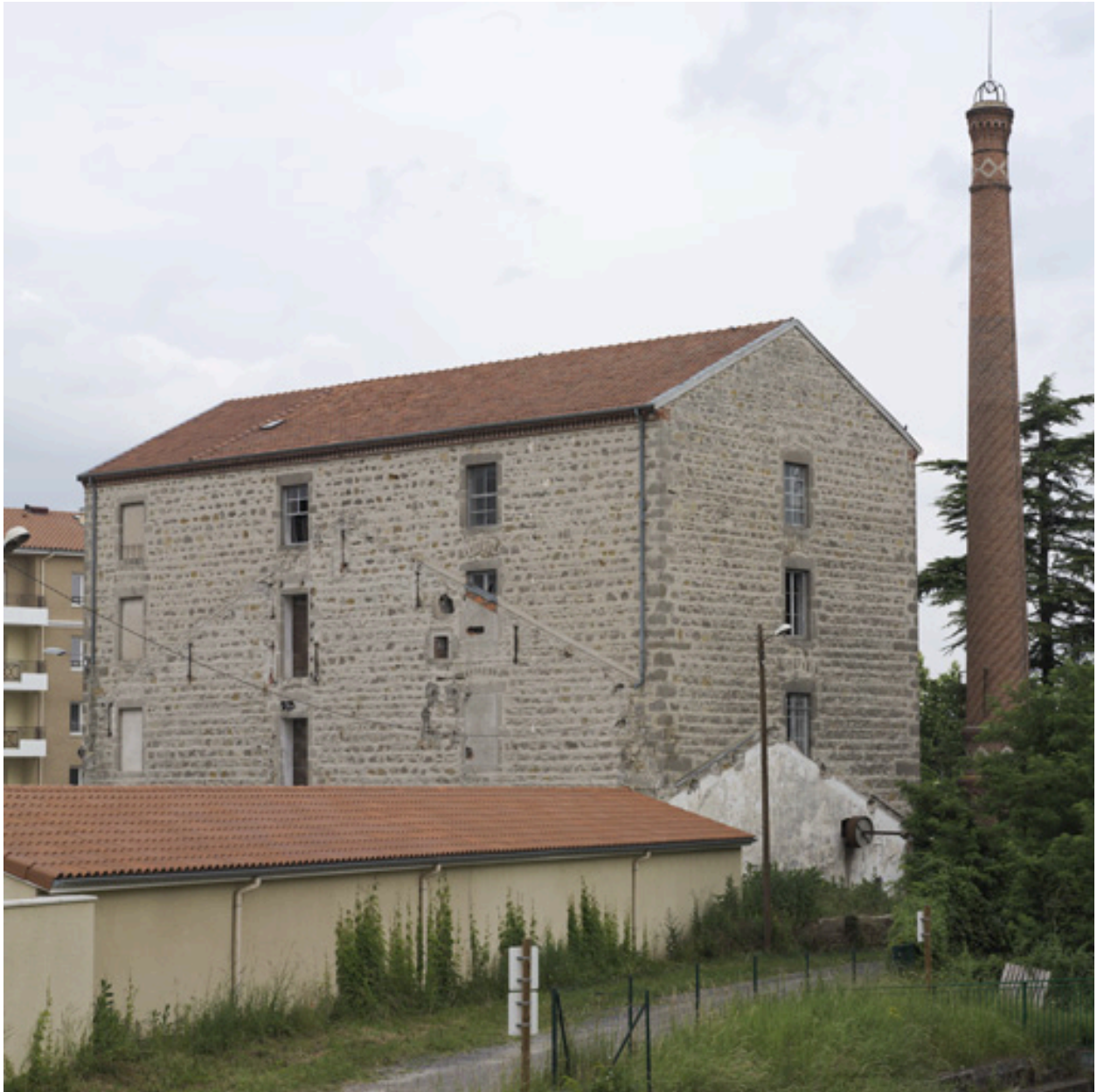
Vue arrière du bâtiment de production et de la cheminée (en 2008).
