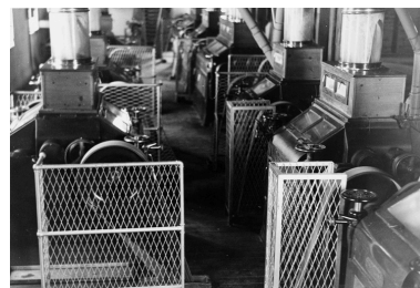
Vues intérieures de la minoterie Peyer. Salle des appareils de mouture. Repro. Eric Dessert IVR82_20084200911NUCB
