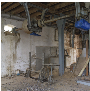
Vue intérieure du bâtiment de production : rez-de- chaussée, axe de la turbine. Phot. Eric Dessert IVR82_20084200889NUCA
