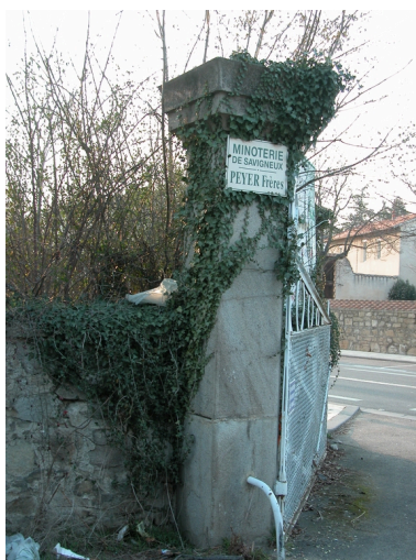
Détail d'un pilier du portail d'accès au site (en 2007).
