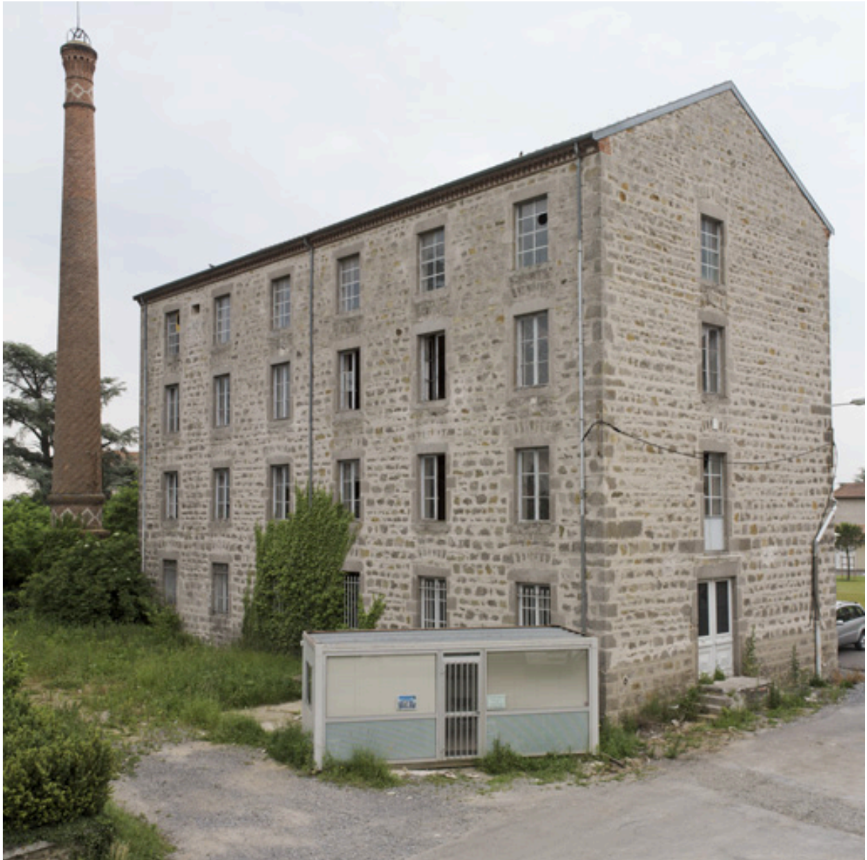
Vue d'ensemble du bâtiment de production et de la cheminée (en 2008).
