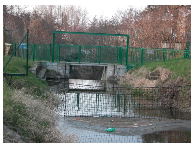
Vue de la chute d'eau du canal (vers l'aval).
