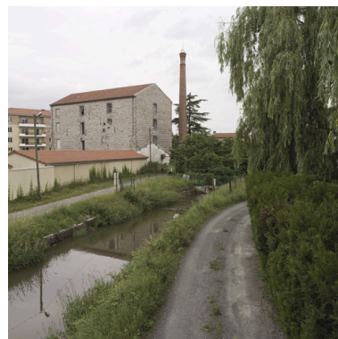
Vue générale arrière du bâtiment de production et de la cheminée (en 2008). Phot. Eric Dessert IVR82_20084200886NUCA
