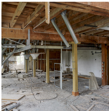
Vue intérieure du bâtiment de production : vue du 2e étage (ancien niveau des tamis).
