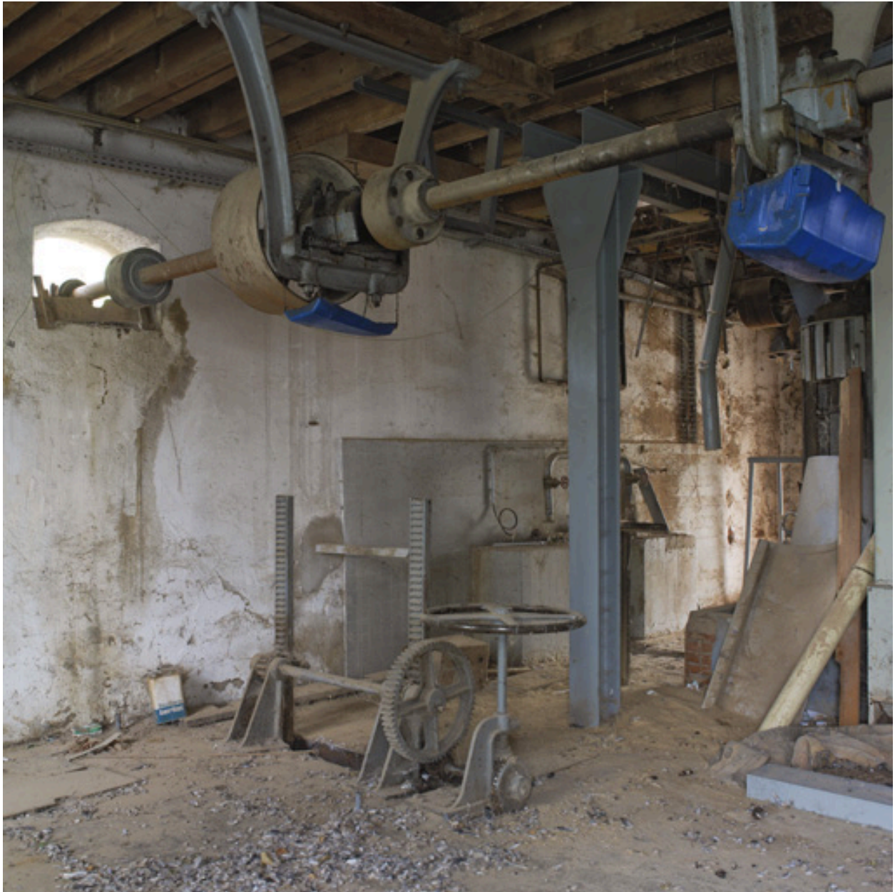
Vue intérieure du bâtiment de production : rez-de-chaussée, axe de la turbine.
