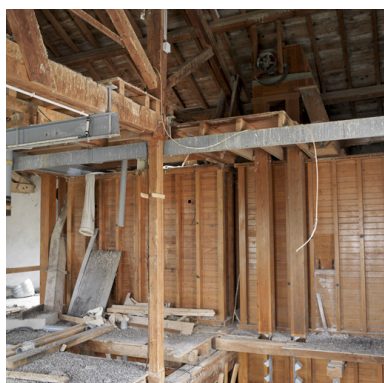
Vue intérieure du bâtiment de production : vue du 3e étage (ancien niveau des moulins).
