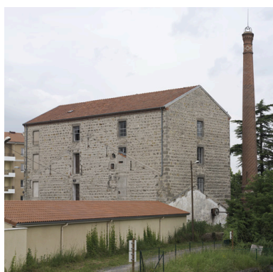
Vue arrière du bâtiment de production et de la cheminée (en 2008). Phot. Eric Dessert IVR82_20084200885NUCA
