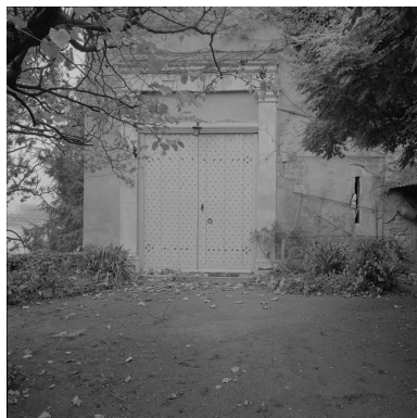
Portail de dépendance, ouvrant sur le jardin. Phot. Eric Dessert IVR82_19900100401X
