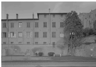
Elévation sur le quai, partie droite. Phot. Eric Dessert IVR82_19900100403P
