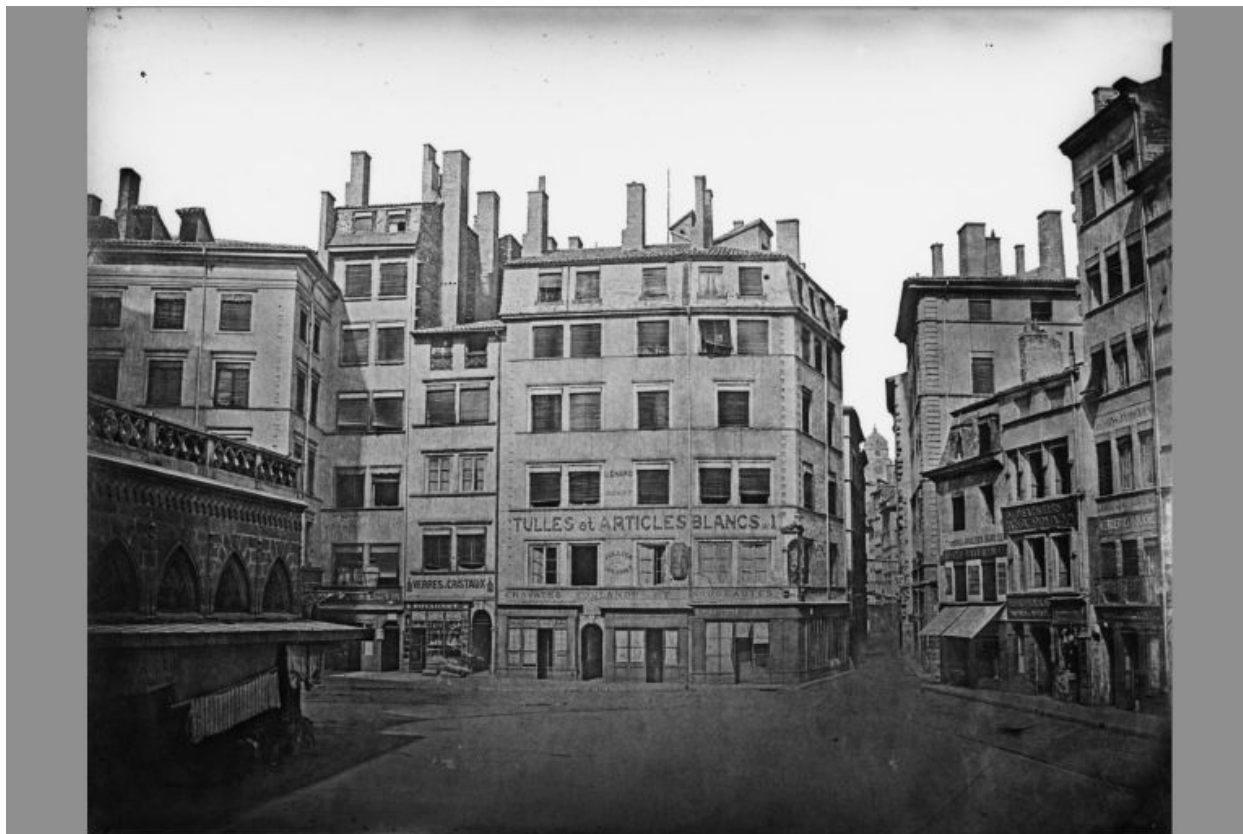
Façade l'ancien immeuble sur l'ancienne place de la Fromagerie, par Louis Froissart (?), ca 1860
