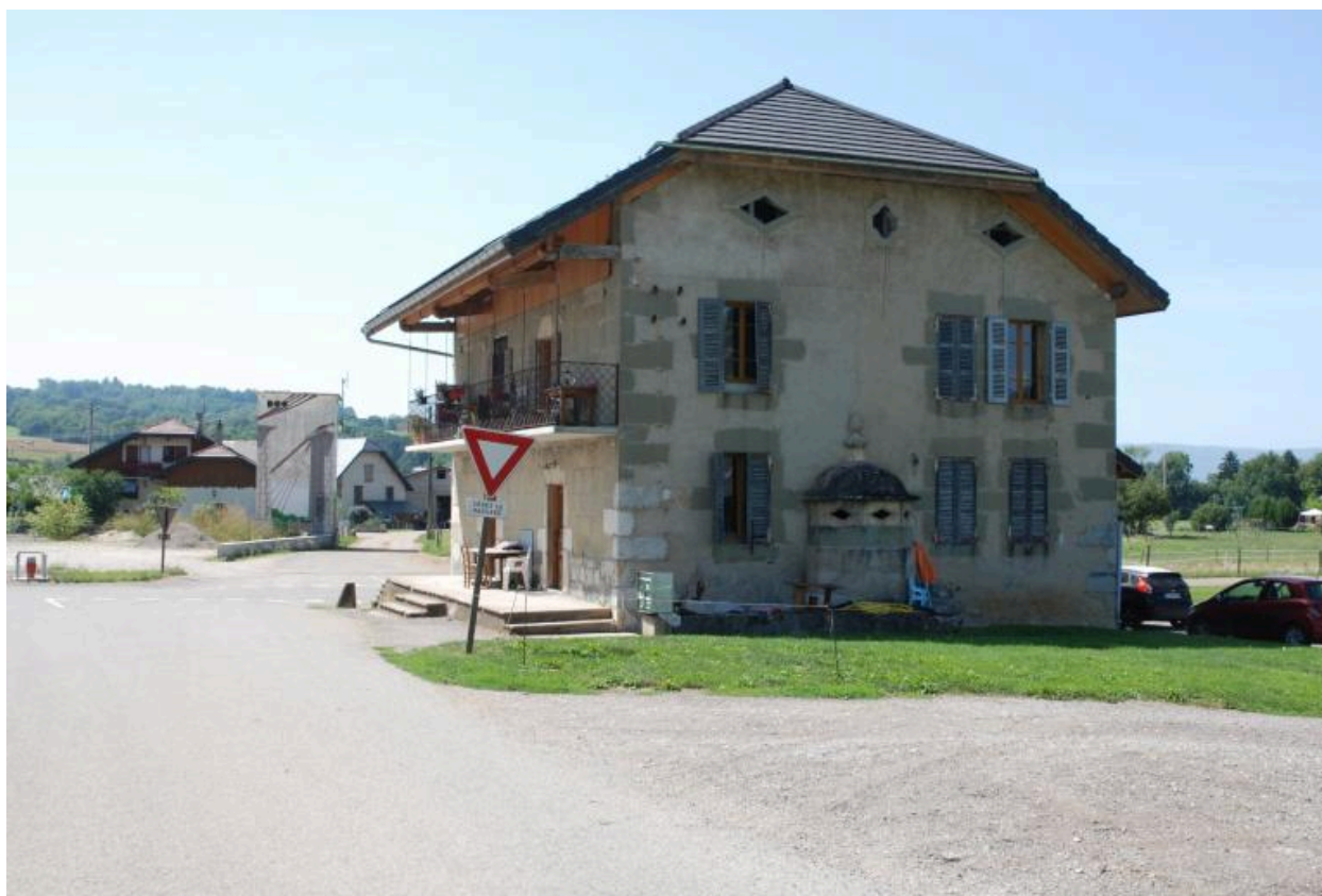
Vue d'ensemble de la maison, de trois-quarts est.
