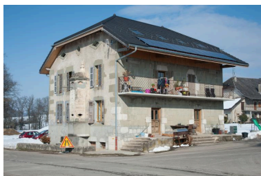
Vue d'ensemble de la maison, de trois-quarts ouest. Phot. Emmanuel Breteau
