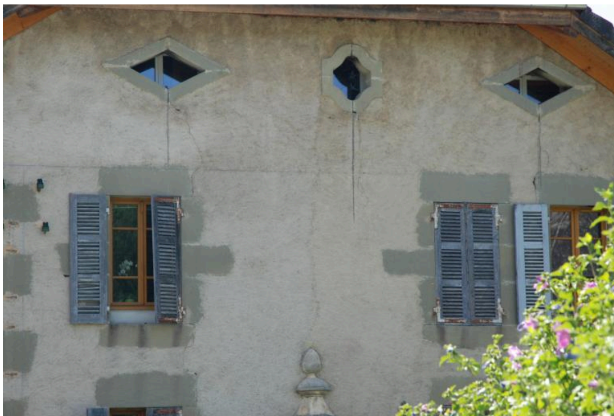
Détail des ouvertures de l'élévation est.
