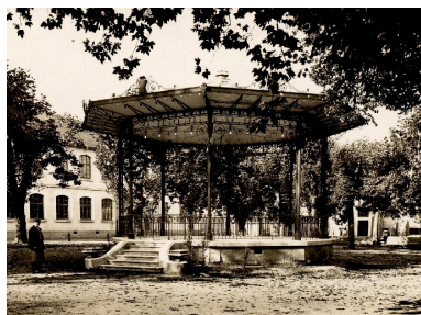
Vue générale Repro. François Fouger IVR82_20067300153NUCB
