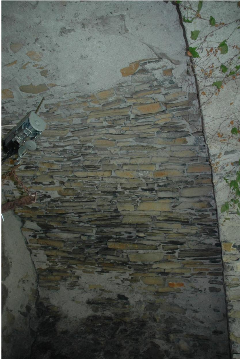
Détail du couvrement du passage couvert entre la cour et le chemin du Pré de Miolans : voûte en calcaire lité.
