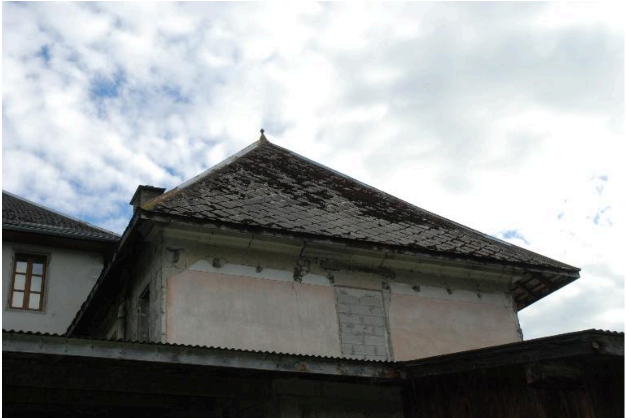
Bâtiment ouest (partie nord), détail de la façade nord : vestiges d'enduit.
