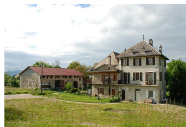
Vue générale depuis le sud-est. Phot. Thierry Monnet IVR82_20157303099NUCA
