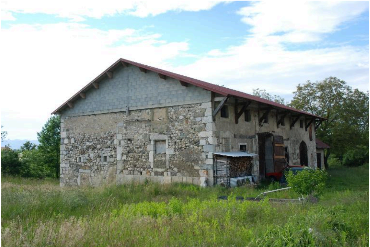
Bâtiment est, vue d'ensemble depuis le sud-est.
