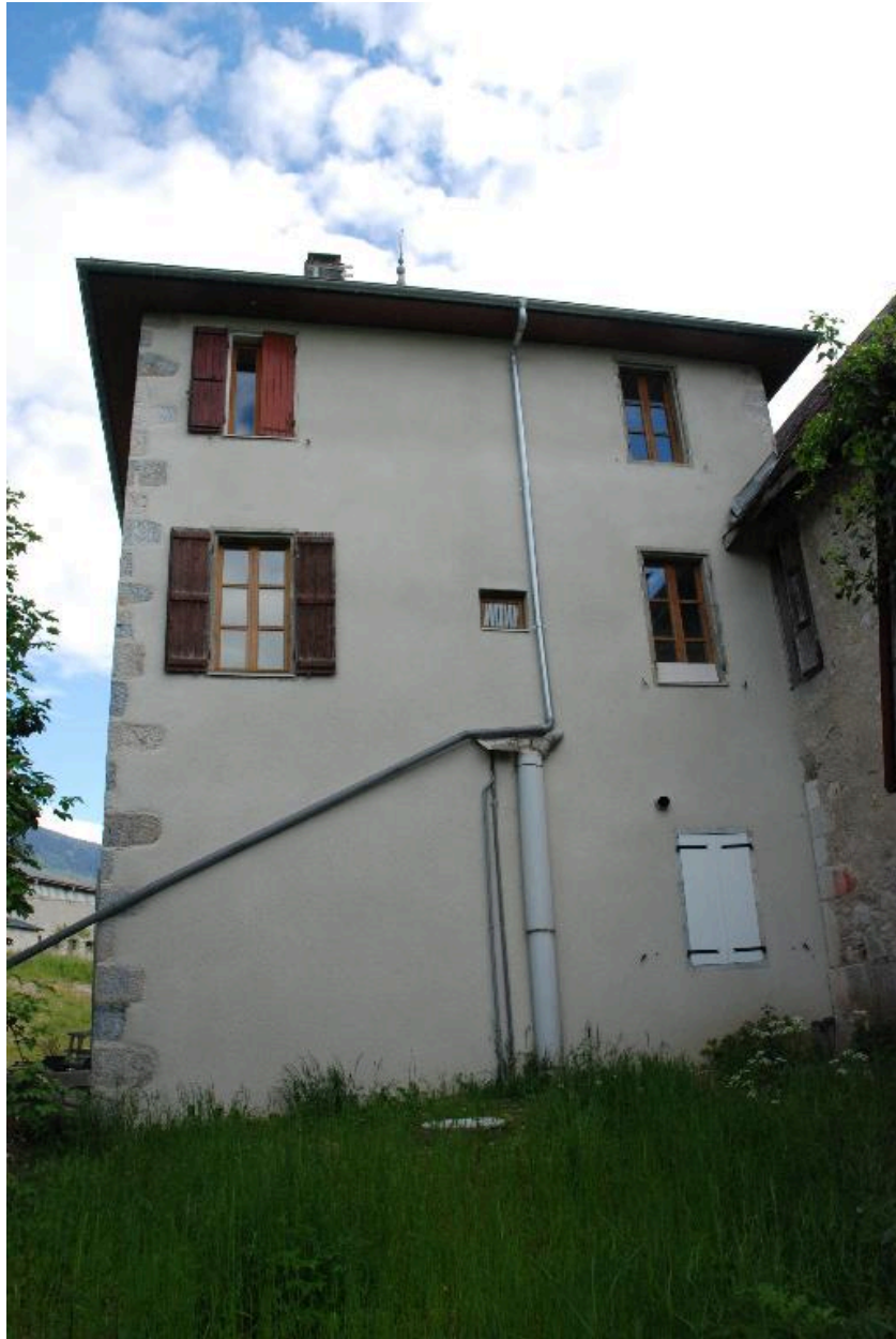
Bâtiment ouest (partie sud), vue de la façade nord.
