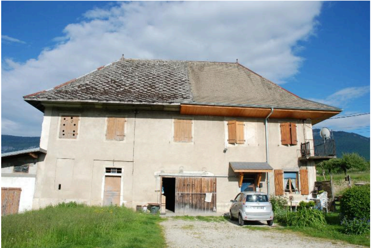
Bâtiment ouest, façade sur cour (façade ouest).
