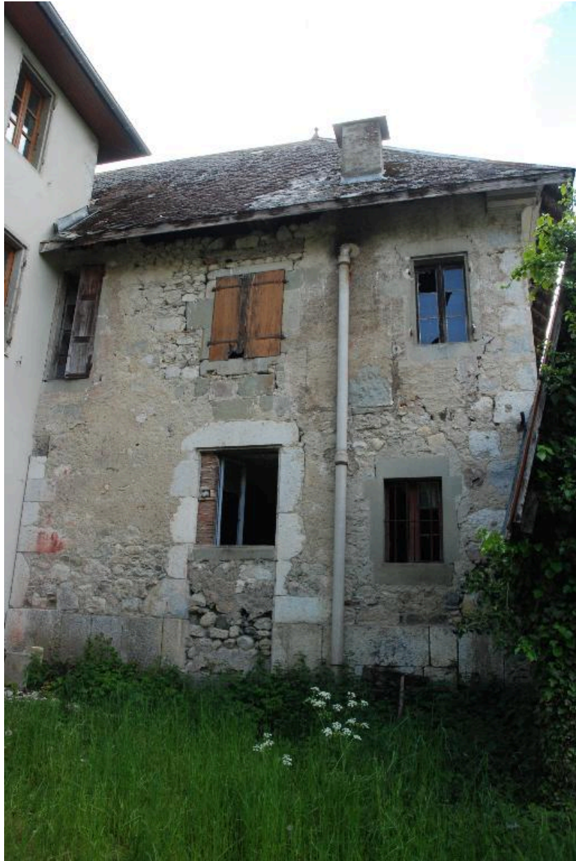
Bâtiment ouest (partie nord), façade est.
