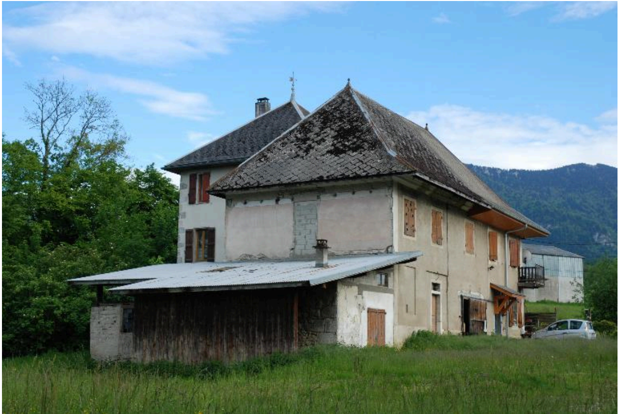
Bâtiment ouest, vue depuis le nord-ouest.
