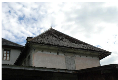
Bâtiment ouest (partie nord), détail de la façade nord : vestiges d'enduit. Phot. Thierry Monnet IVR82_20157303106NUCA
