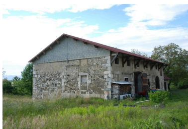
Bâtiment est, vue d'ensemble depuis le sud-est. Phot. Thierry Monnet IVR82_20157303100NUCA
