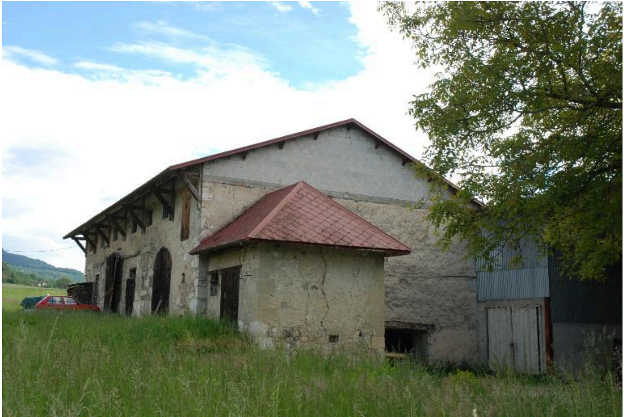
Bâtiment est, vue d'ensemble depuis le nord-est.
