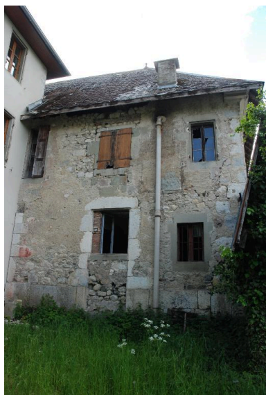
Bâtiment ouest (partie nord), façade est. Phot. Thierry Monnet IVR82_20157303104NUCA
