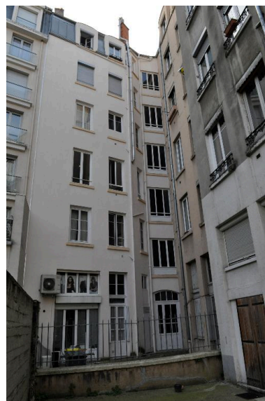
Vue partielle des élévations sur cour Phot. Magali Delavenne IVR84_20176901496NUCA
