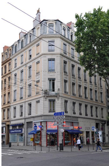
Vue générale, prise depuis le sud Phot. Magali Delavenne IVR84_20176901467NUCA
