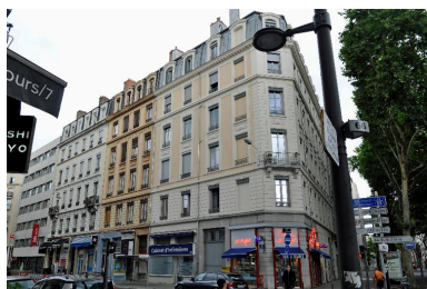
Vue de situation, montrant l'ensemble formel avec l'immeuble mitoyen Phot. Magali Delavenne IVR84_20176901470NUCA
