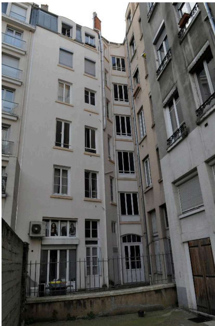
Vue partielle des élévations sur cour
