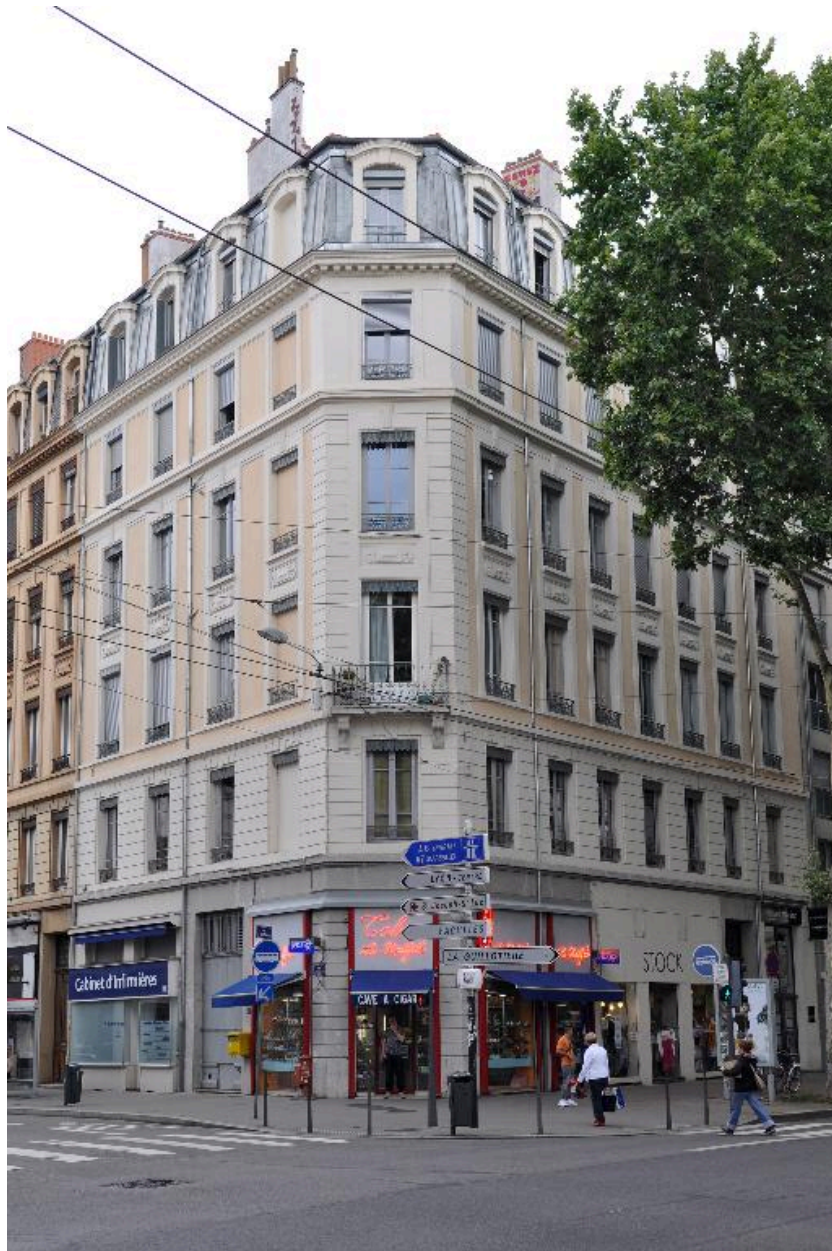
Vue générale, prise depuis le sud
