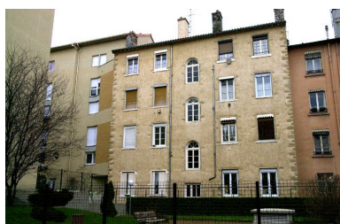
Elévation postérieure Phot. Maryannick Chalabi IVR82_20016900190NUCA
