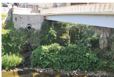
Détail du mur de protection avec une évacuation (canal de fuite ?) au dessous de l'évacuation récente Phot. Yannick Milleret IVR82_20107300449NUCA
