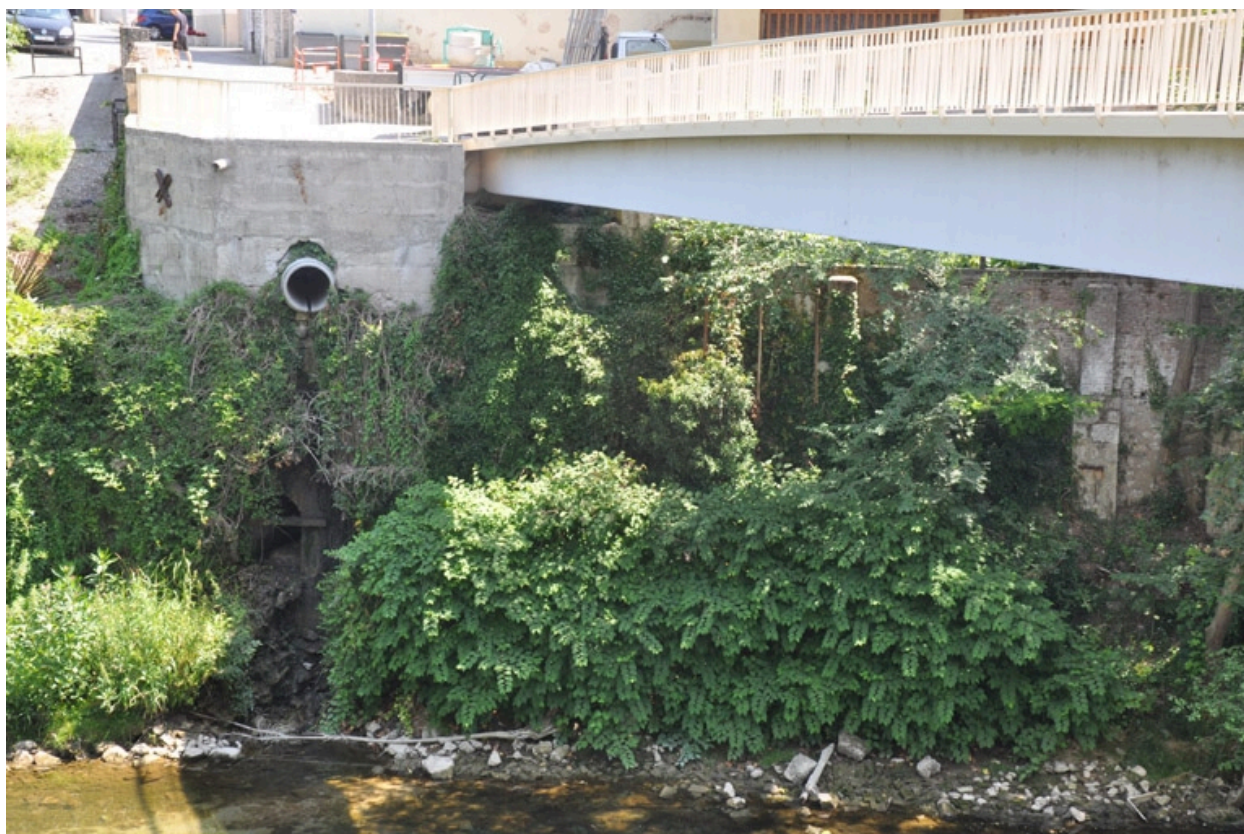
Détail du mur de protection avec une évacuation (canal de fuite ?) au dessous de l'évacuation récente
