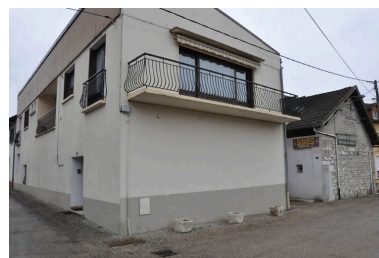
Bâtiments de l'ancienne usine de soie, au nord du bâtiment de logement récent Phot. Yannick Milleret IVR82_20107300524NUCA
