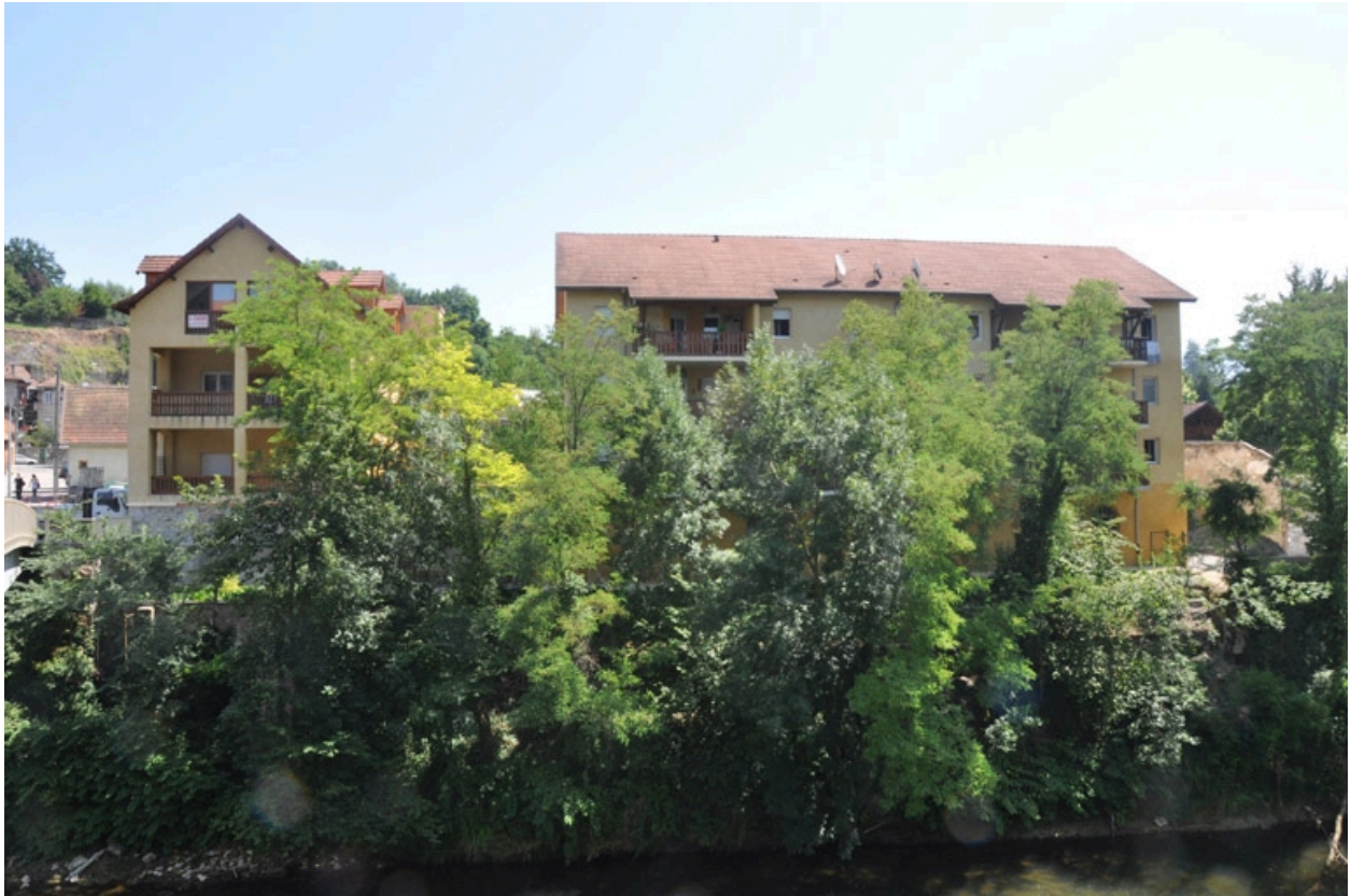
Vue générale du nouveau bâtiment sur le site de l'ancienne usine de soie, façade sud-ouest
