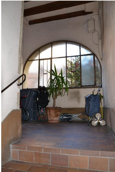
Baie escalier Phot. Noémie Caillat IVR82_20156900198NUCA
