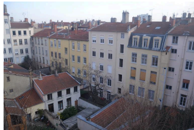
Vue d'ensemble façade ouest Phot. Noémie Caillat IVR82_20156900153NUCA
