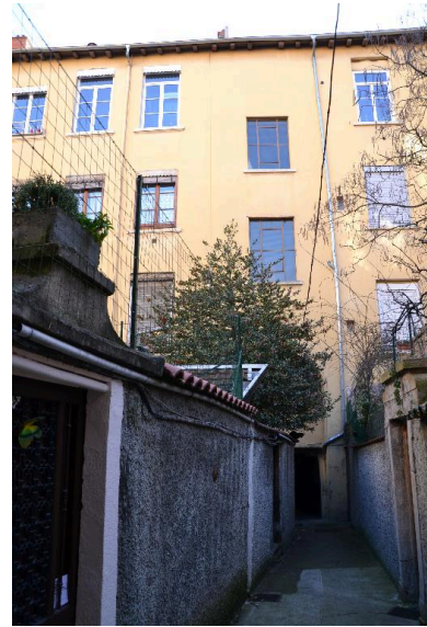
Façade ouest Phot. Noémie Caillat IVR82_20156900196NUCA
