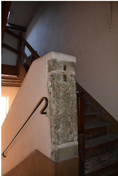
Escalier dernier niveau Phot. Noémie Caillat IVR82_20156900204NUCA
