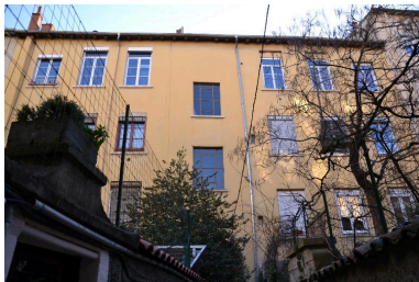
Façade ouest Phot. Noémie Caillat IVR82_20156900197NUCA
