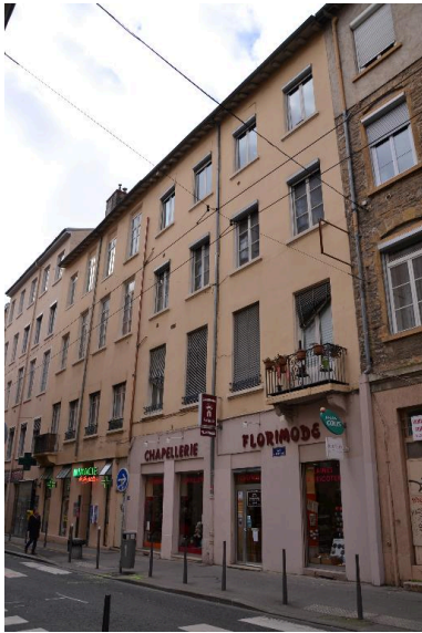
Vue d'ensemble façade est Phot. Noémie Caillat IVR82_20156900192NUCA
