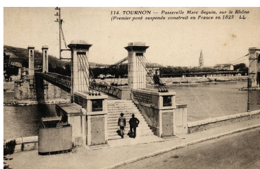
114. Tournon - Passerelle Marc Seguin, sur le Rhône (Premier pont suspendu construit en France en 1825) / L.L. édit., [1ère moitié du 20e siècle]. 1 impr. photoméc. (carte postale) : n. et b. (MdFR. Collection Dürrenmatt, CP DUR 1383) Phot. Maison du Fleuve Rhône, Autr. auteur inconnu IVR82_20100700030NUCAB
