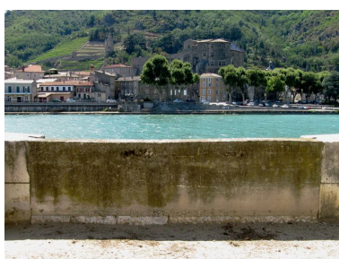
Emplacement du pont depuis son débouché rive gauche (ouverture obturée), vue générale Phot. I. Havard IVR82_20100700360NUCA
