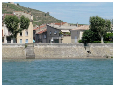
Débouché du pont, vue générale (depuis la rive droite) Phot. I. Havard IVR82_20100700259NUCA
