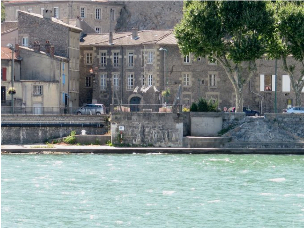
Vue de la culée de rive droite, vue générale, face (depuis le débouché du pont en rive gauche)
