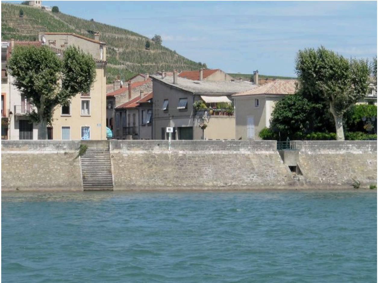
Débouché du pont, vue générale (depuis la rive droite)
