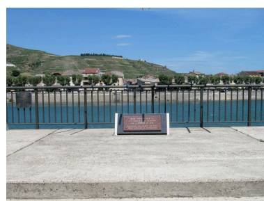
Débouché du pont, vue générale (depuis la plate-forme de la culée de rive droite) ; plaque commémorative Phot. I. Havard IVR82_20100700361NUCA
