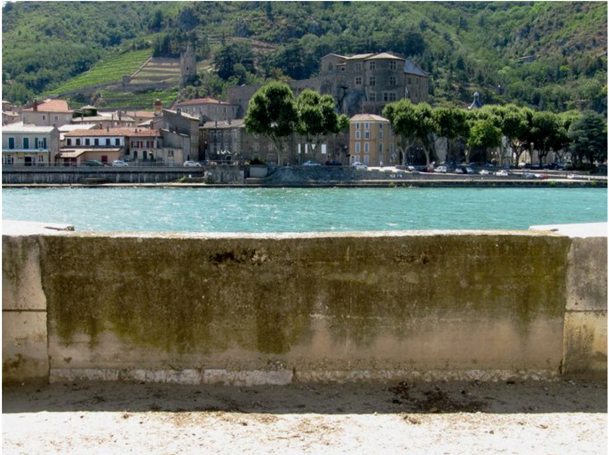
Emplacement du pont depuis son débouché rive gauche (ouverture obturée), vue générale
