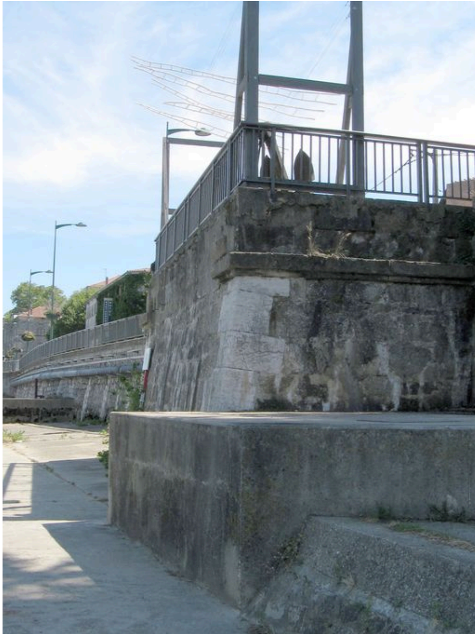
Vestiges de la culée de rive droite, vue latérale (depuis la rive droite)
