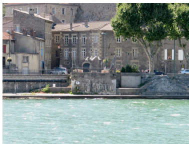
Vue de la culée de rive droite, vue générale, face (depuis le débouché du pont en rive gauche) Phot. I. Havard IVR82_20100700260NUCA
