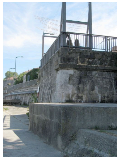
Vestiges de la culée de rive droite, vue latérale (depuis la rive droite) Phot. I. Havard IVR82_20100700261NUCA
