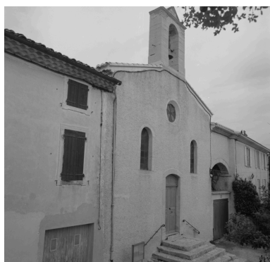
Façade ; à droite, corps accolé abritant la 2e cloche. Phot. Alain Franchella IVR82_19992600032X
