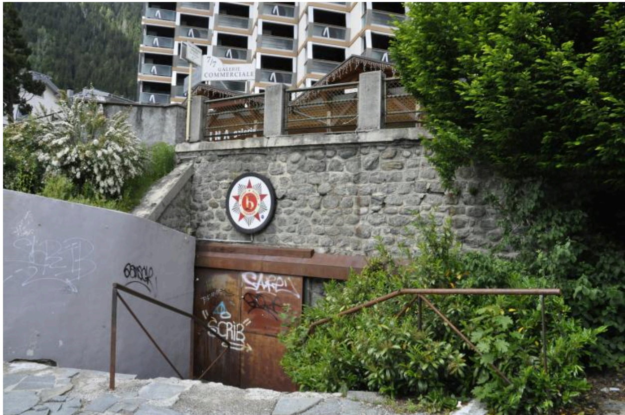
Détail du mur de retour de la face aval en rive droite du torrent de l'Arve
