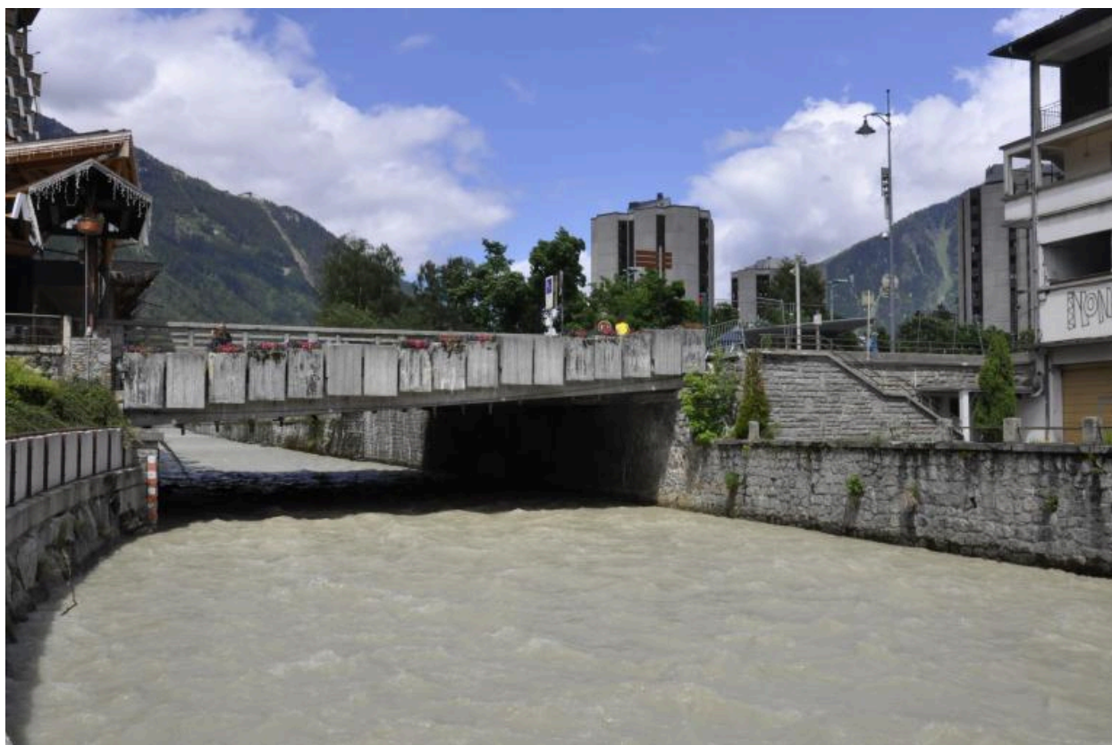
Vue de la face aval du pont
