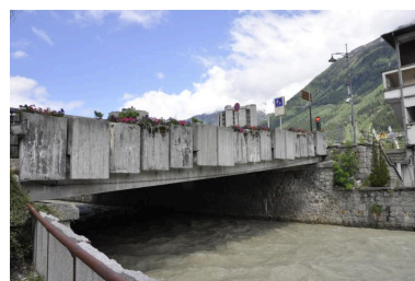
Détail du garde-corps de la passerelle de la rue des Moulins aménagée en face aval du pont Phot. Samir Mahfoudi IVR84_20207401321NUCA
