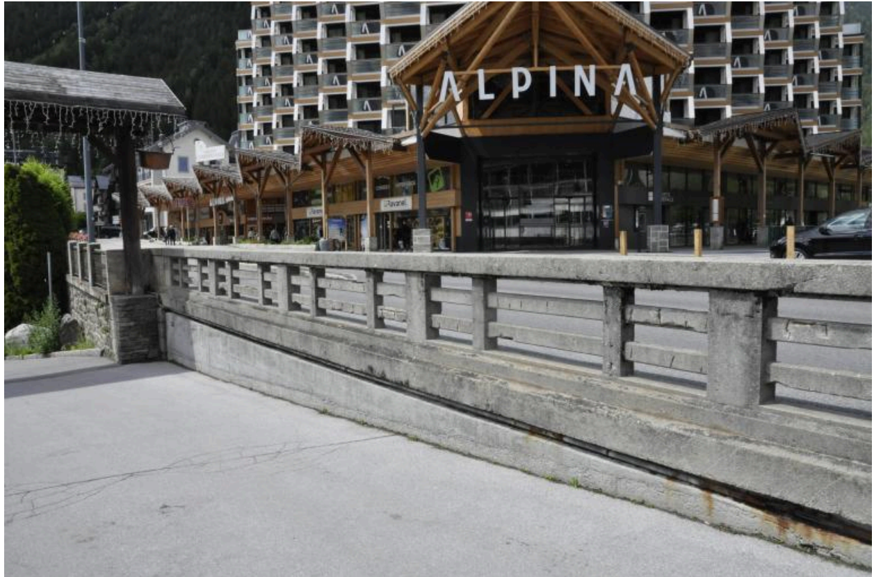
Détail du garde-corps en béton de la face aval
