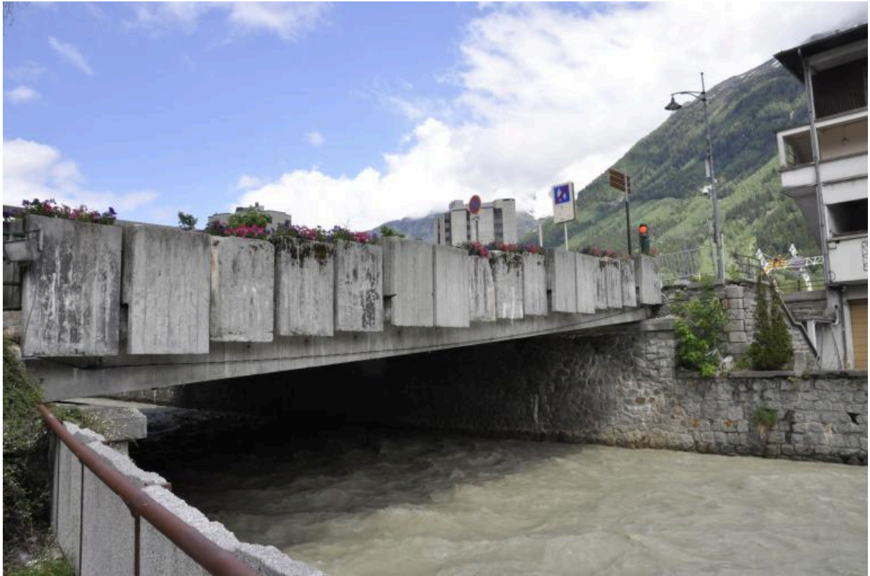
Détail du garde-corps de la passerelle de la rue des Moulins aménagée en face aval du pont
