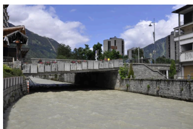
Vue de la face aval du pont Phot. Samir Mahfoudi IVR84_20207401322NUCA
