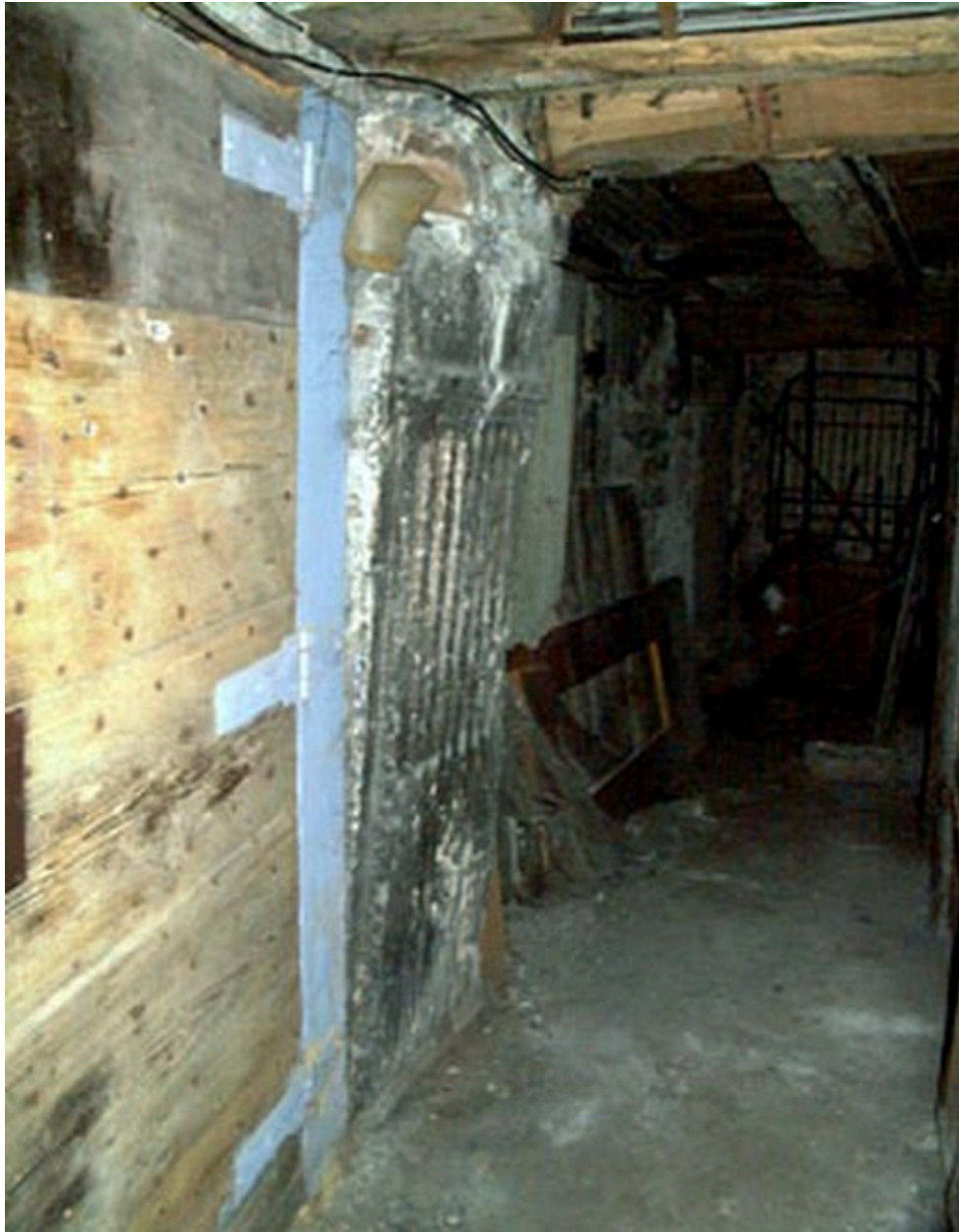
Vue d'un pilier en remploi au niveau des caves (vestiges de la maison Bellière ?)
