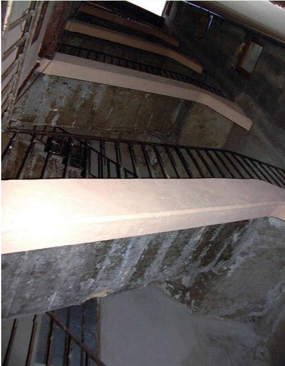
Vue de l'escalier commun sur cour
