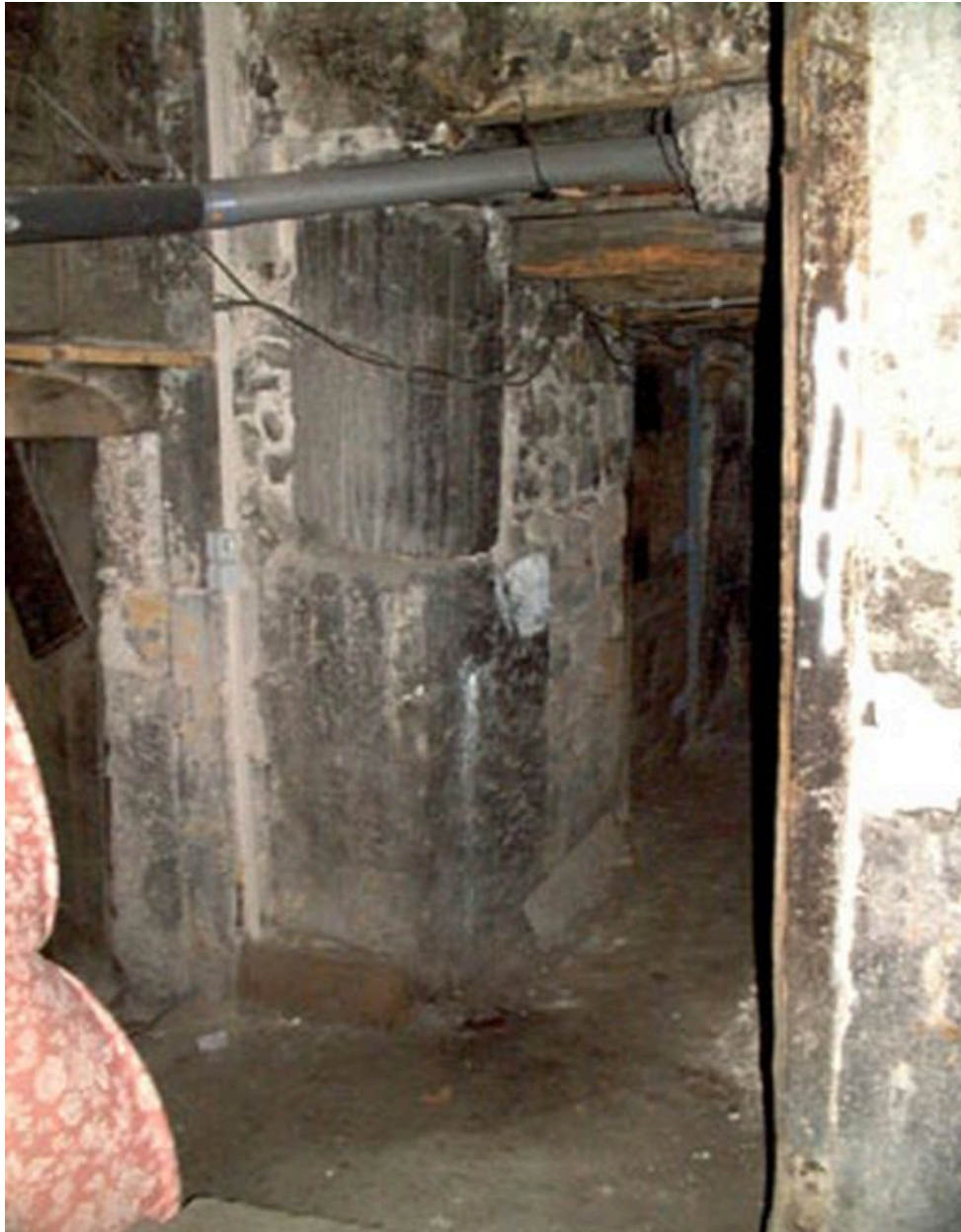
Vue d'une colonne cannelée en remploi au niveau des caves (vestiges de la maison Bellière ?)
