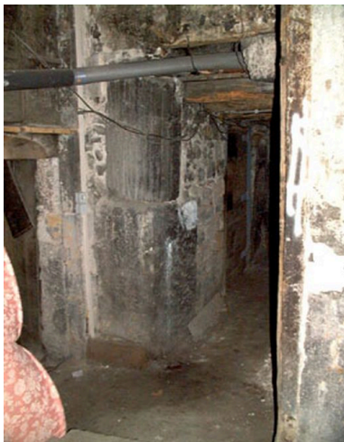
Vue d'une colonne cannelée en remploi au niveau des caves (vestiges de la maison Bellière ?) Phot. Maryannick Chalabi IVR82_20006900186NUCA
