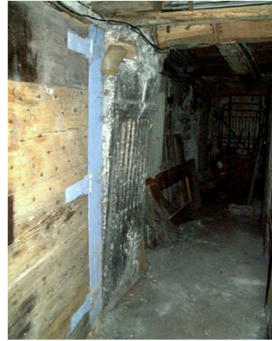
Vue d'un pilier en remploi au niveau des caves (vestiges de la maison Bellière ?) Phot. Maryannick Chalabi IVR82_20006900185NUCA
