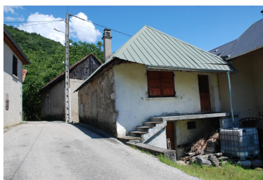
Cellier viticole dit sarto (2018 YM 103). Phot. Caroline Guibaud IVR84_20247301272NUCA
