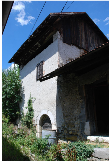
Cellier viticole dit sarto (2018 YM 96). Phot. Caroline Guibaud IVR84_20247301274NUCA
