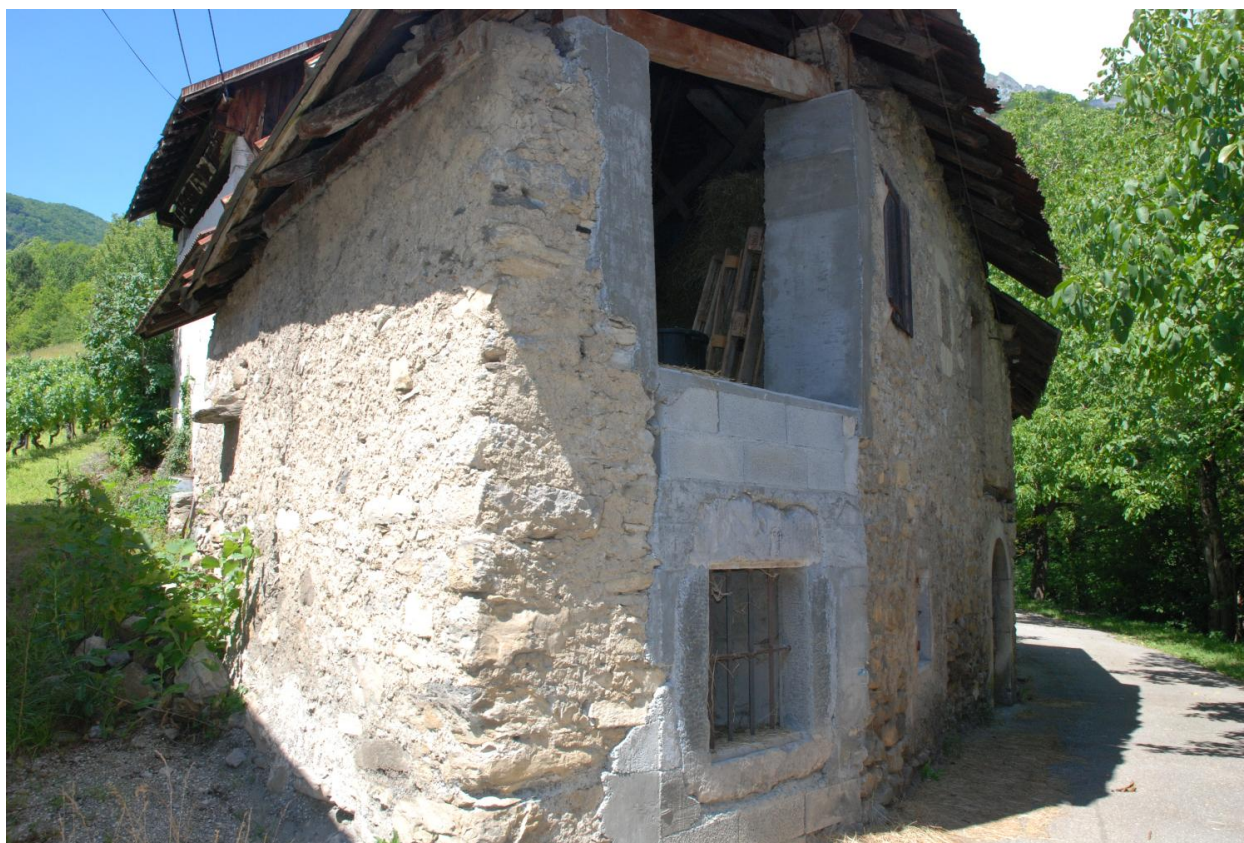
Cellier viticole dit sarto (2018 YM 99), vue depuis le sud.
