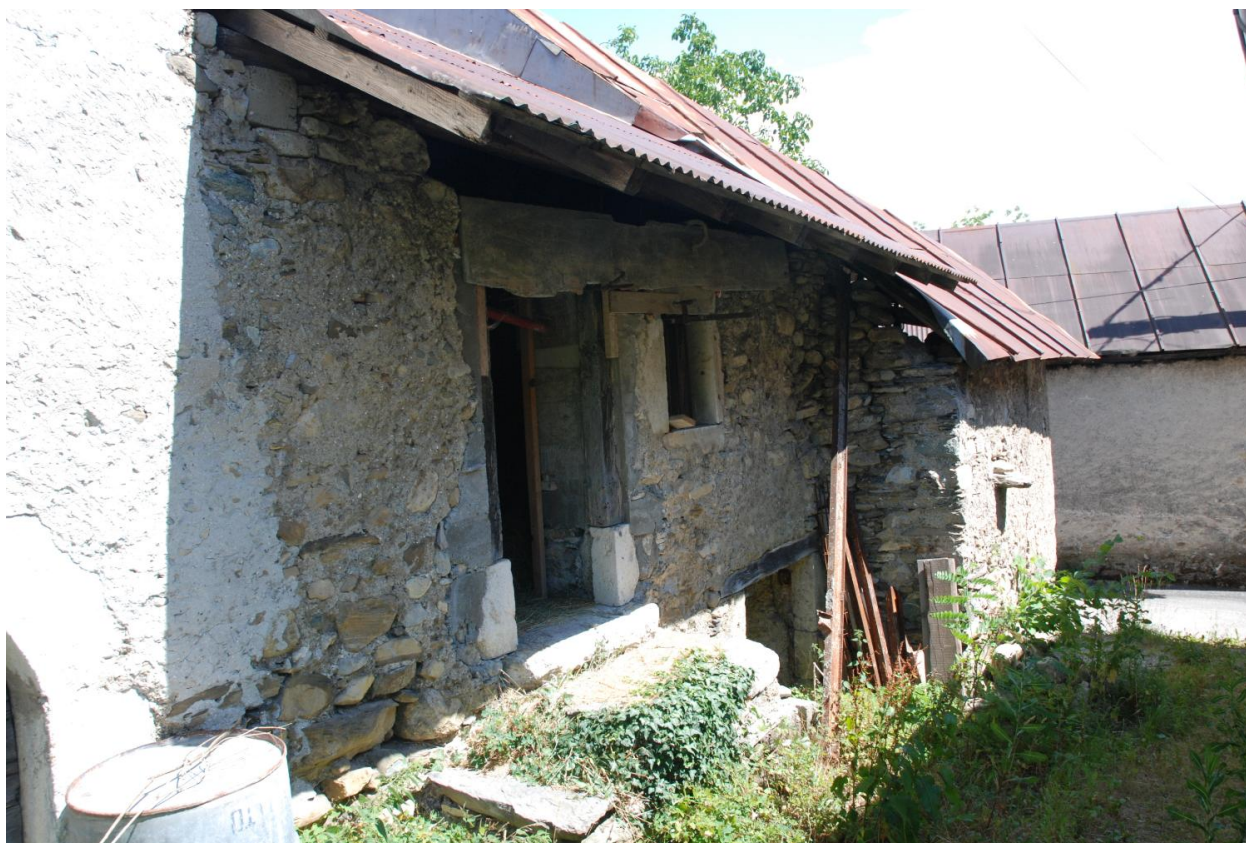
Celliers viticoles dits sartos (2018 YM 96 et 99), vue depuis le nord-ouest.
