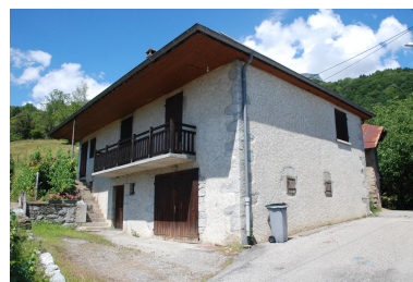
Cellier viticole dit sarto (2018 YM 100). Phot. Caroline Guibaud IVR84_20247301273NUCA
