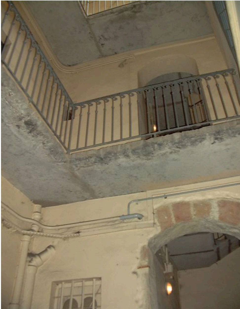
Vue partielle de la coursière reliant l'escalier aux appartements situés dans la partie nord-est de l'immeuble
