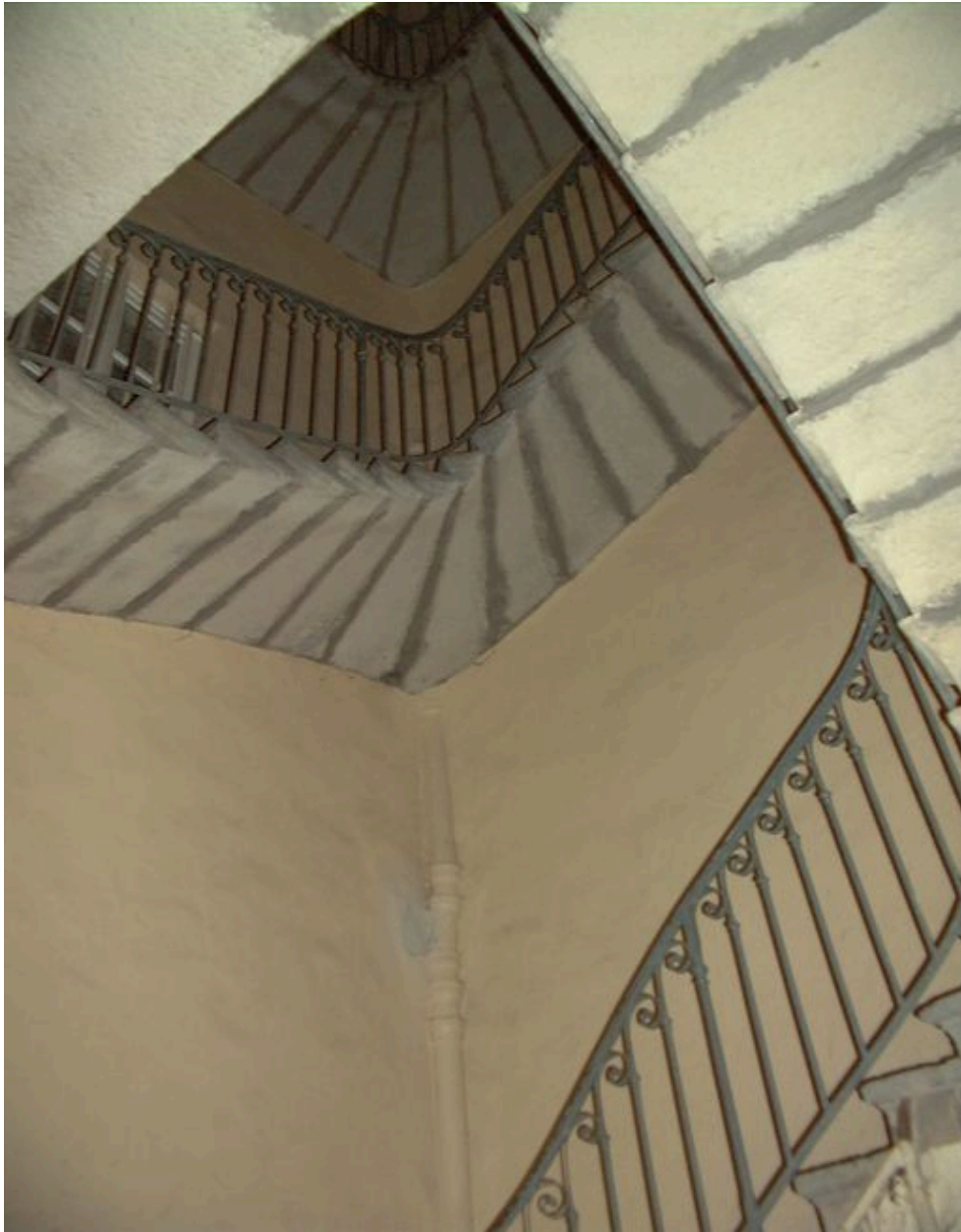
Vue partielle de la cage d'escalier
