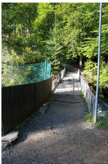
Passerelle de la cascade d'Ardent, chaussée et garde corps Phot. Benoît Huraut IVR84_20207400965NUCA
