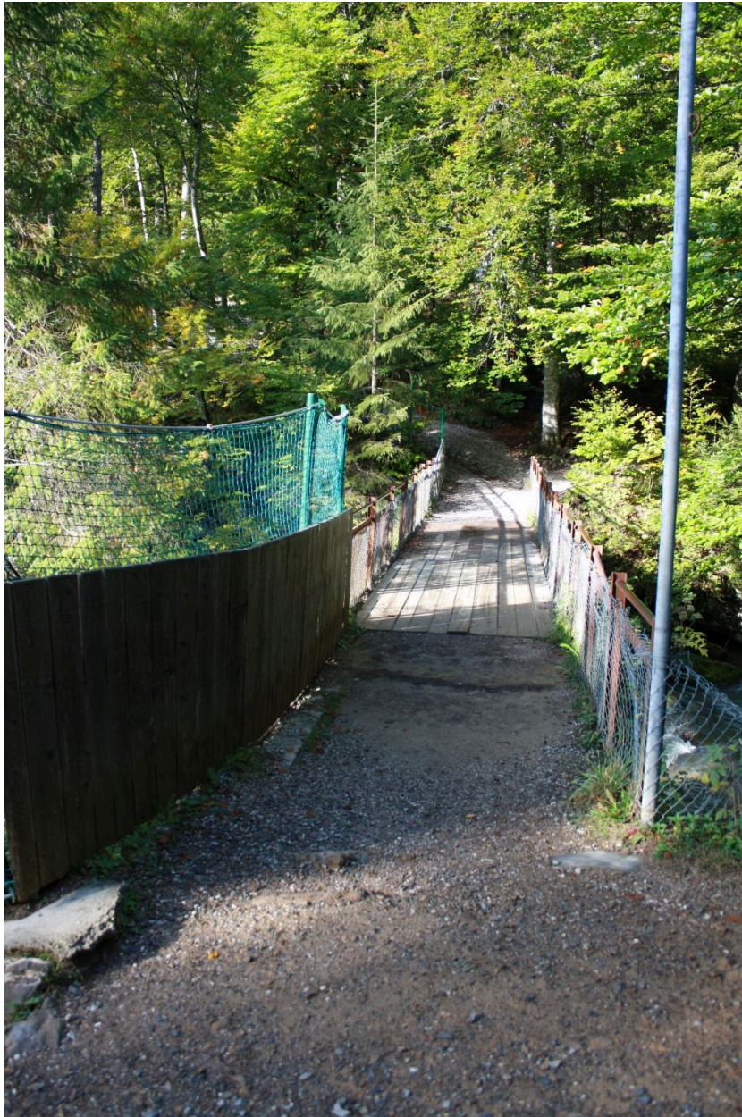
Passerelle de la cascade d'Ardent, chaussée et garde corps
