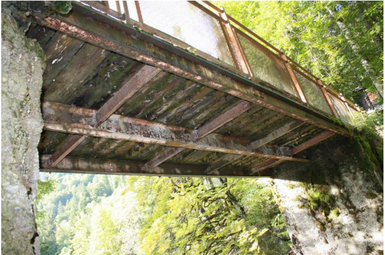
Passerelle de la cascade d'Ardent, détail tablier
