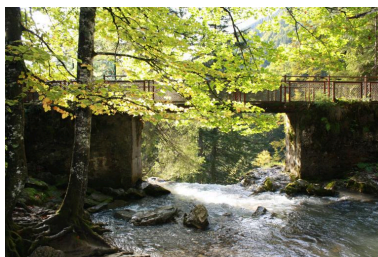
Passerelle de la cascade d'Ardent, face amont IVR84_20197401260NUCA
