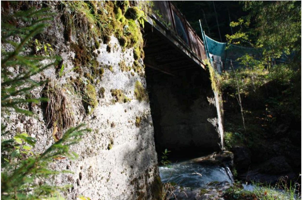
Passerelle de la cascade d'Ardent, face aval
