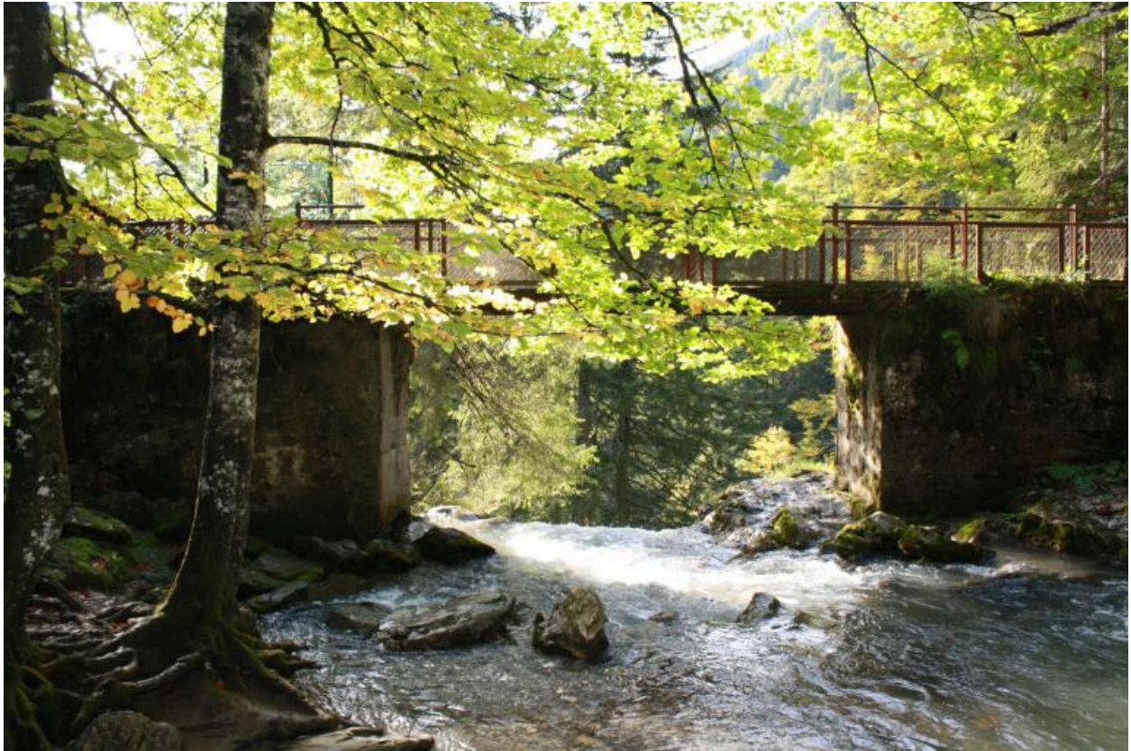
Passerelle de la cascade d'Ardent, face amont
