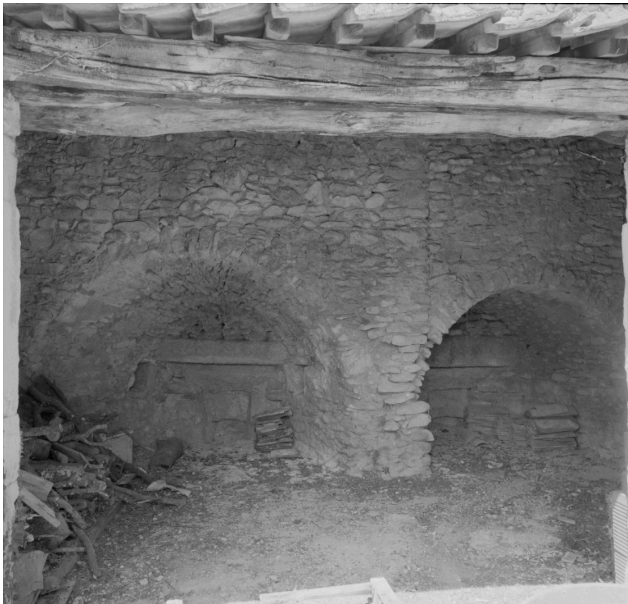
Vue intérieure du four à chaux double.
