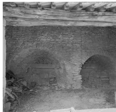
Vue intérieure du four à chaux double. Phot. Alain Franchella IVR82_19992600323X
