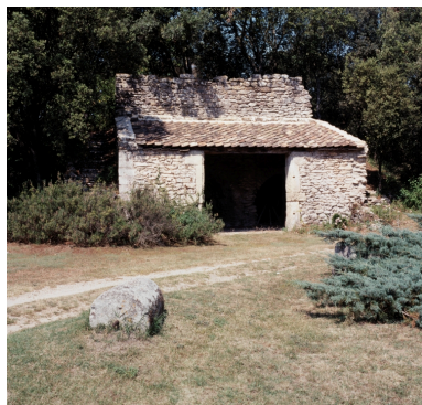
Vue extérieure du four à chaux double. Phot. Alain Franchella IVR82_19992600322XA
