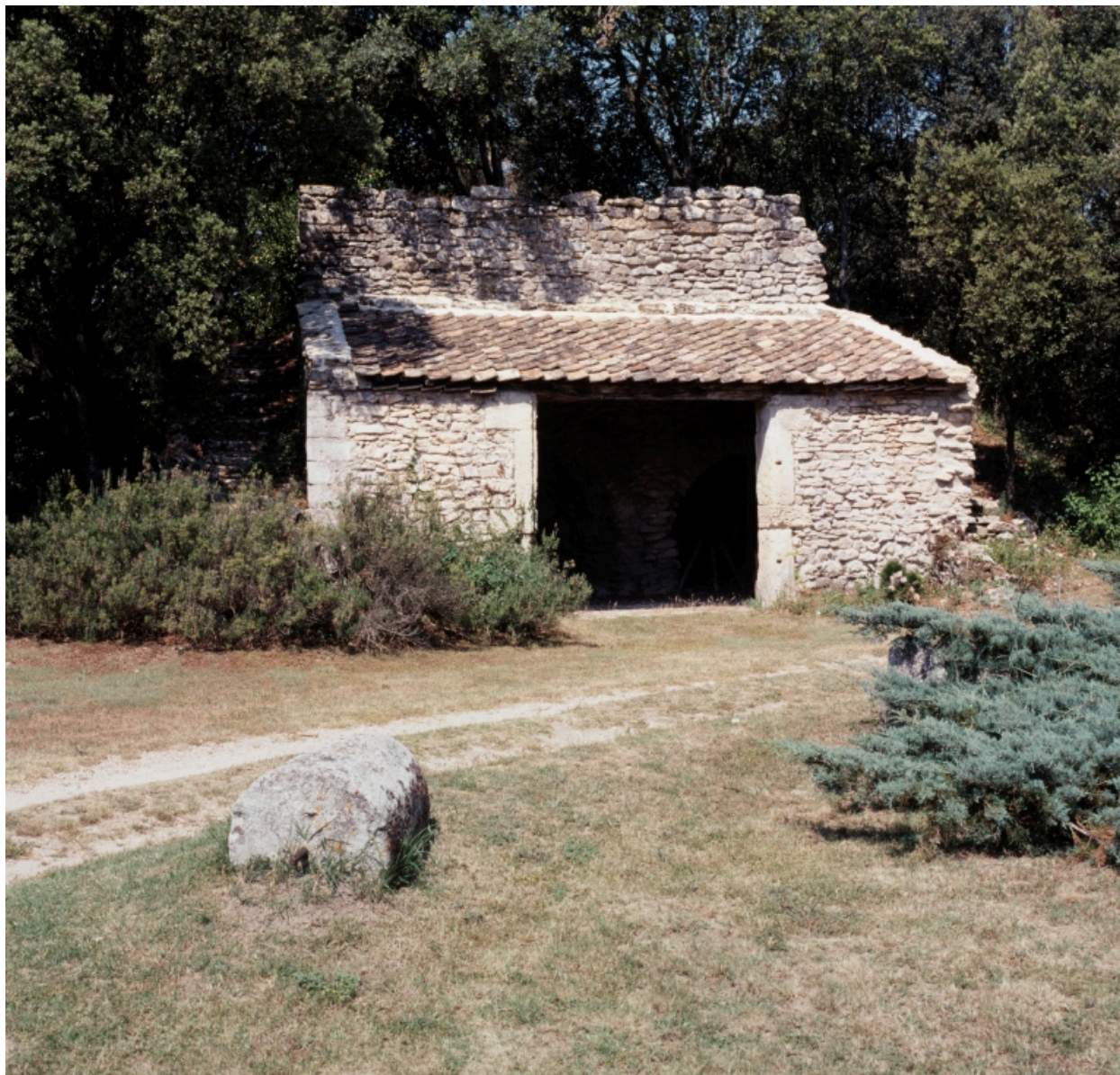
Vue extérieure du four à chaux double.
