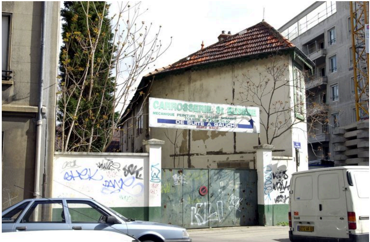
Immeuble : élévations postérieures
