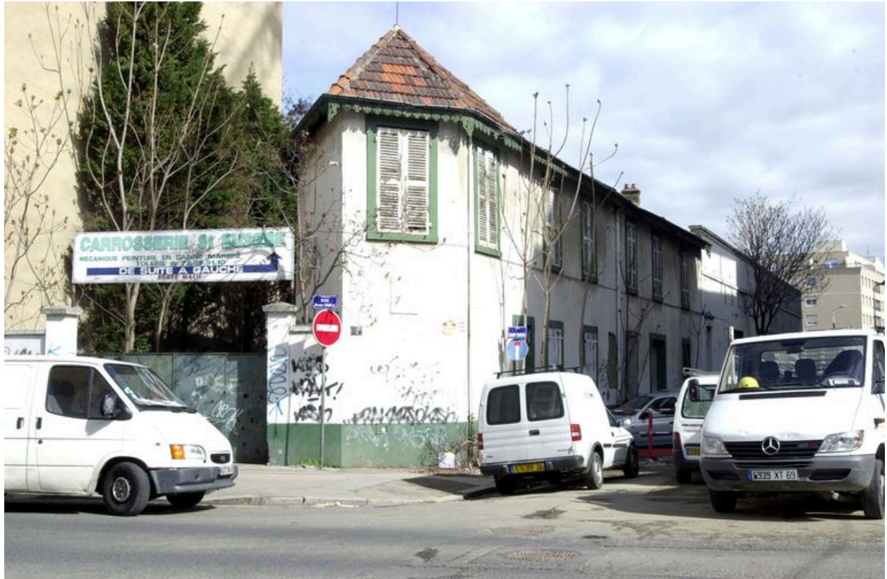
Vue générale de l'immeuble
