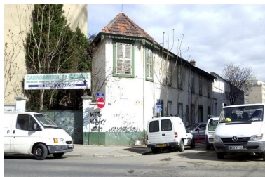
Vue générale de l'immeuble Phot. Bernard Ducouret IVR82_20046902100NUCA
