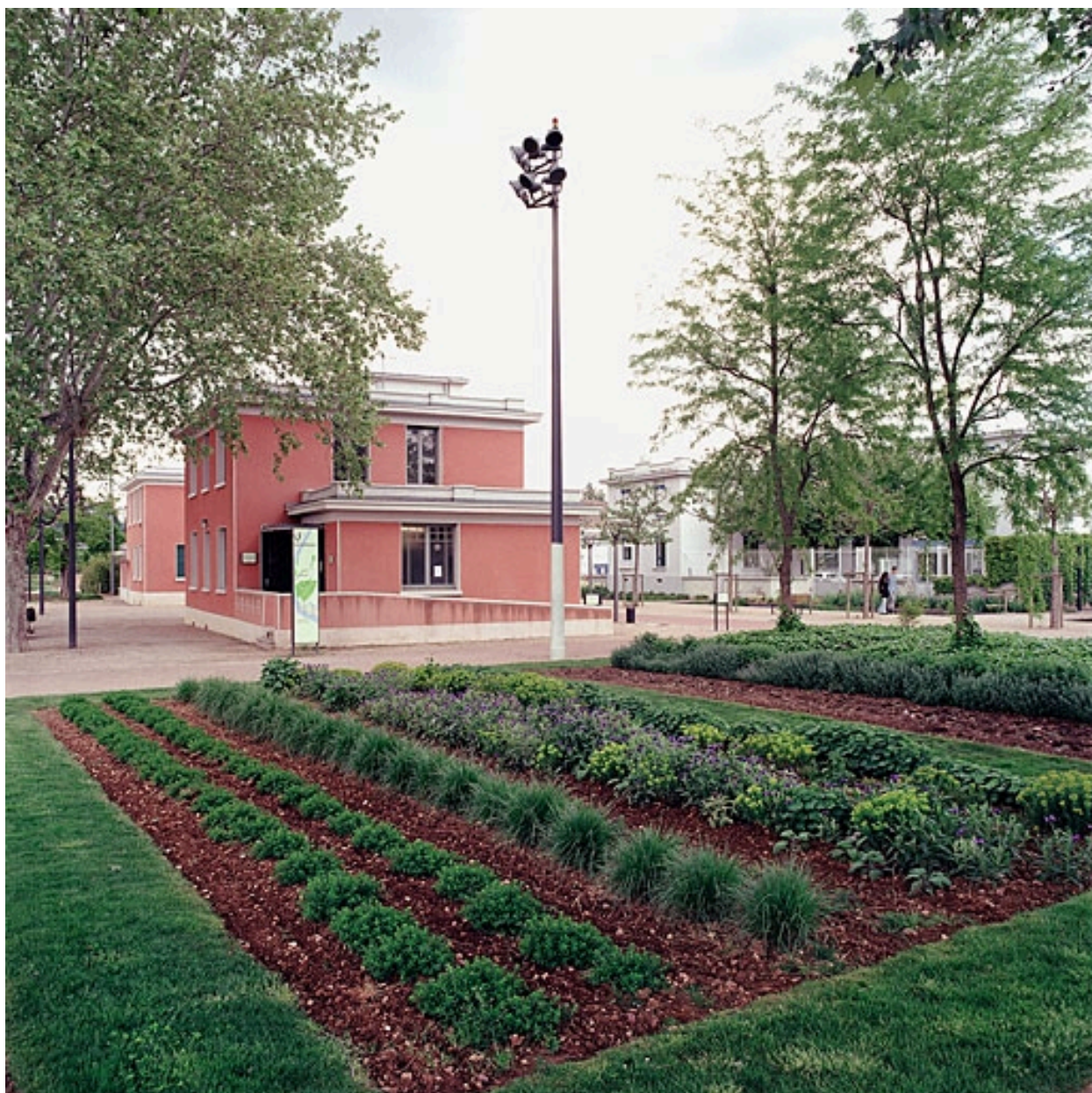
Vue nord des pavillons administratifs
