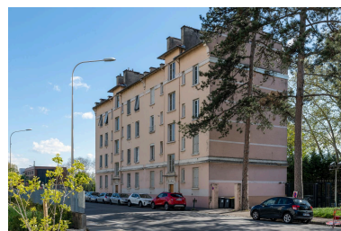
Logements ouvriers en lien avec les jardins Phot. Michel Pérès IVR84_20216900415NUCA
