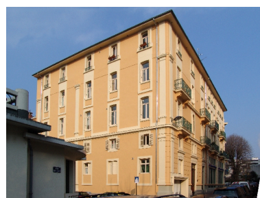
Élévation postérieure, vue de trois-quart depuis le sud-est Phot. François Fouger IVR82_20097300159NUCA
