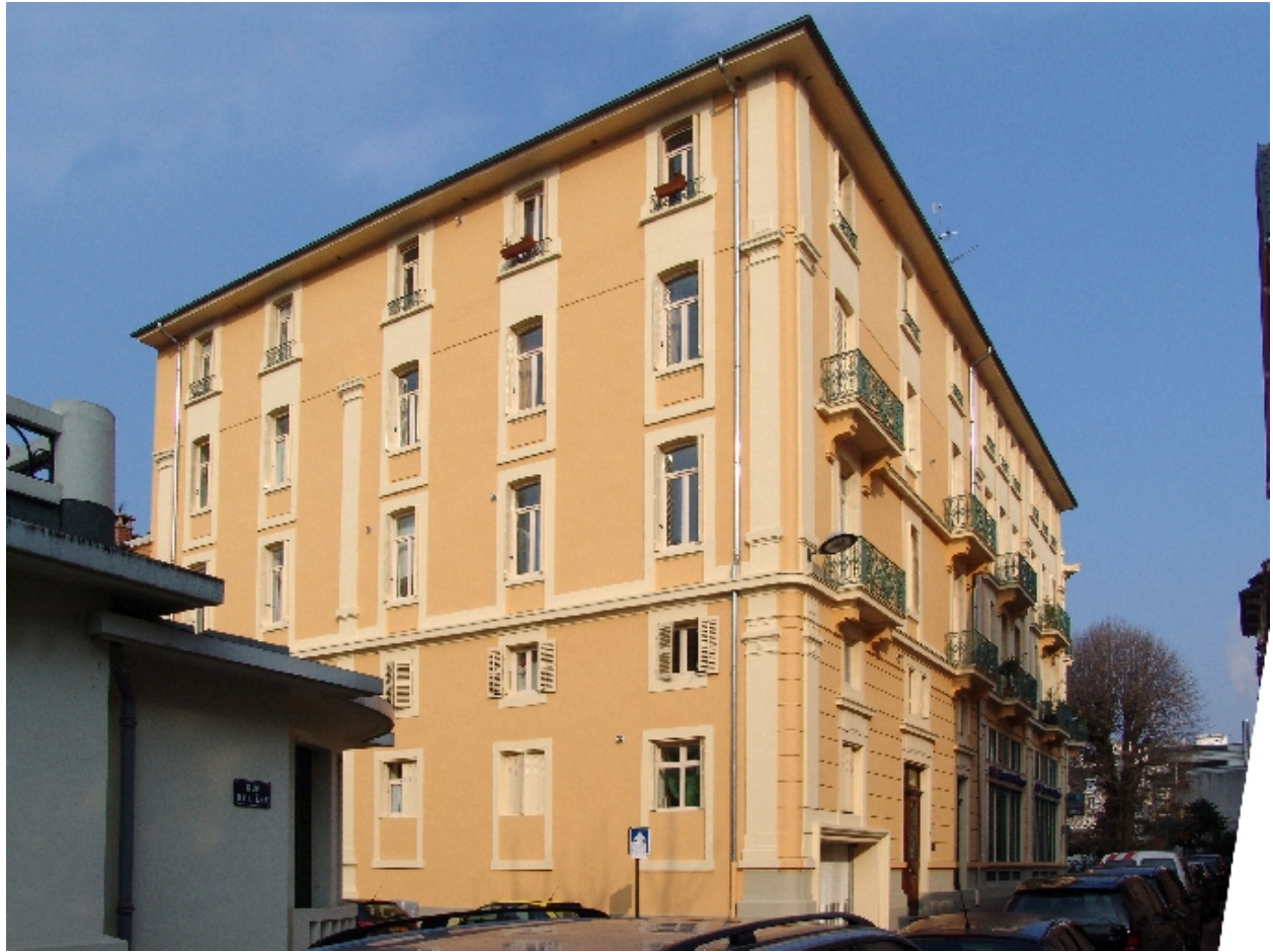
Elévation postérieure, vue de trois-quart depuis le sud-est
