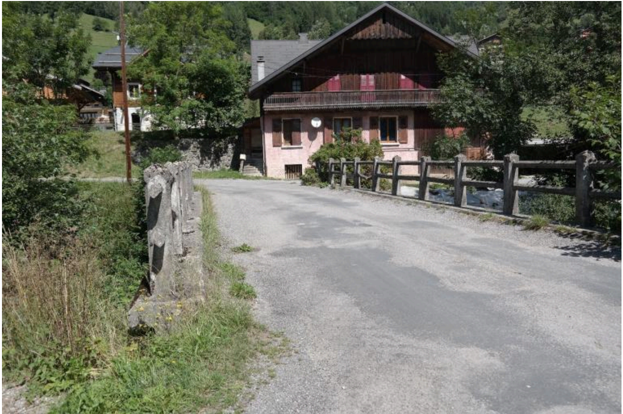
Pont de Chez les Ogays, vue de la chaussée et des garde-corps
