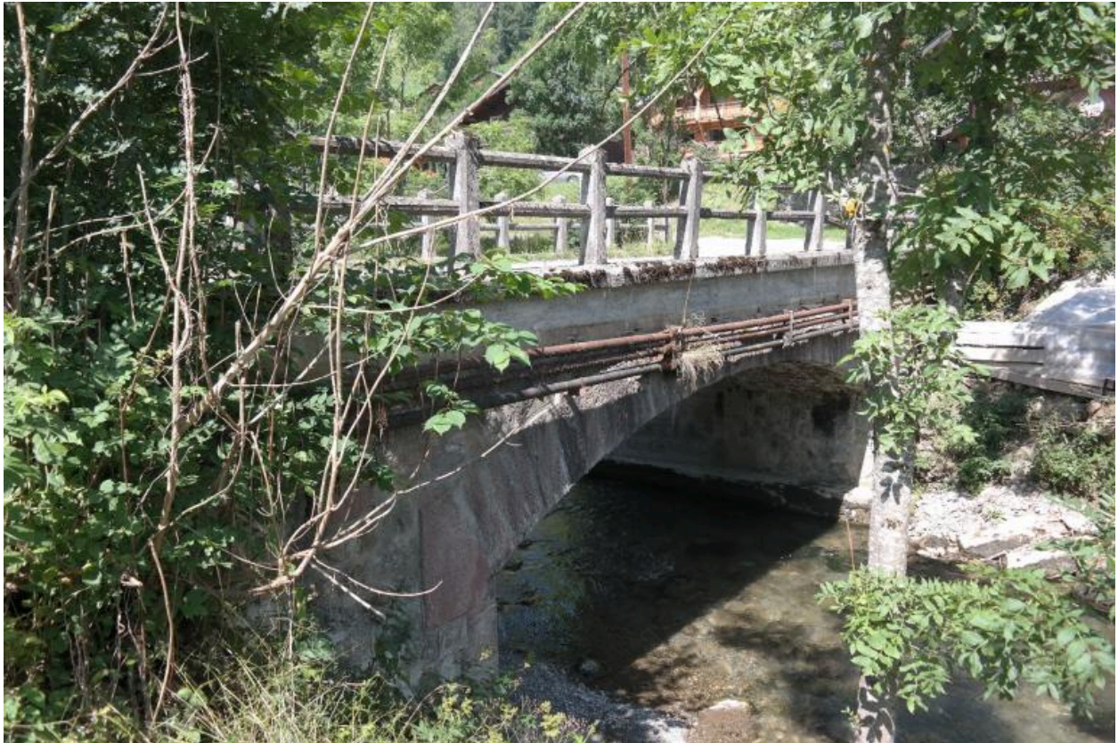
Vue générale du pont de Chez les Ogays
