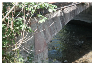
Pont de Chez les Ogays, détail de la voûte Phot. Pascale Renard IVR84_20207400950NUCA
