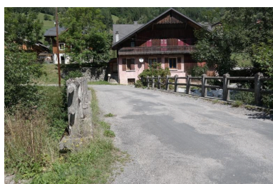
Pont de Chez les Ogays, vue de la chaussée et des garde-corps Phot. Pascale Renard IVR84_20207400948NUCA
