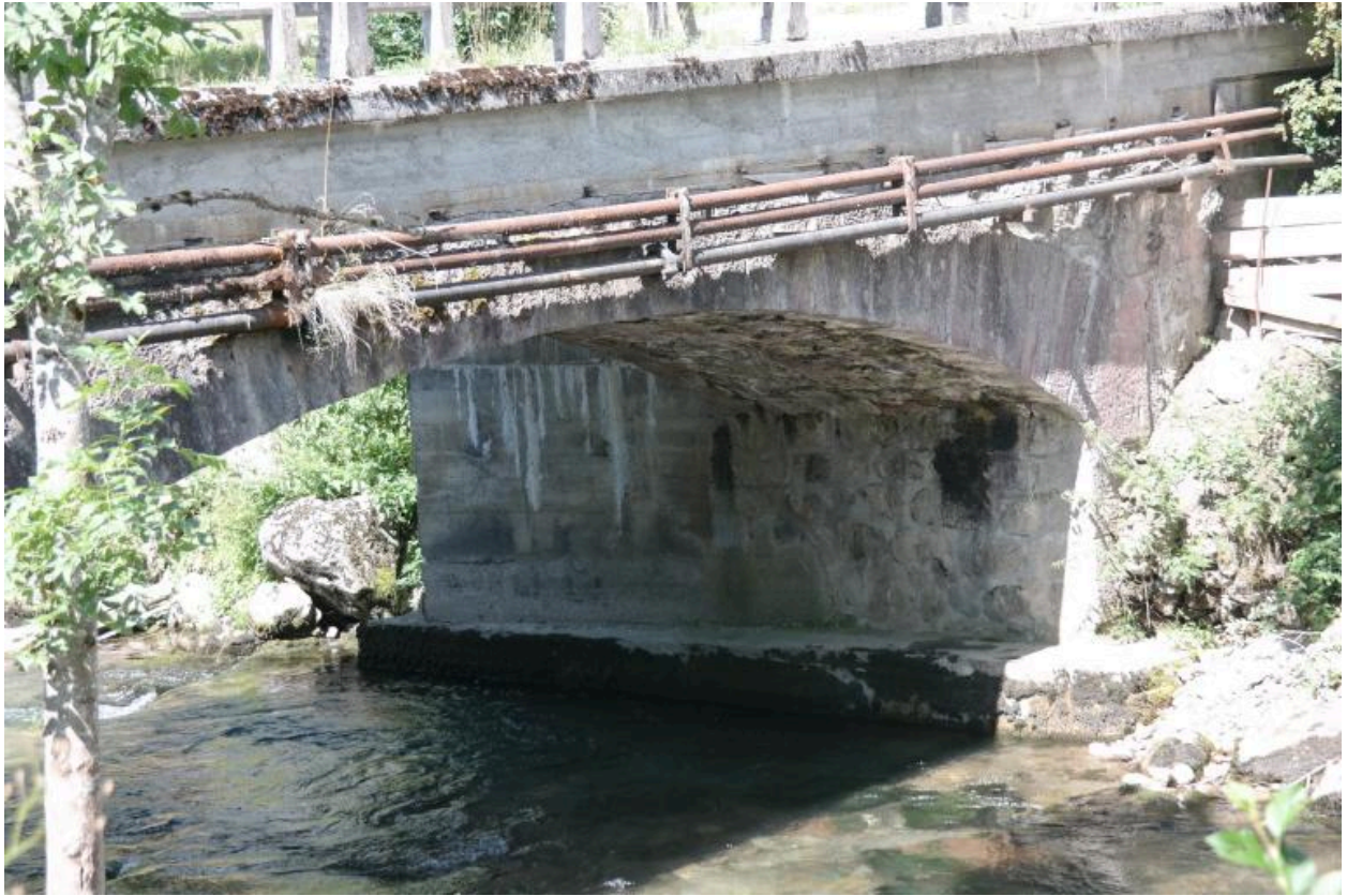
Pont de Chez les Ogays, vue de la voûte
