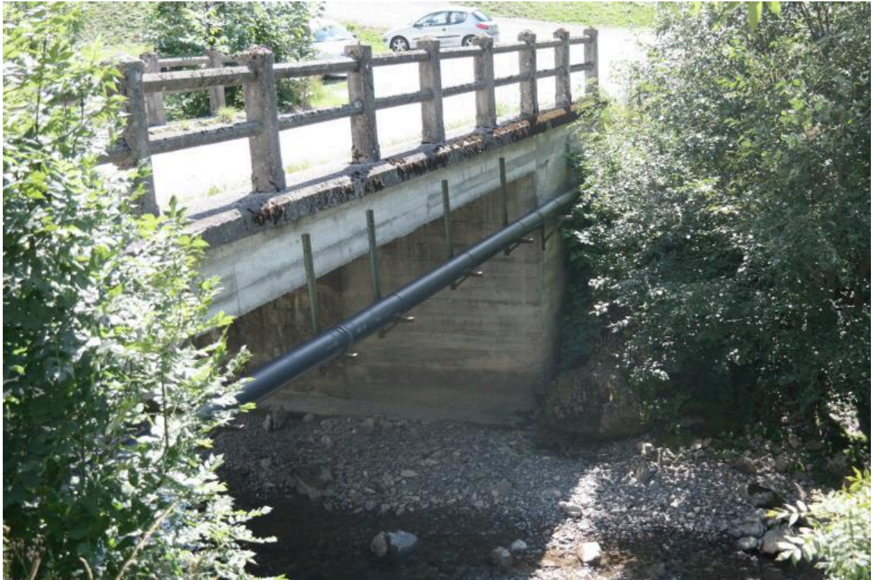
Pont de Chez les Ogays, vue de la face aval
