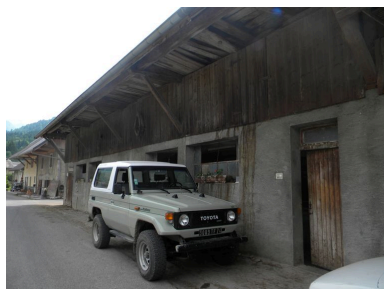
Vue des baies élargies au Xxe siècle et du bardage ancien doté de portes hautes à l'étage Phot. Jérôme Daviet IVR82_20127400527NUCA
