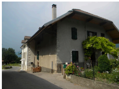
Vue d'ensemble de la partie logis Phot. Jérôme Daviet IVR82_20127400524NUCA
