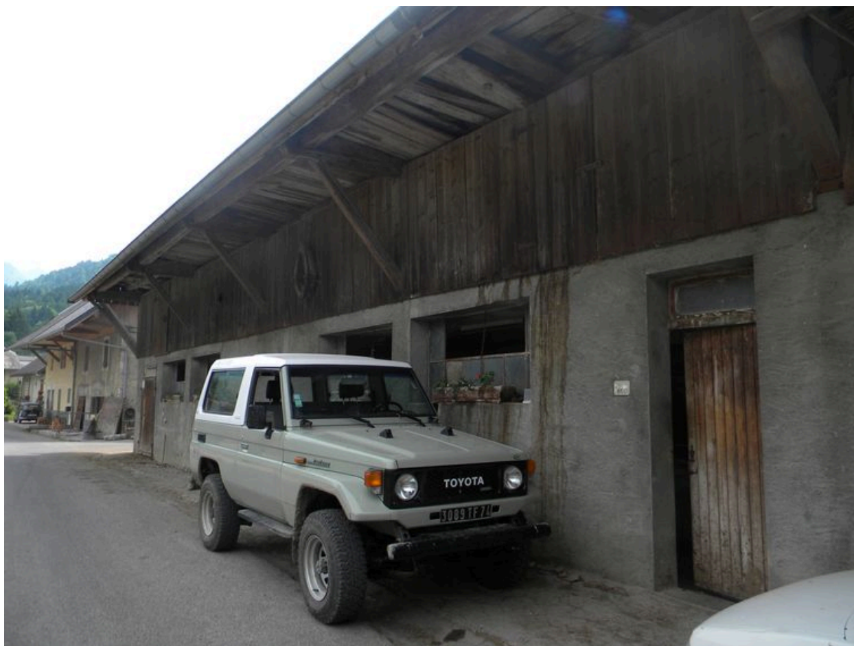
Vue des baies élargies au Xxe siècle et du bardage ancien doté de portes hautes à l'étage
