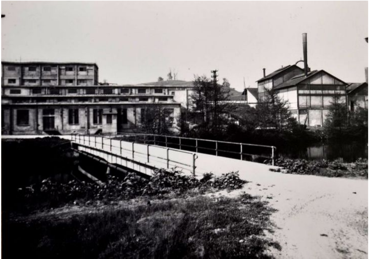
Elévation nord-est du bâtiment secondaire
