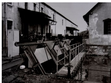
Le dégrilleur toujours installé sur l'île, janvier 1966. Photo. Archives municipales de Cran-Gevrier © Archives municipales de Cran- Gevrier. Dossier Tissage de Cran Phot. Samir Mahfoudi, Autr. Association Cran au File de l'Eau IVR82_20107403076NUCA
