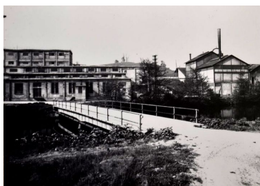
Elévation nord-est du bâtiment secondaire Phot. Samir Mahfoudi, Autr. Association Cran au File de l'Eau IVR82_20107400523NUCA
