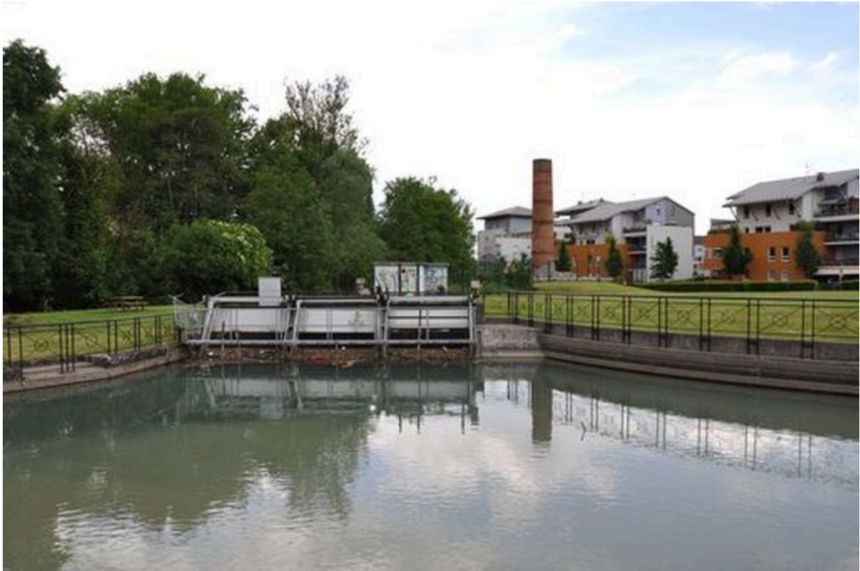
Barrage mobile captant les eaux du canal
