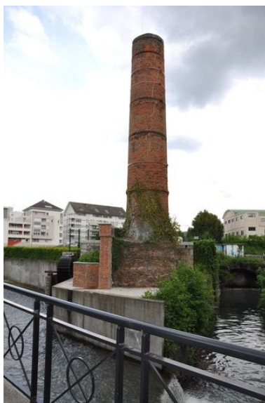
Vue générale Phot. Samir Mahfoudi, Autr. Samir Mahfoudi IVR82_20107403088NUCA
