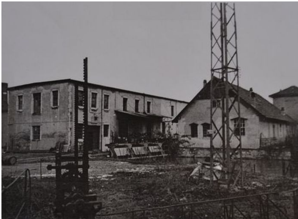
L'arrière des bâtiments des Tissages, janvier 1986. Photo. Archives municipales de Cran-Gevrier © Archives municipales de Cran-Gevrier. Dossier Tissage de Cran
