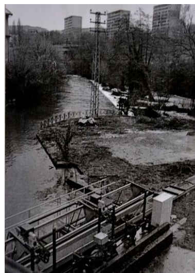
Vue d'en haut du dégrilleur. Photo. Archives municipales de Cran-Gevrier © Archives municipales de Cran-Gevrier. Dossier Tissage de Cran Phot. Samir Mahfoudi, Autr. Association Cran au File de l'Eau IVR82_20107403078NUCA
