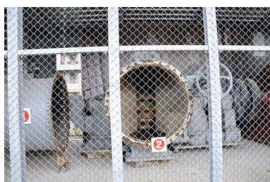
Anciens composants alimentant la turbine des Tissages Phot. Samir Mahfoudi, Autr. Samir Mahfoudi IVR82_20107403090NUCA
