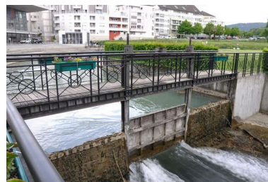
Jeu de trois vannes du barrage mobile Phot. Samir Mahfoudi, Autr. Samir Mahfoudi IVR82_20107403086NUCA
