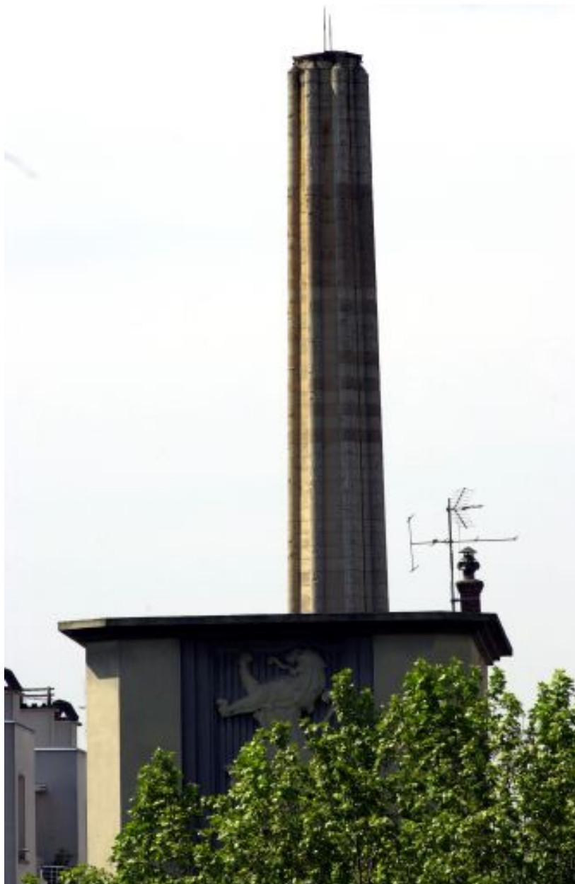
Vue de la cheminée de la chaudière
