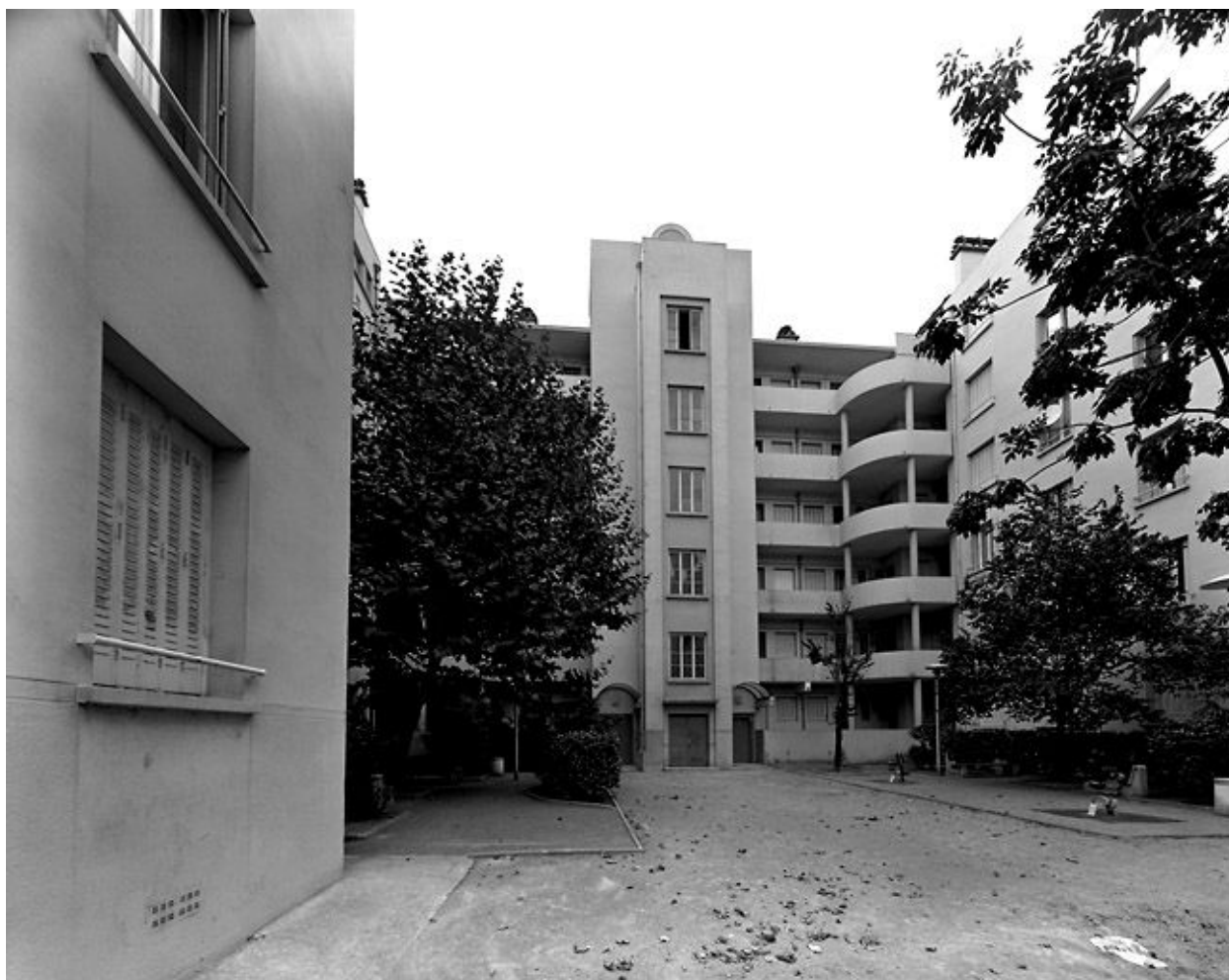
Elévation ouest de l'immeuble 69 rue Delandine
