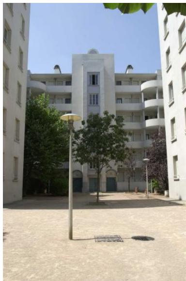
Elévation postérieure du 69 rue Delandine, la cage d'escalier hors-oeuvre Phot. François Blanchetière IVR82_20026903871NUCA
