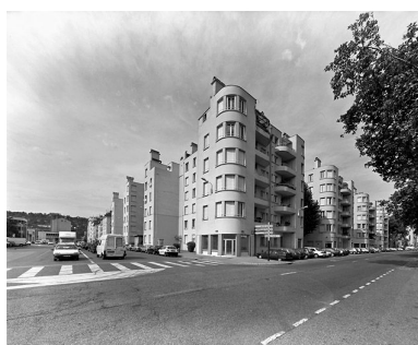
Vue générale depuis le sud-est, à l'angle du quai Perrache et de la rue Casimir-Périer Phot. Jean-Marie Refflé IVR82_20016902458V
