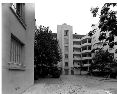
Elévation ouest de l'immeuble 69 rue Delandine Phot. Jean-Marie Refflé IVR82_20016902463V
