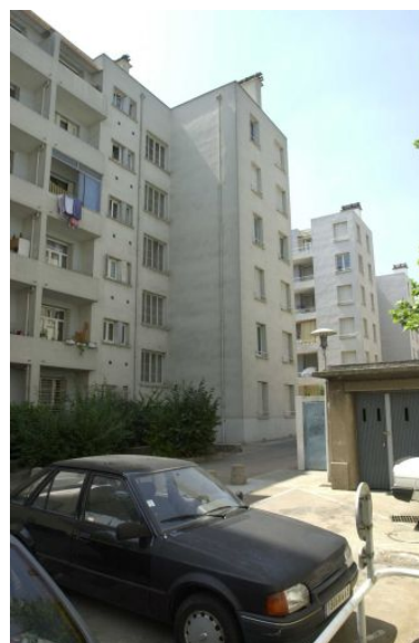
Elévation est du 73 rue Delandine Phot. François Blanchetière IVR82_20026903869NUCA
