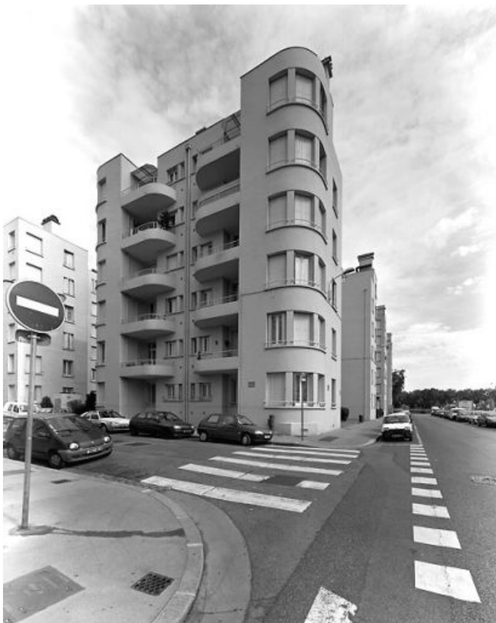
Vue de l'immeuble 43 rue Casimir-Perier, depuis l'angle du quai Perrache et de la rue Casimir-Perier
