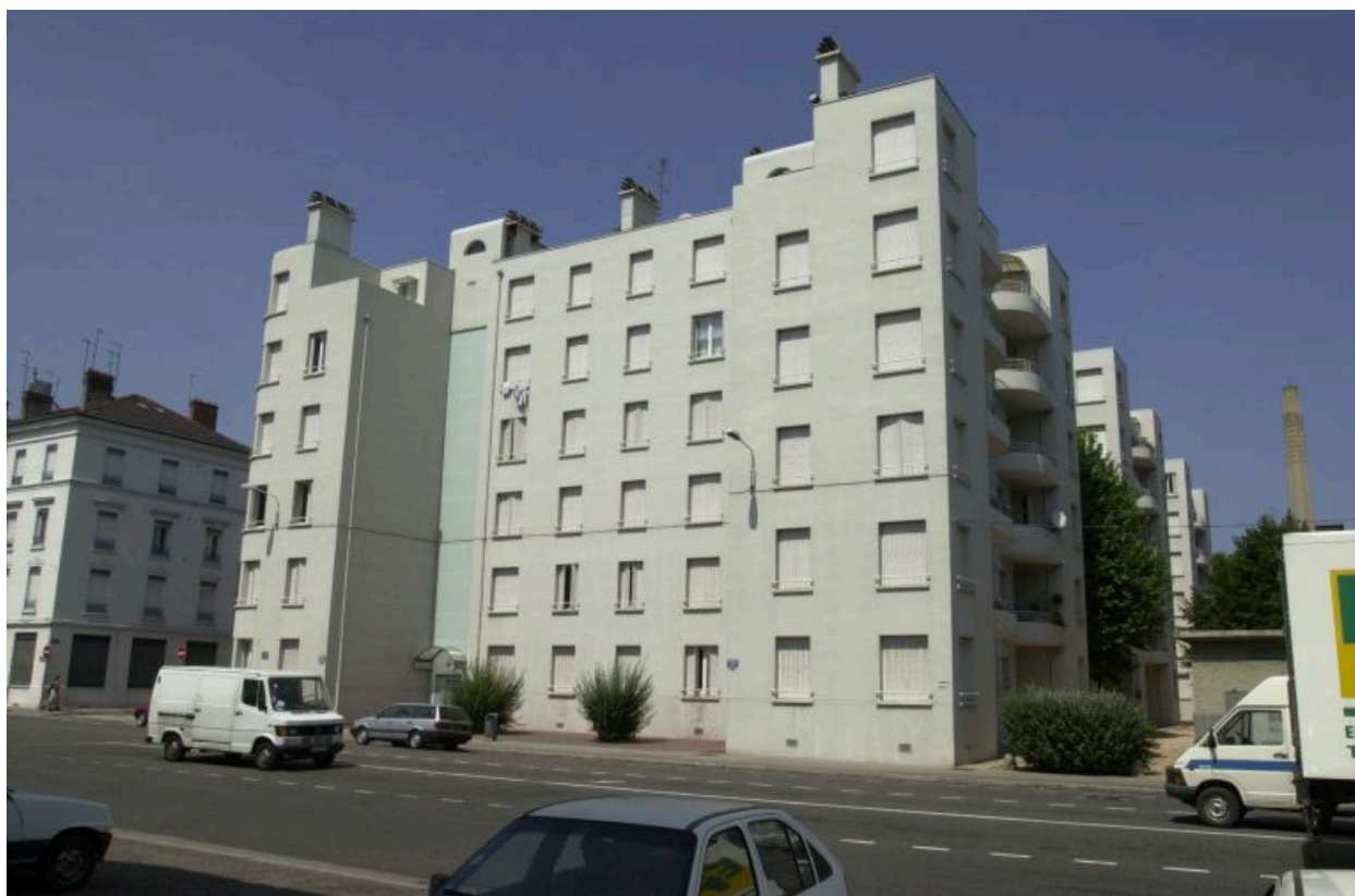
Elévations 39-37 rue Casimir-Perier : les cages d'ascenseur installées à l'angle des corps de bâtiment
