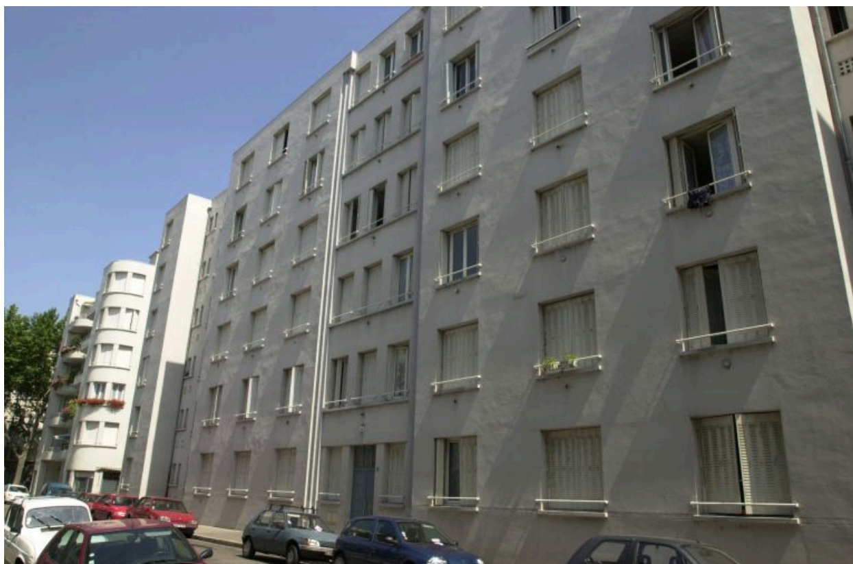
Elévation sur rue, 69 rue Delandine
