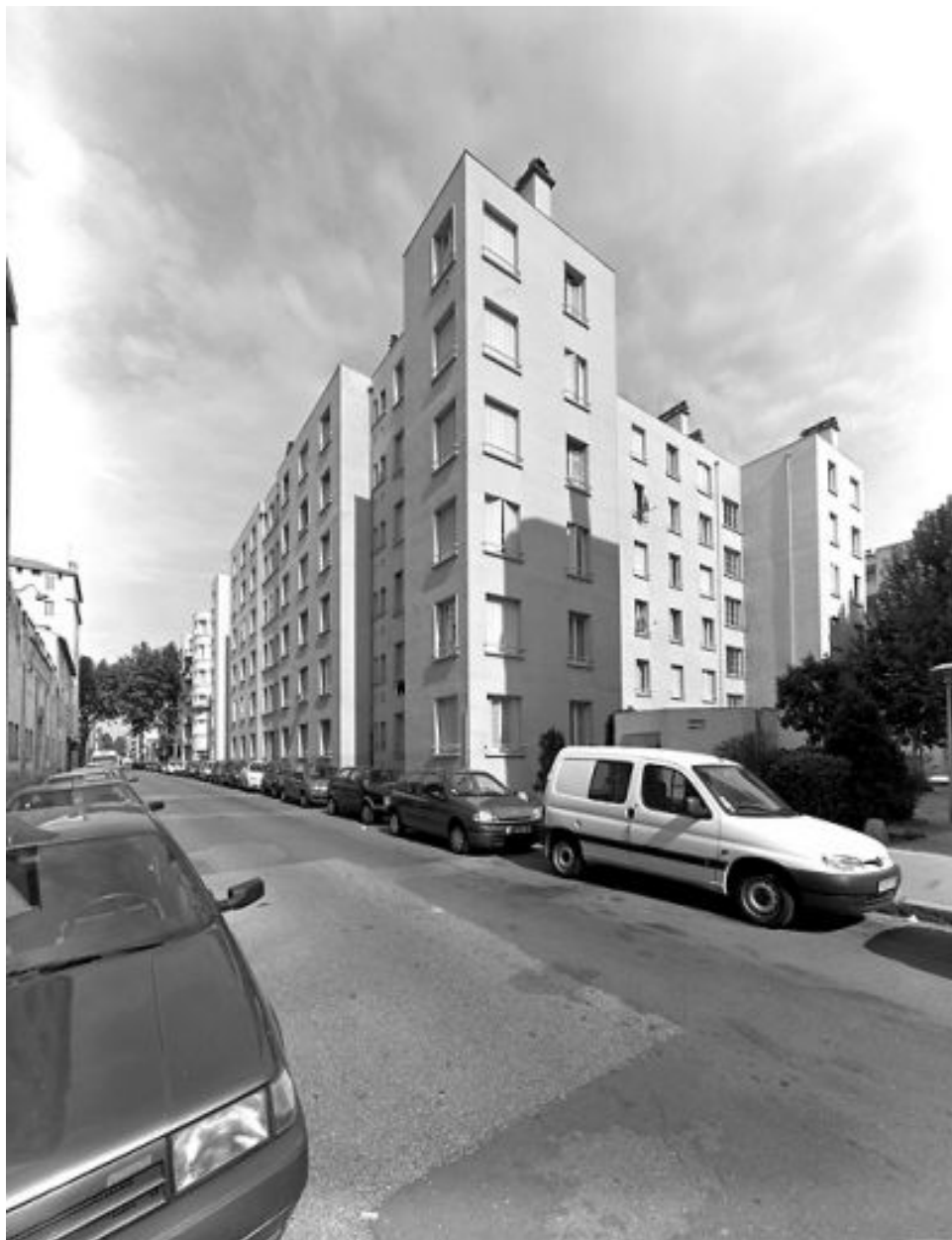
Vue d'ensemble de l'immeuble 69-73 rue Delandine depuis le sud
