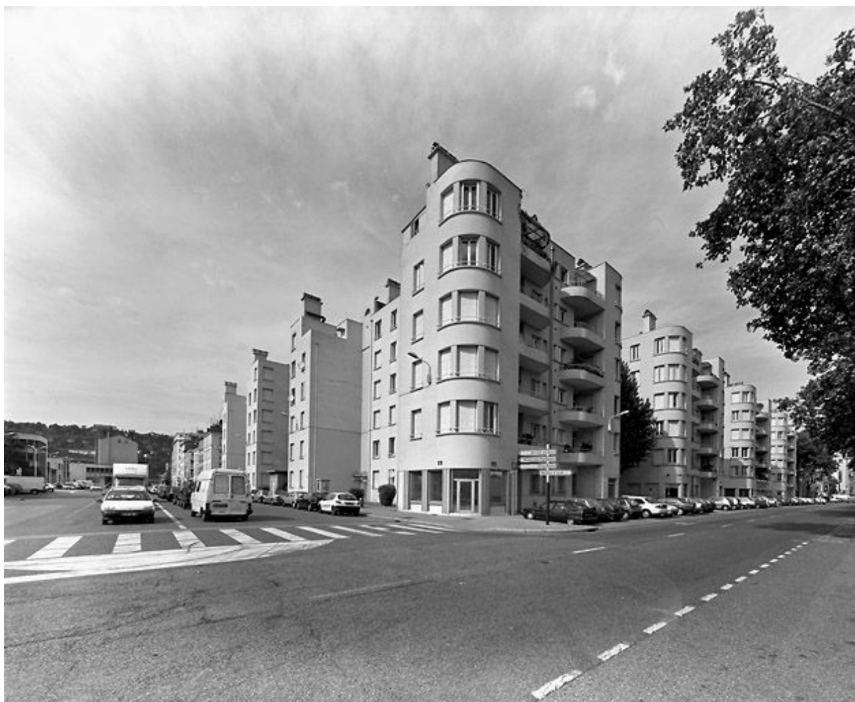
Vue générale depuis le sud-est, à l'angle du quai Perrache et de la rue Casimir-Perier
