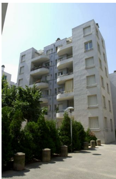
Elévation sur cour Phot. François Blanchetière IVR82_20036900351NUCA
