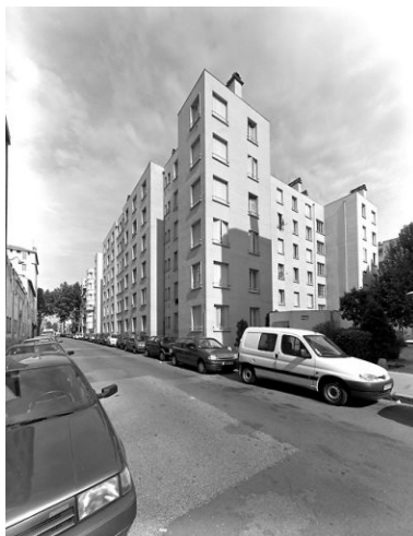
Vue d'ensemble de l'immeuble 69-73 rue Delandine depuis le sud Phot. Jean-Marie Refflé IVR82_20016902460V
