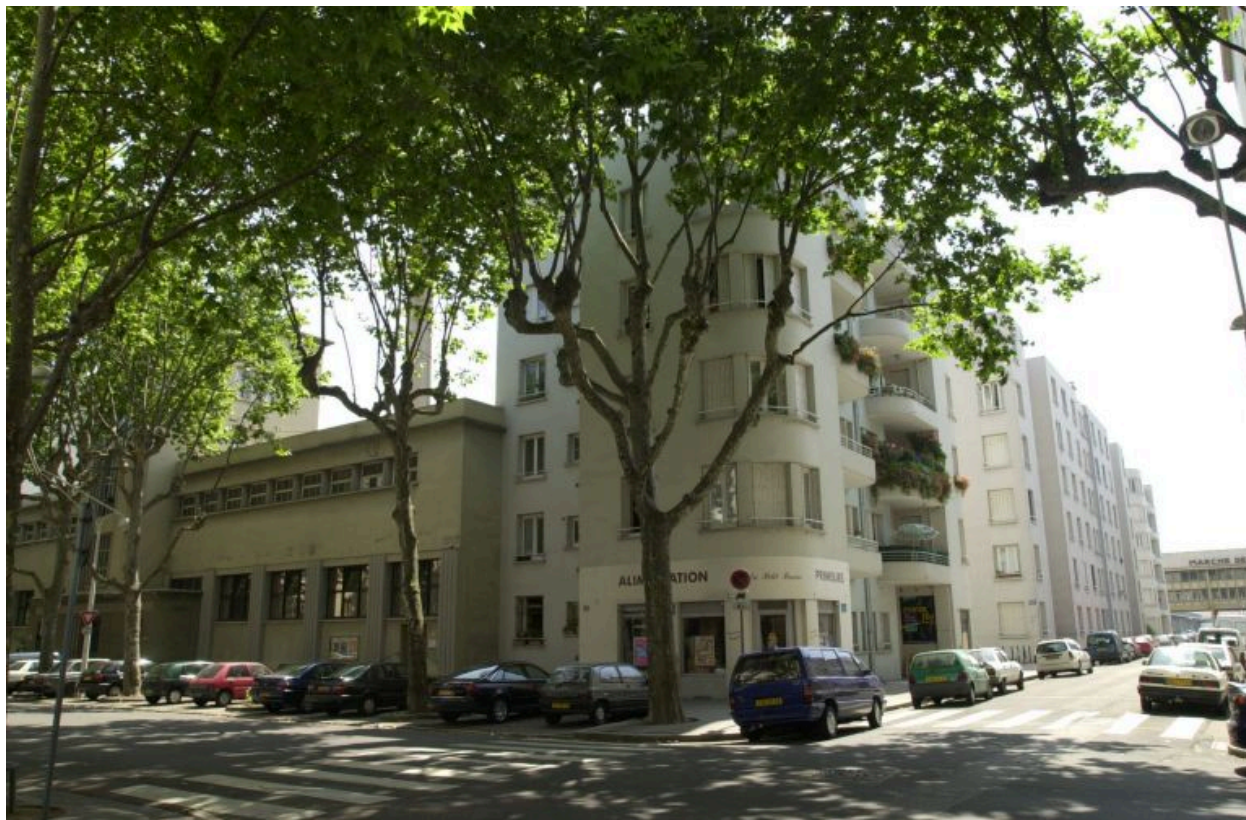
Vue d'ensemble depuis le cours Bayard, le long de la rue Delandine
