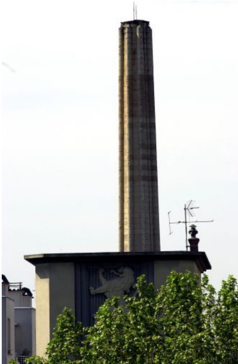
Vue de la cheminée de la chaudière
