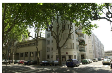
Vue d'ensemble depuis le cours Bayard, le long de la rue Delandine Phot. François Blanchetière IVR82_20026903861NUCA
