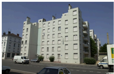
Elévations 39-37 rue Casimir-Perier : les cages d'ascenseur installées à l'angle des corps de bâtiment Phot. François Blanchetière IVR82_20026903862NUCA
