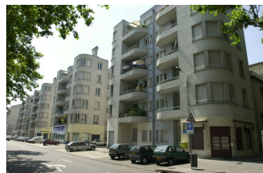
Vue d'ensemble des élévations quai Perrache, depuis le nord Phot. François Blanchetière IVR82_20026903860NUCA
