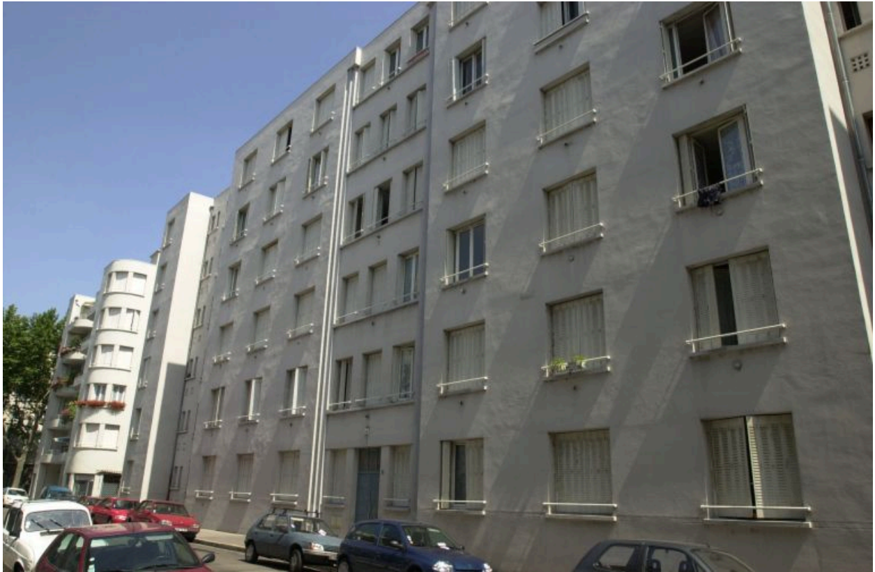
Elévation sur rue, 69 rue Delandine
