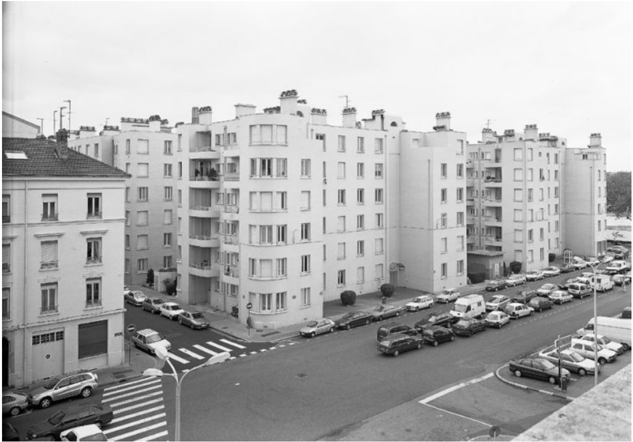
Vue d'ensemble depuis le marché de gros au sud-ouest
