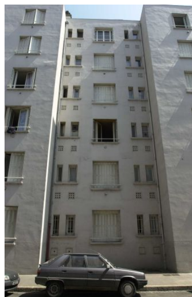
Corps de bâtiment en retrait entre le 71 et le 69 rue Delandine Phot. François Blanchetière IVR82_20026903864NUCA
