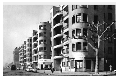
Vue perspective vers le nord. Photogr., 1964. IVR82_20026903873NUCB
