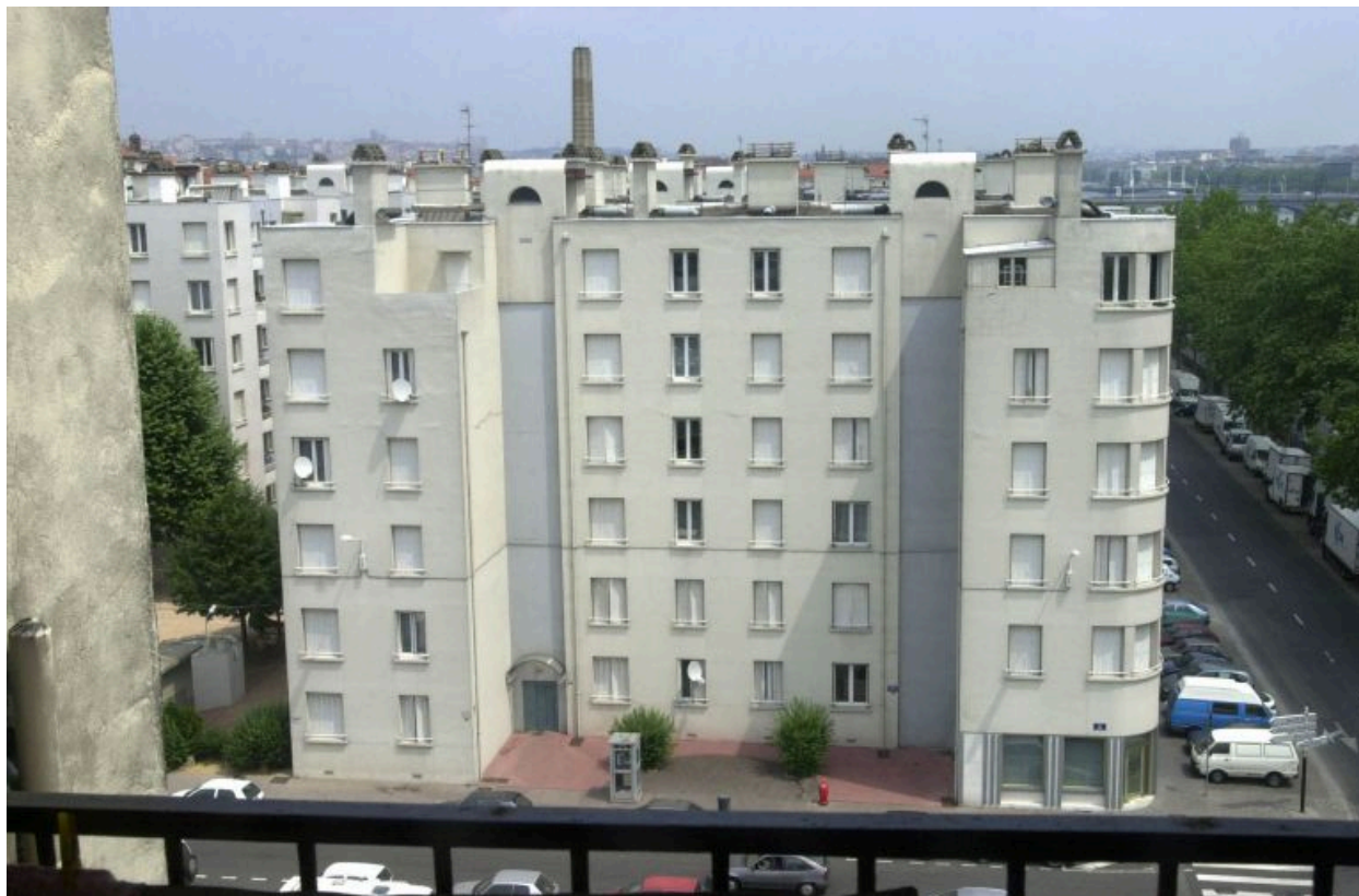
La Cité vue depuis le 42 quai Perrache
