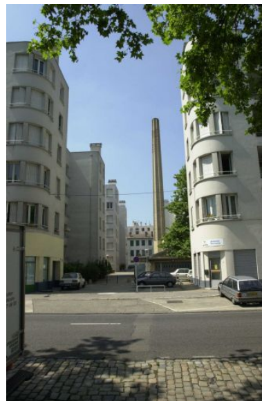
Vue d'ensemble de l'allée centrale depuis le sud Phot. François Blanchetière IVR82_20026903859NUCA
