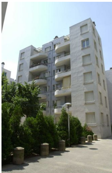
Elévation, 73 rue Delandine Phot. François Blanchetière IVR82_20026903870NUCA
