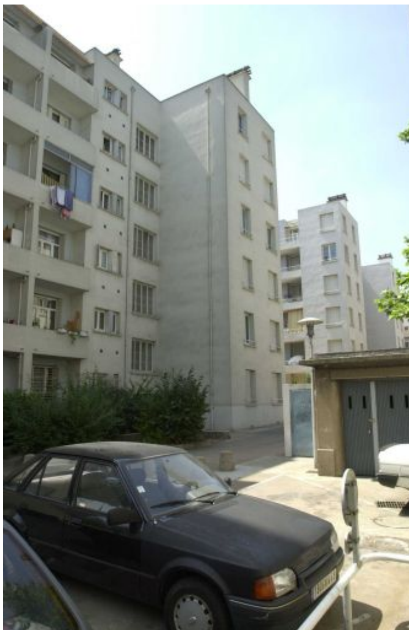
Elévation est du 73 rue Delandine
