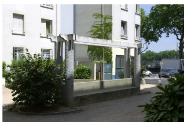
Le mobilier installé dans la cour ouvrant sur le quai Perrache Phot. François Blanchetière IVR82_20026903867NUCA
