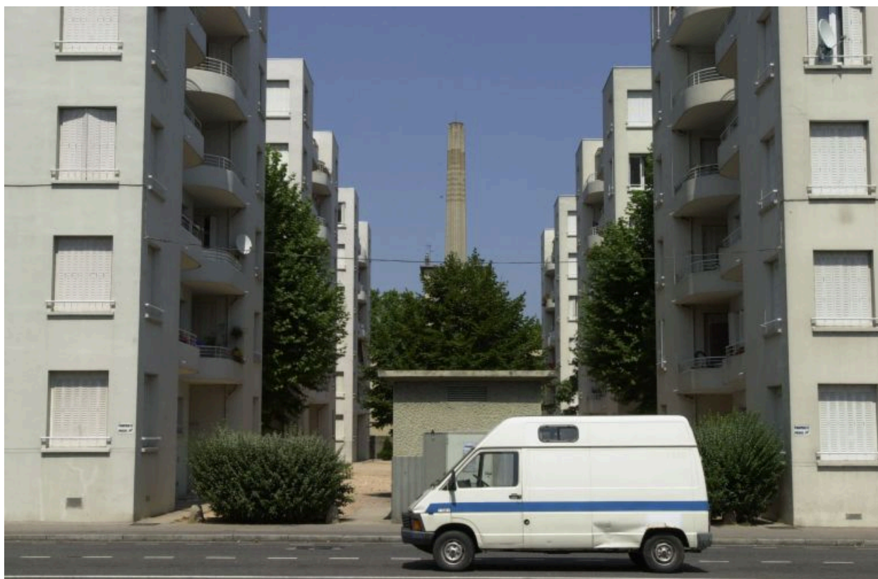
L'allée centrale depuis le sud
