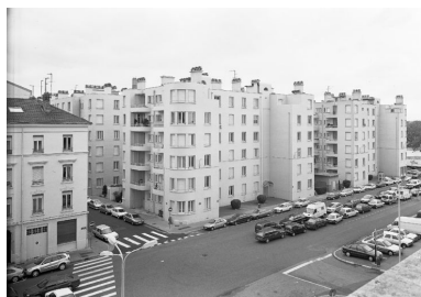
Vue d'ensemble depuis le marché de gros au sud-ouest Phot. Jean-Marie Refflé IVR82_20026900088P
