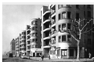
Vue perspective vers le nord. Photogr., 1964. IVR82_20026903873NUCB
