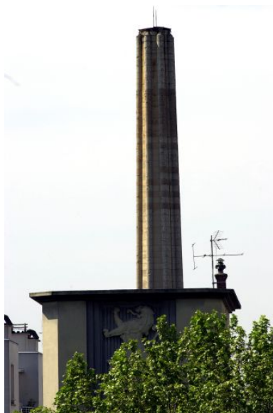
Vue de la cheminée de la chaudière Phot. François Blanchetière IVR82_20016902075NUCA
