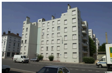
Elévations 39-37 rue Casimir-Perier : les cages d'ascenseur installées à l'angle des corps de bâtiment Phot. François Blanchetière IVR82_20026903862NUCA
