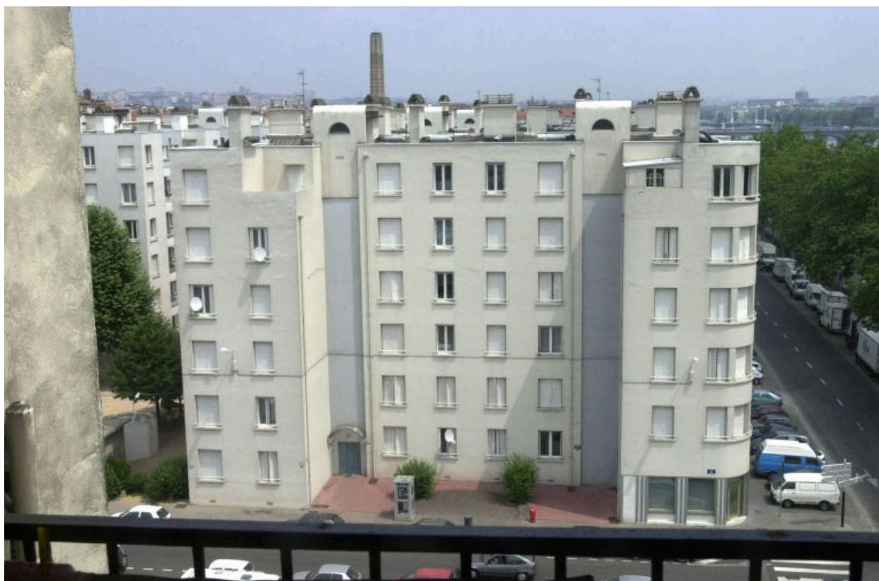
La Cité vue depuis le 42 quai Perrache
