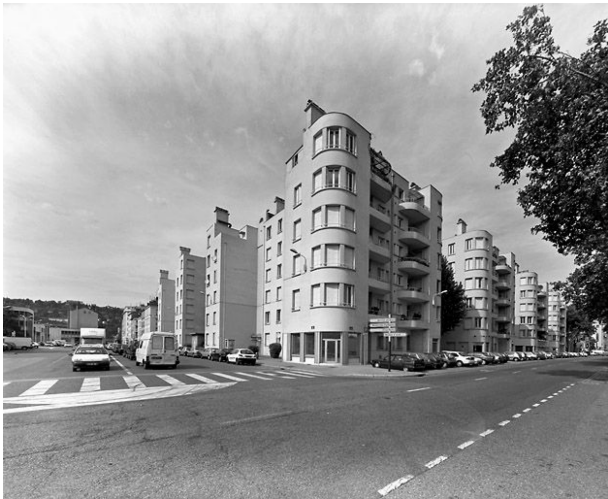
Vue générale depuis le sud-est, à l'angle du quai Perrache et de la rue Casimir-Perier
