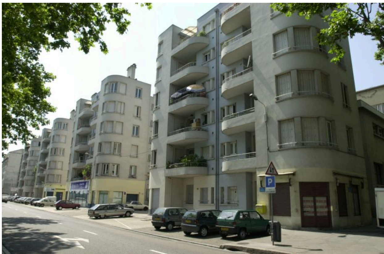
Vue d'ensemble des élévations quai Perrache, depuis le nord
