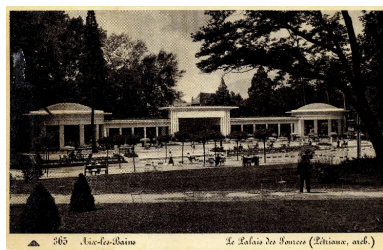
Vue d'ensemble Repro. François Fouger IVR82_20067300144NUCB
