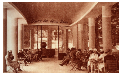
Vue intérieure, côté gauche Repro. François Fouger IVR82_20067300148NUCB
