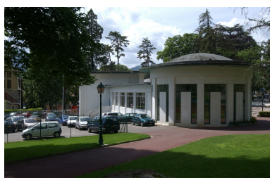
Vue prise du sud-est Phot. François Fouger IVR82_20067300659NUCA
