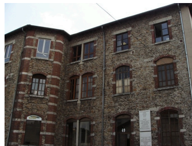
détail façade Phot. Benoît Chapelle IVR82_20073800130NUCA
