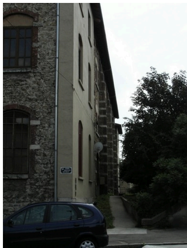
façade arrière Phot. Benoît Chapelle IVR82_20073800132NUCA
