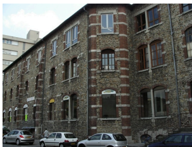
façade nord Phot. Benoît Chapelle IVR82_20073800126NUCA
