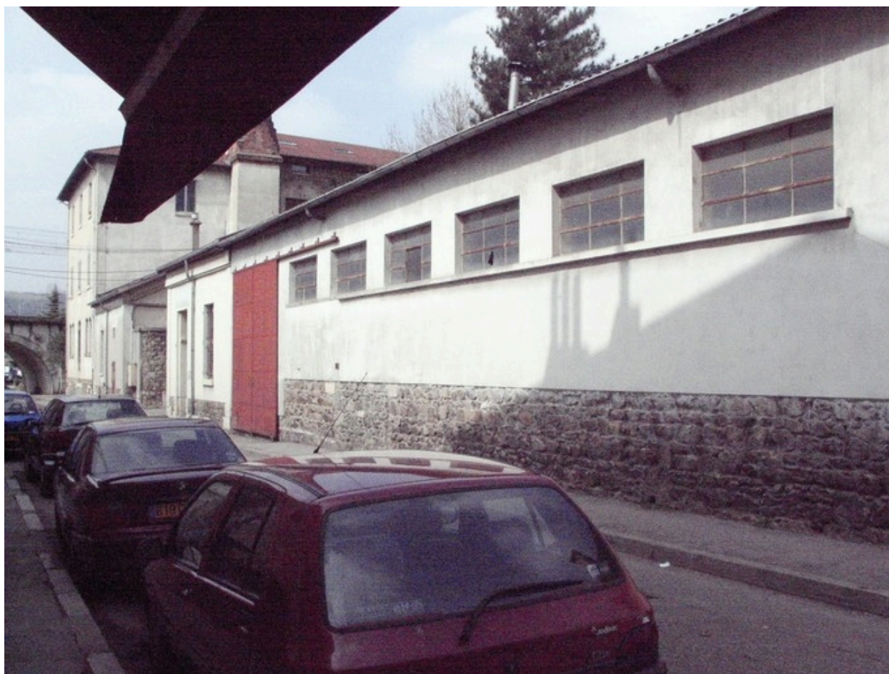
façade sud parcelle 299
