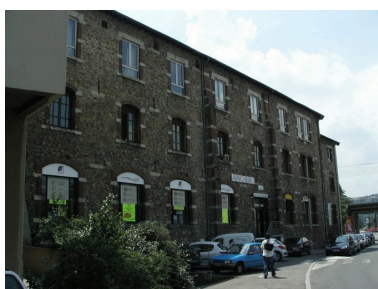
façade nord Phot. Benoît Chapelle IVR82_20073800129NUCA
