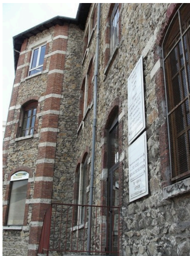
détail façade Phot. Benoît Chapelle IVR82_20073800133NUCA
