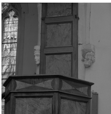
Détail de deux culots de retombée de nervures de part et d'autre du 2e pilier sud de la nef. Phot. Eric Dessert IVR82_20014200482X
