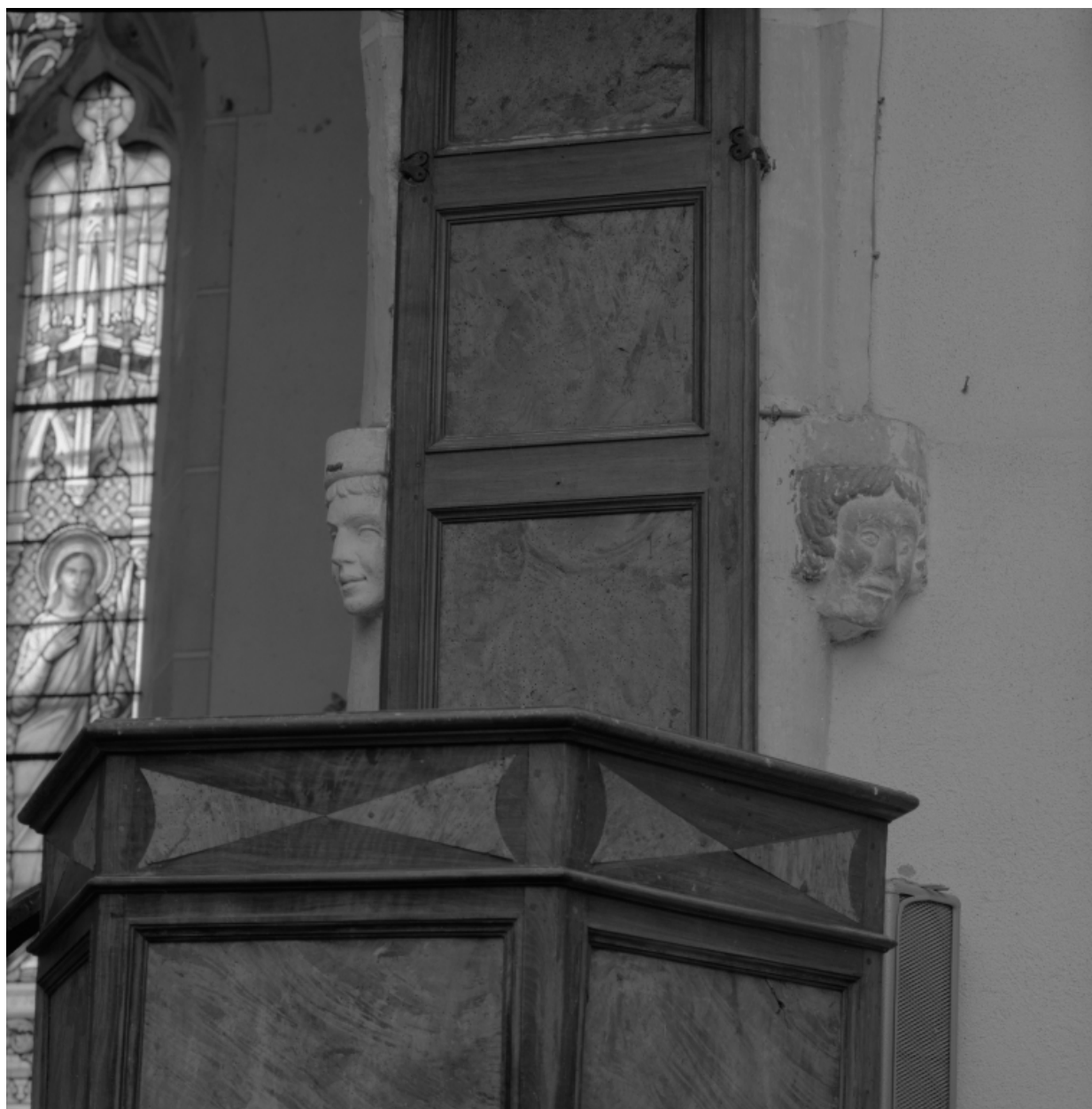
Détail de deux culots de retombée de nervures de part et d'autre du 2e pilier sud de la nef.
