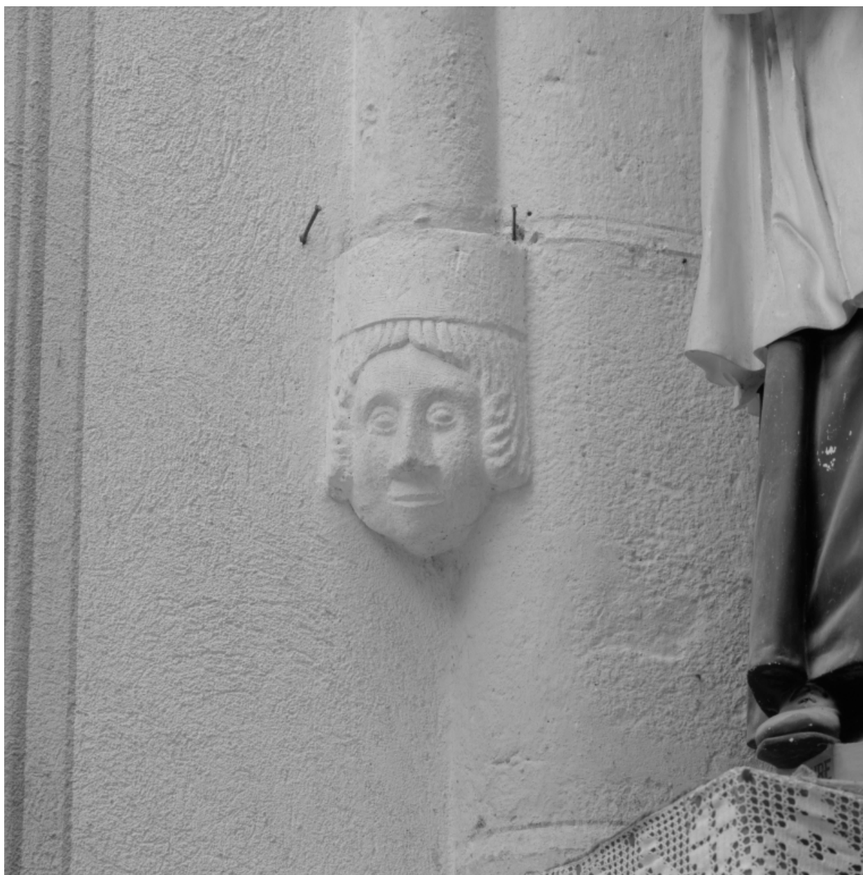
Détail d'un culot de retombée d'une nervure de la voûte à l'angle sud-est du bras nord du transept.
