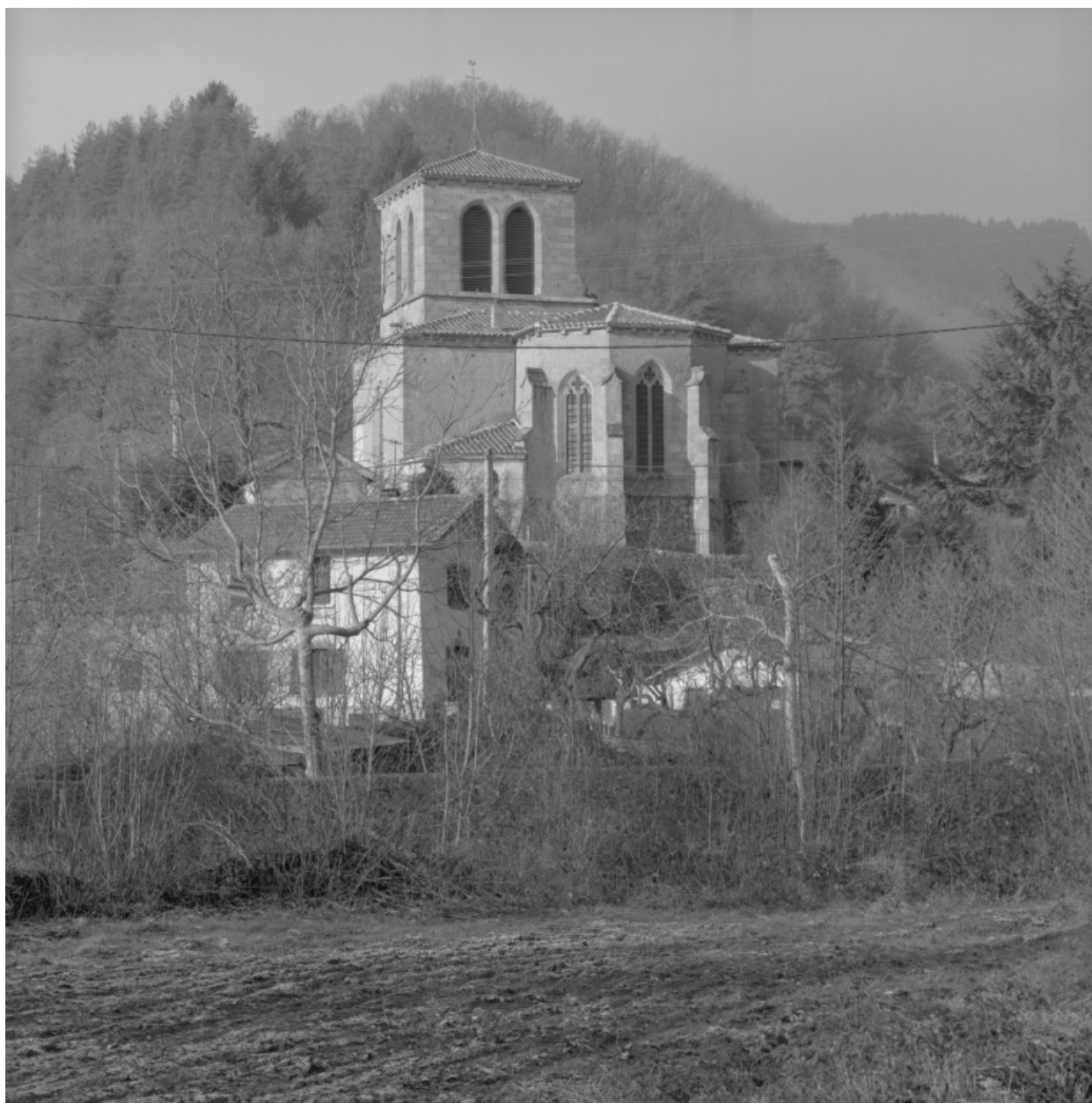
Vue d'ensemble de l'église depuis l'est.
