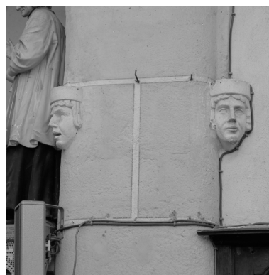
Détail de deux culots de retombée de nervures de part et d'autre du 3e pilier nord. Phot. Eric Dessert IVR82_20014200483X
