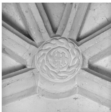
Détail de la clef de voûte de l'abside. Phot. Eric Dessert IVR82_20014200478X
