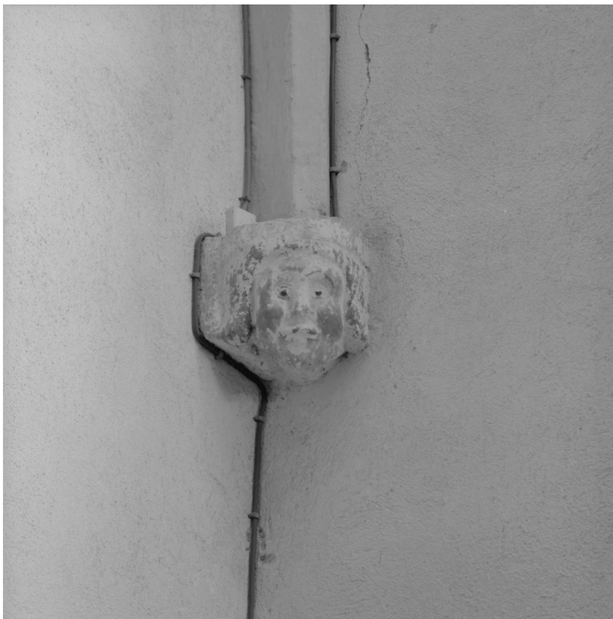
Détail d'un culot de retombée d'une nervure de la voûte à l'angle nord-ouest de la 2e travée.
