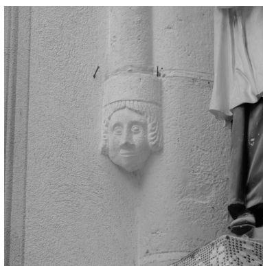
Détail d'un culot de retombée d'une nervure de la voûte à l'angle sud-est du bras nord du transept. Phot. Eric Dessert IVR82_20014200481X
