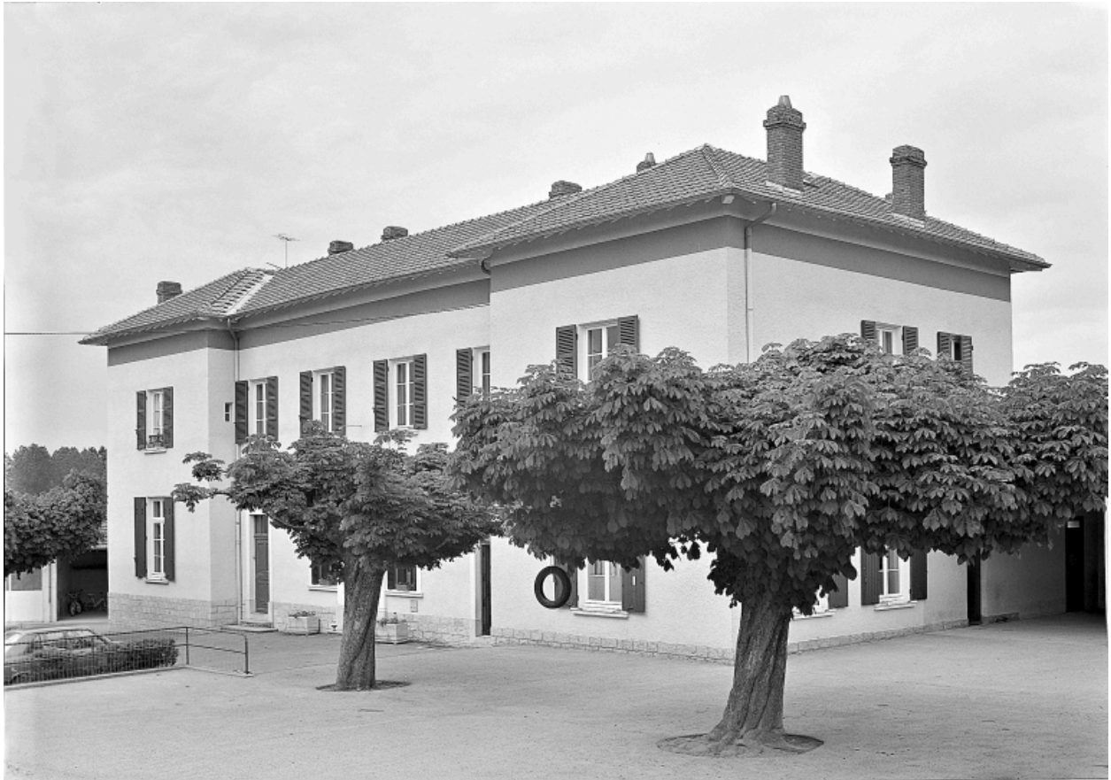
Vue du sud-ouest.
