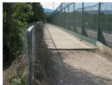
Premier ponceau : vue de la chaussée Phot. I. Havard IVR82_20103800054NUCA
