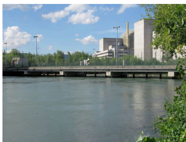
Premier ponceau : vue générale, face amont Phot. I. Havard IVR82_20103800053NUCA
