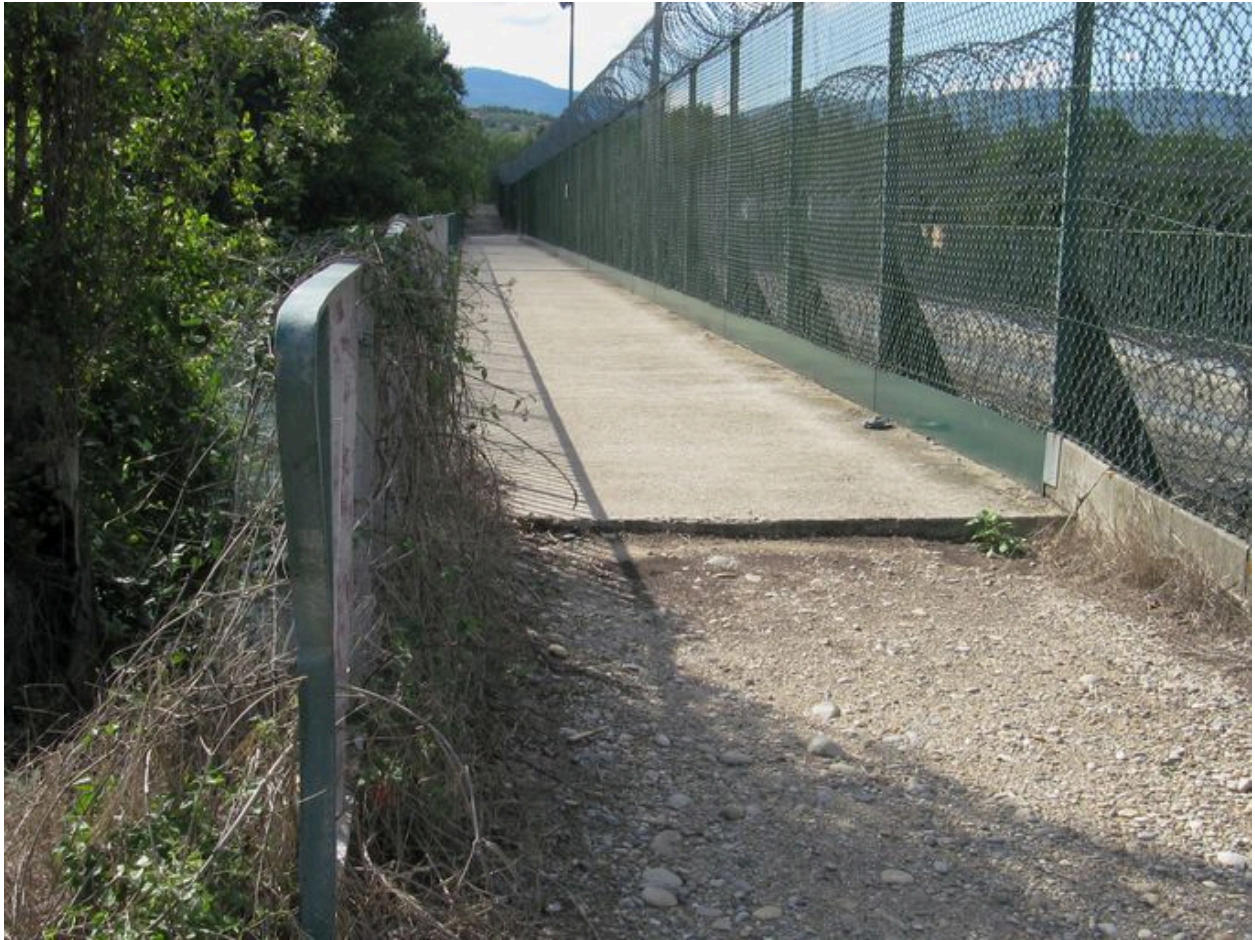
Premier ponceau : vue de la chaussée
