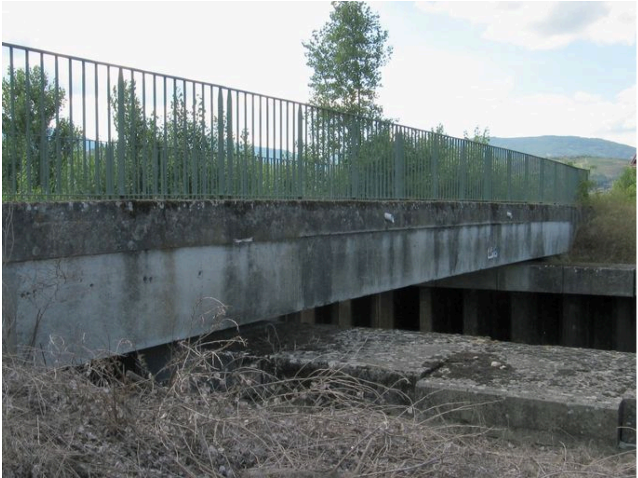
Second ponceau : vue générale, face amont
