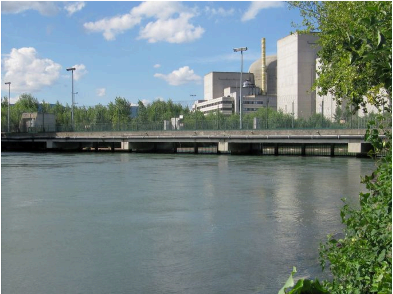
Premier ponceau : vue générale, face amont
