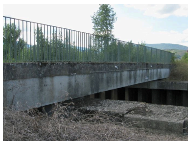
Second ponceau : vue générale, face amont Phot. I. Havard IVR82_20103800080NUCA
