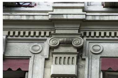
Façade principale rue de Brest, 3e niveau, 4e pilastre, détail du chapiteau ionique Phot. Bernard Ducouret IVR82_20046900913NUCA
