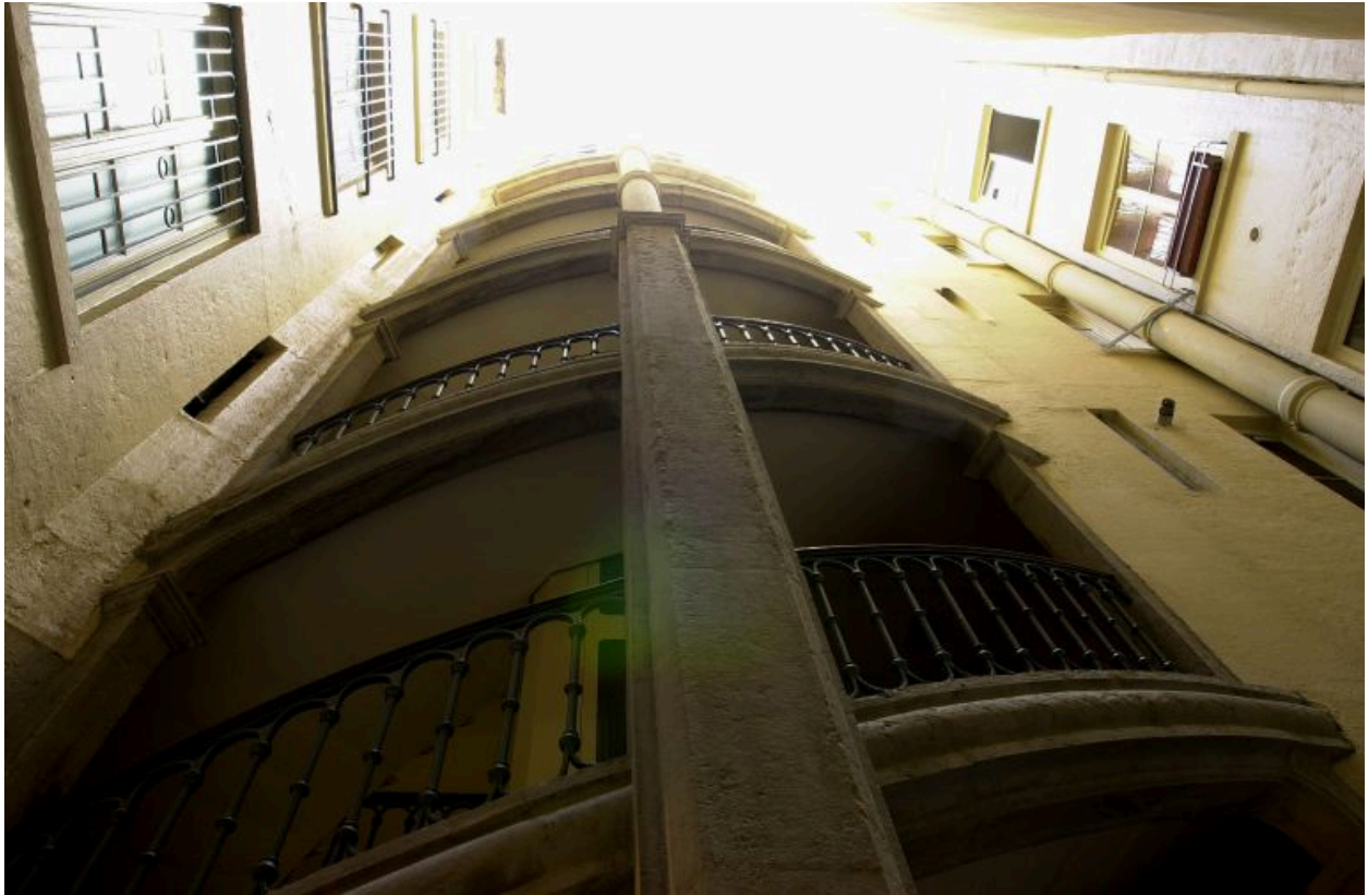
Cour et cage d'escalier vues par-dessous
