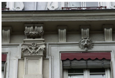
Façade principale rue de Brest, 5e niveau, 4e pilastre, détail du chapiteau composite Phot. Bernard Ducouret IVR82_20046900915NUCA
