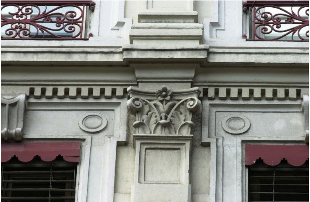
Façade principale rue de Brest, 4e niveau, 4e pilastre, détail du chapiteau corinthien
