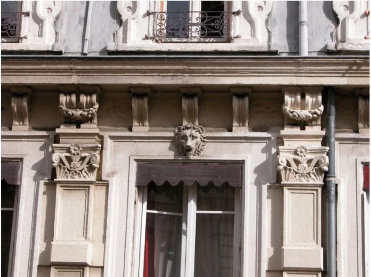
Façade rue Dubois, 5e niveau, détail de la 3e fenêtre
