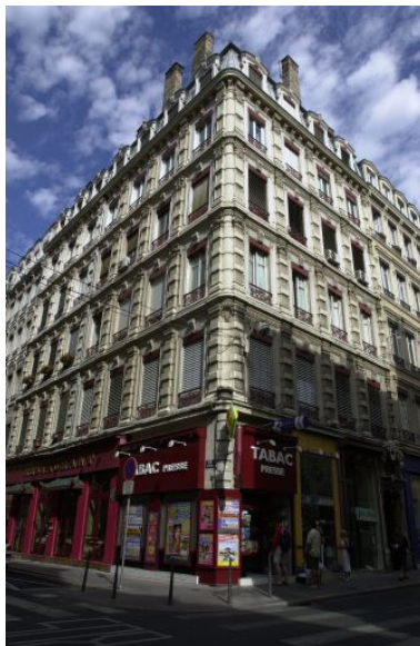
Vue générale des façades Phot. Bernard Ducouret IVR82_20046900909NUCA
