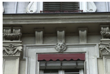
Façade principale rue de Brest, 5e niveau, détail de la 3e fenêtre et de la corniche Phot. Bernard Ducouret IVR82_20046900916NUCA
