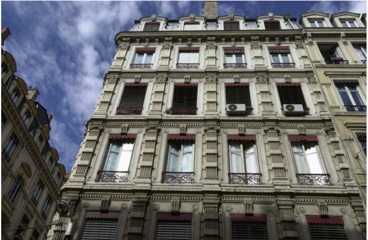
Façade principale rue de Brest, vue par-dessous
