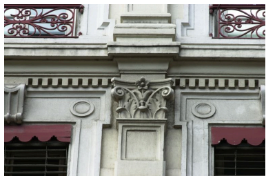
Façade principale rue de Brest, 4e niveau, 4e pilastre, détail du chapiteau corinthien Phot. Bernard Ducouret IVR82_20046900914NUCA
