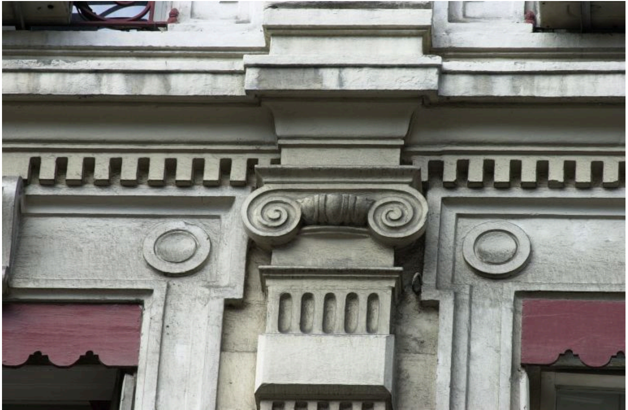
Façade principale rue de Brest, 3e niveau, 4e pilastre, détail du chapiteau ionique
