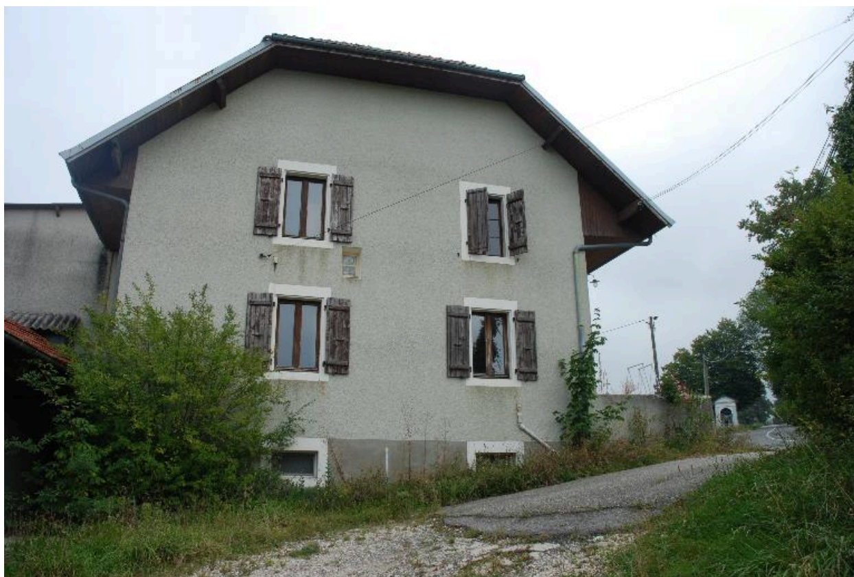
Vue latérale sud.
