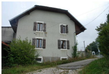
Vue latérale sud. Phot. Caroline Guibaud IVR84_20167304672NUCA
