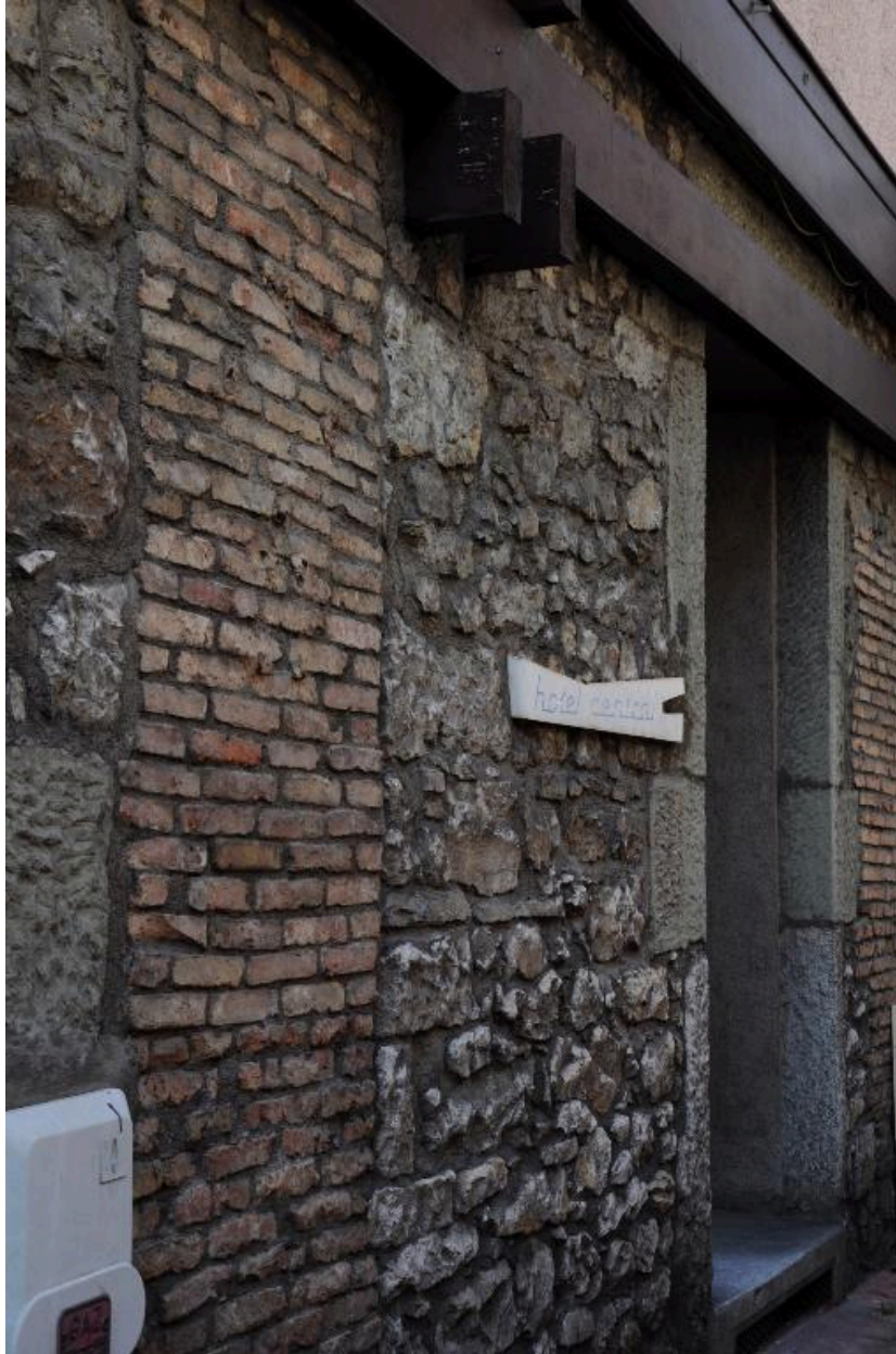
Enseigne de l'hôtel et détail sur l'appareil en moellons de pierre et briques, rue de la Dent-du-Chat
