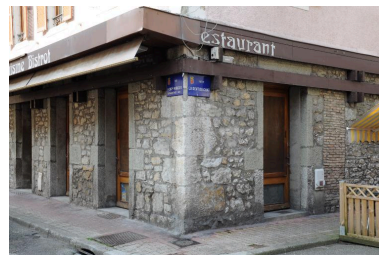
Appareil du rez-de-chaussée, chaîne d'angle en pierre et encadrement en molasse Phot. Denys Harreau IVR82_20147301121NUCA
