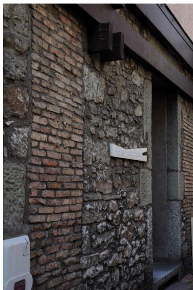
Enseigne de l'hôtel et détail sur l'appareil en moellons de pierre et briques, rue de la Dent-du-Chat Phot. Denys Harreau IVR82_20147301122NUCA
