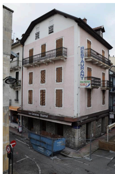
Vue de trois-quart, angle des rues Henri Murger et de la Dent-du-Chat Phot. Denys Harreau IVR82_20147300152NUCA
