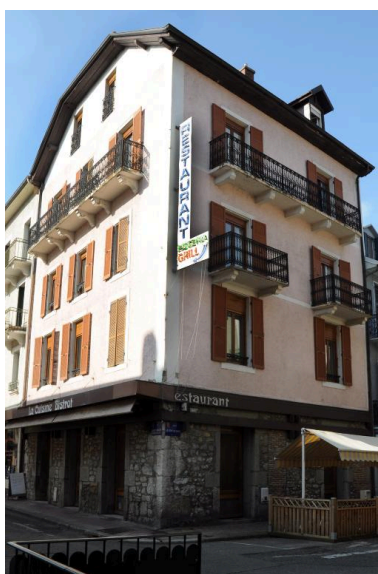
Vue générale Phot. Denys Harreau IVR82_20147301120NUCA
