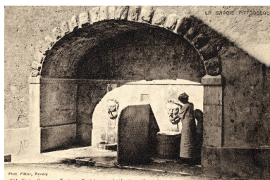
Vue d'ensemble Repro. François Fouger IVR82_20087300805NUCB
