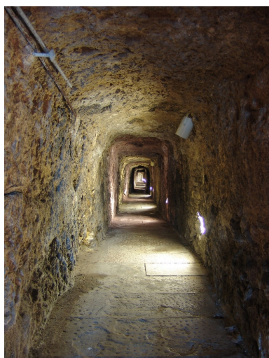
Galerie d'accès à la source Phot. François Fouger IVR82_20067300417NUCA
