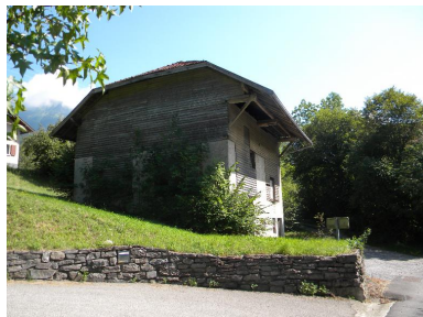
Vue d'ensemble. Phot. Jérôme Daviet IVR82_20137401909NUCA
