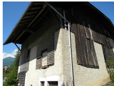
Vue de trois-quarts. Phot. Jérôme Daviet IVR82_20137401911NUCA
