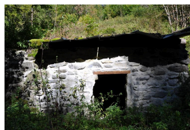
Rez-de-chaussée du bâtiment de la scierie transformée en remise Phot. Samir Mahfoudi IVR84_20167400008NUCA
