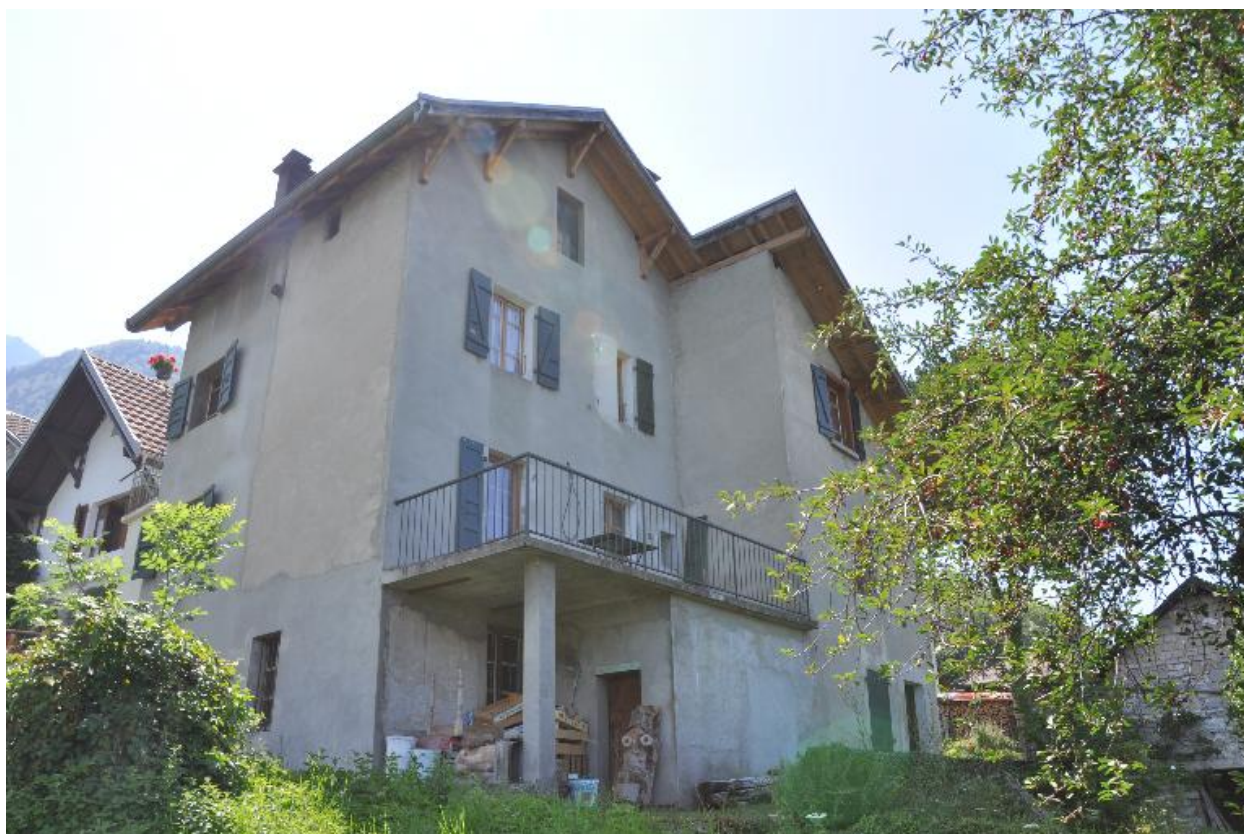
Mur pignon nord du troisième moulin
