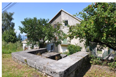
Vestiges des salles d'eau aménagées en amont des moulins Phot. Samir Mahfoudi IVR82_20177400196NUCA
