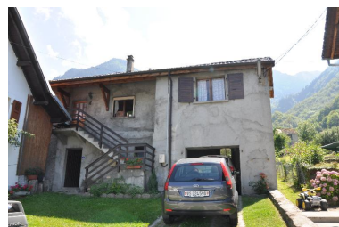
Façade antérieure du premier moulin situé plus en amont de la prise d'eau Phot. Samir Mahfoudi IVR82_20157500019NUCA
