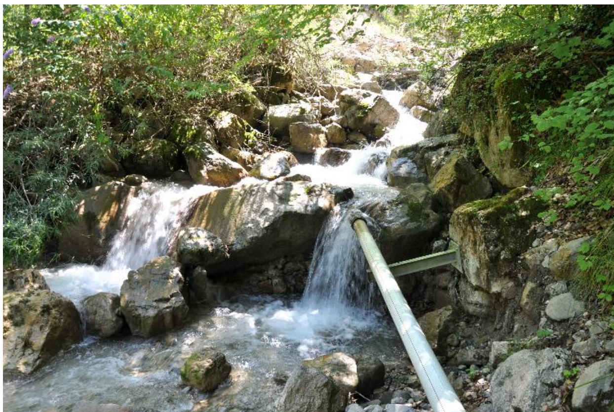
Vue du barrage alimentant la prise d'eau des moulins de Locum
