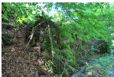
Vestiges d'un mur de soutènement traduisant la présence d'un aménagement en amont Phot. Samir Mahfoudi IVR82_20177400191NUCA
