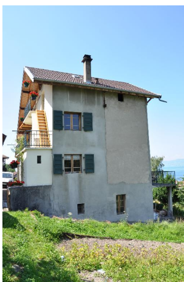
Façade latérale est d'un ancien moulin Phot. Samir Mahfoudi IVR82_20177400194NUCA
