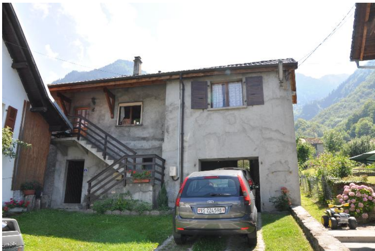
Façade antérieure du premier moulin situé plus en amont de la prise d'eau
