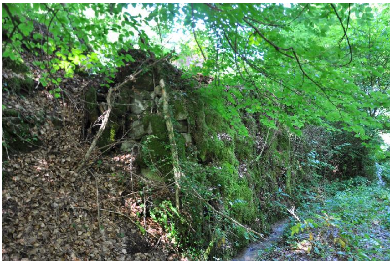
Vestiges d'un mur de soutènement traduisant la présence d'un aménagement en amont
