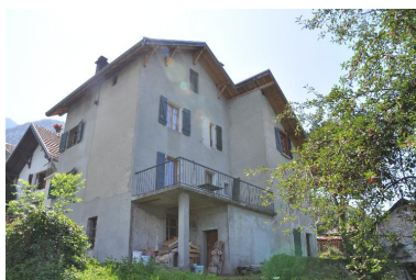
Mur pignon nord du troisième moulin Phot. Samir Mahfoudi IVR82_20157500018NUCA
