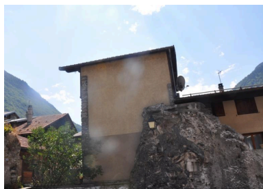
Façade nord de l'ancien moulin-scierie Collomb le long de laquelle passait la dérivation. Phot. Clara Bérelle IVR84_20167302466NUCA
