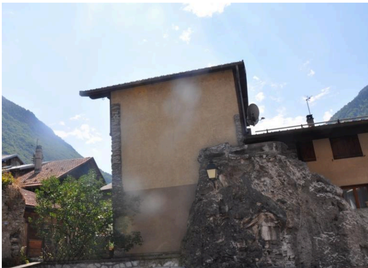
Façade nord de l'ancien moulin-scierie Collomb le long de laquelle passait la dérivation.
