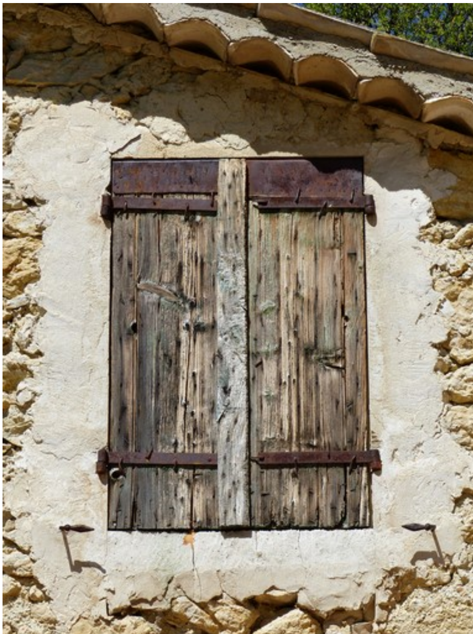
Partie est. Pignon sud, second niveau. Fenêtre occultée avec des contrevents en planches croisées.
