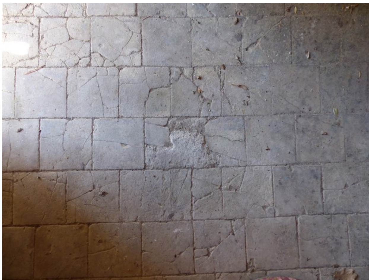
Partie est. Etage de comble, chambre. Sol en carreaux de terre cuite.
