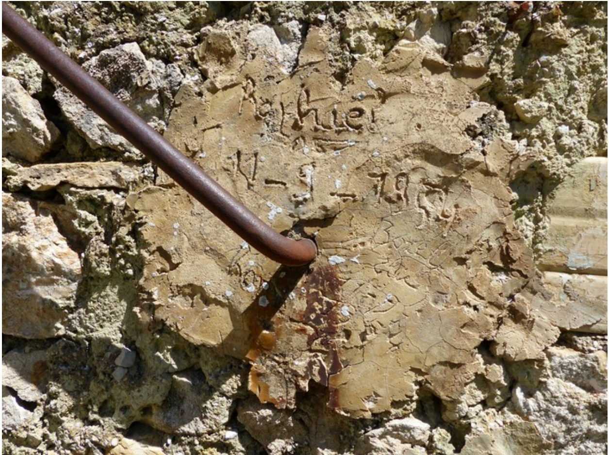
Partie est. Pignon sud, escalier extérieur. Date gravée dans le scellement de la main courante : « Raphaël 11-9-1954 / Borel Elie 11-9-1954 / Raphaël ».
