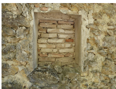
Partie est. Pignon nord, jour muré. Phot. Alexeï Laurent IVR84_20162600673NUCA
