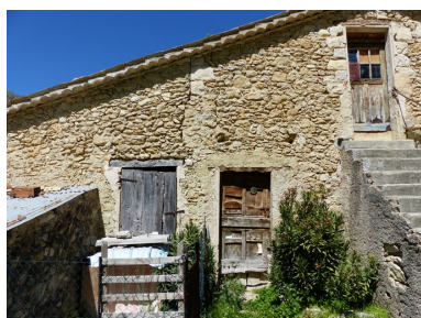
Pignon sud, collage de maçonnerie et surélévation de la partie ouest. Phot. Alexeï Laurent IVR84_20162600660NUCA
