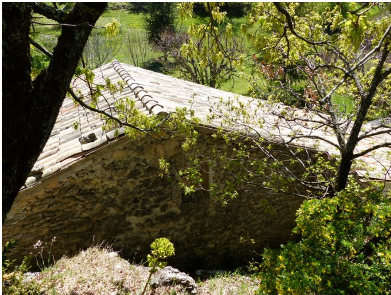
Partie est. Pignon nord.
