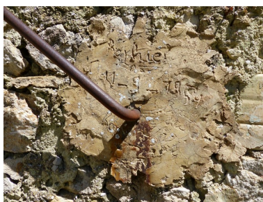
Partie est. Pignon sud, escalier extérieur. Date gravée dans le scellement de la main courante : « Raphaël 11-9-1954 / Borel Elie 11-9-1954 / Raphaël ».
