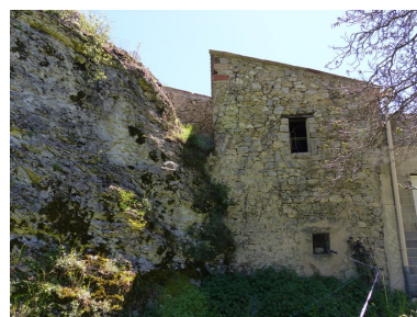
Partie ouest. Pignon nord. Phot. Alexeï Laurent IVR84_20162600671NUCA
