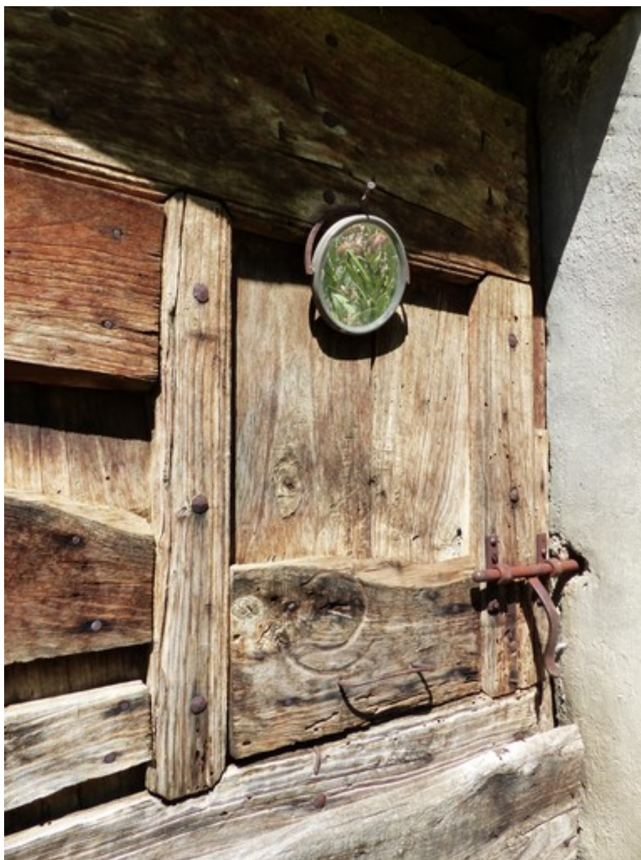
Pignon sud, premier niveau. Porte du logis, détail de la menuiserie.
