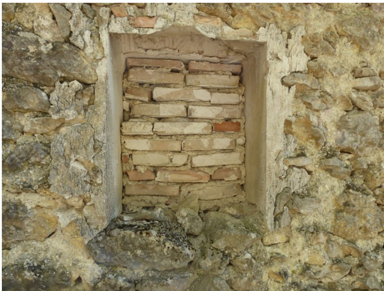
Partie est. Pignon nord, jour muré.
