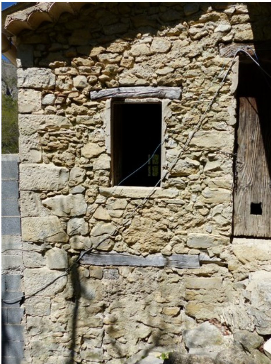
Partie ouest. Pignon sud, deuxième niveau. Fenêtre.
