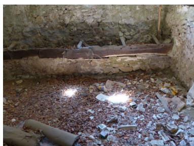
Partie ouest. Premier étage de soubassement, étable. Mur sud, mangeoire. Phot. Alexeï Laurent IVR84_20162600675NUCA
