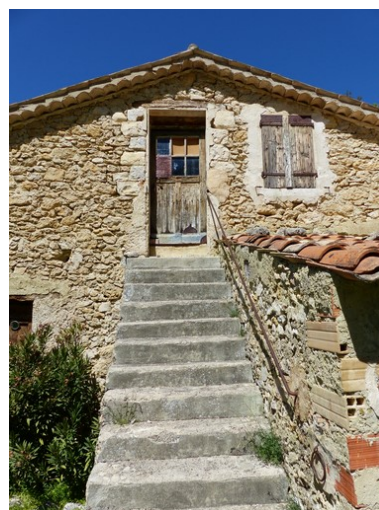
Partie est. Pignon sud, escalier extérieur. Phot. Alexeï Laurent IVR84_20162600662NUCA
