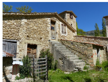
Partie est. Pignon sud. Phot. Alexeï Laurent IVR84_20162600659NUCA
