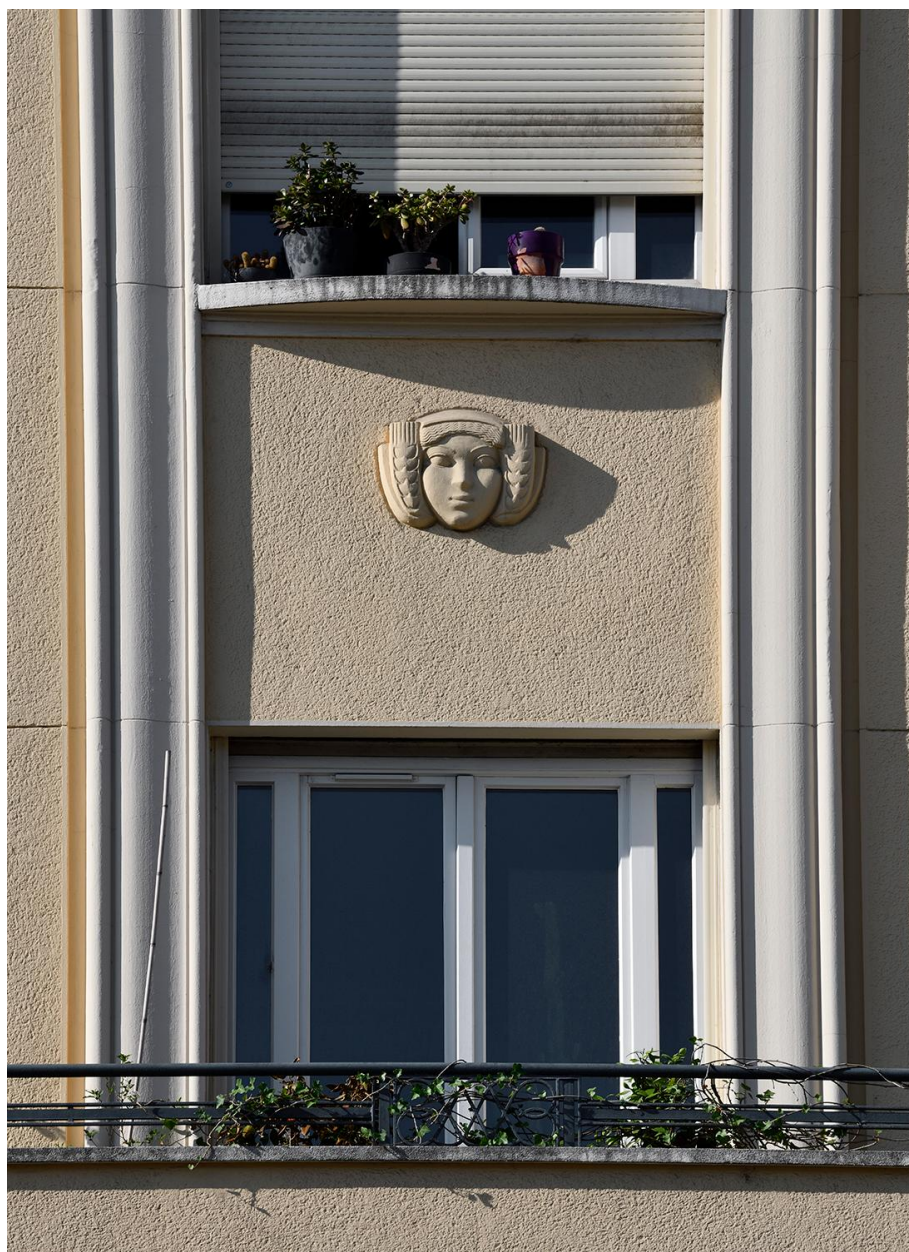
Elévation avenue des Frères-Lumière : ornementation
